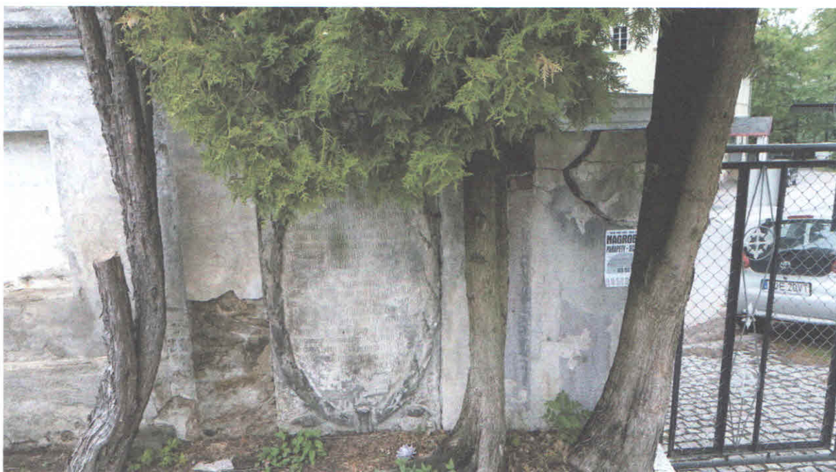
Fot,14, Stan zachowania obiektu przed konserwacją. 2018r.
