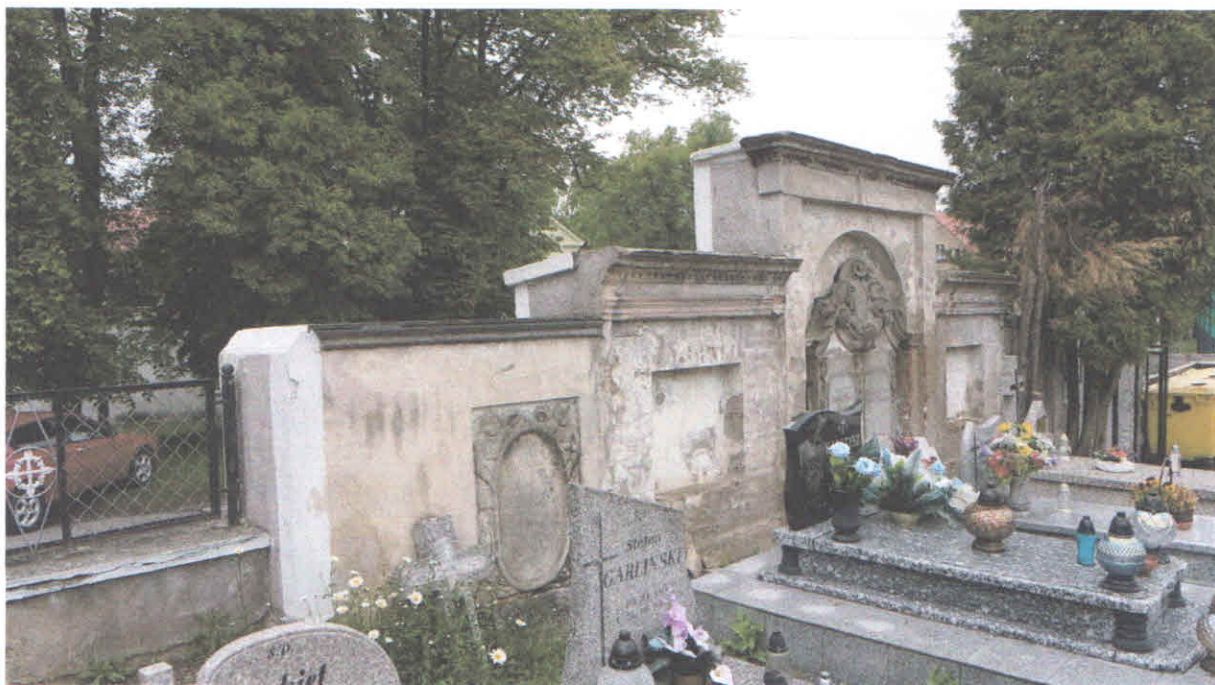
Fot,13, Stan zachowania obiektu przed konserwacją. 2018r.
