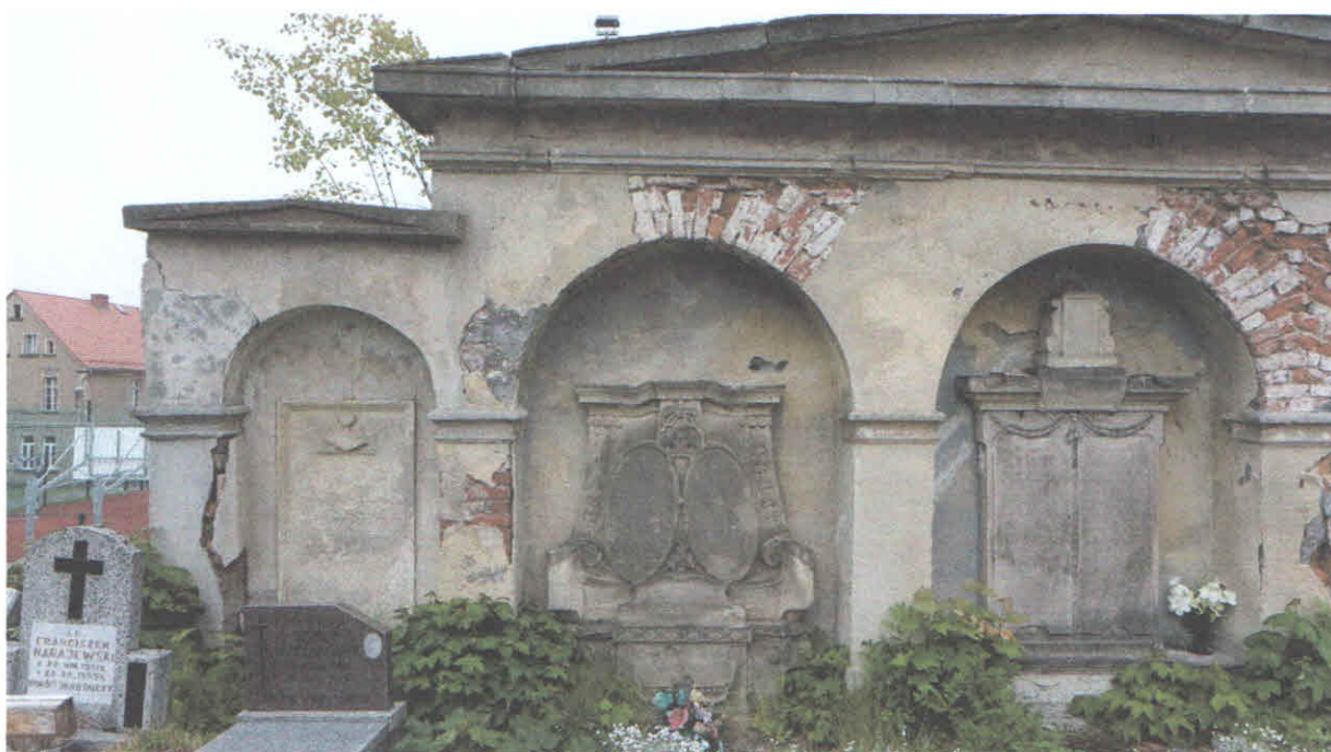
Fot,20, Stan zachowania obiektu przed konserwacją. 2018r.
