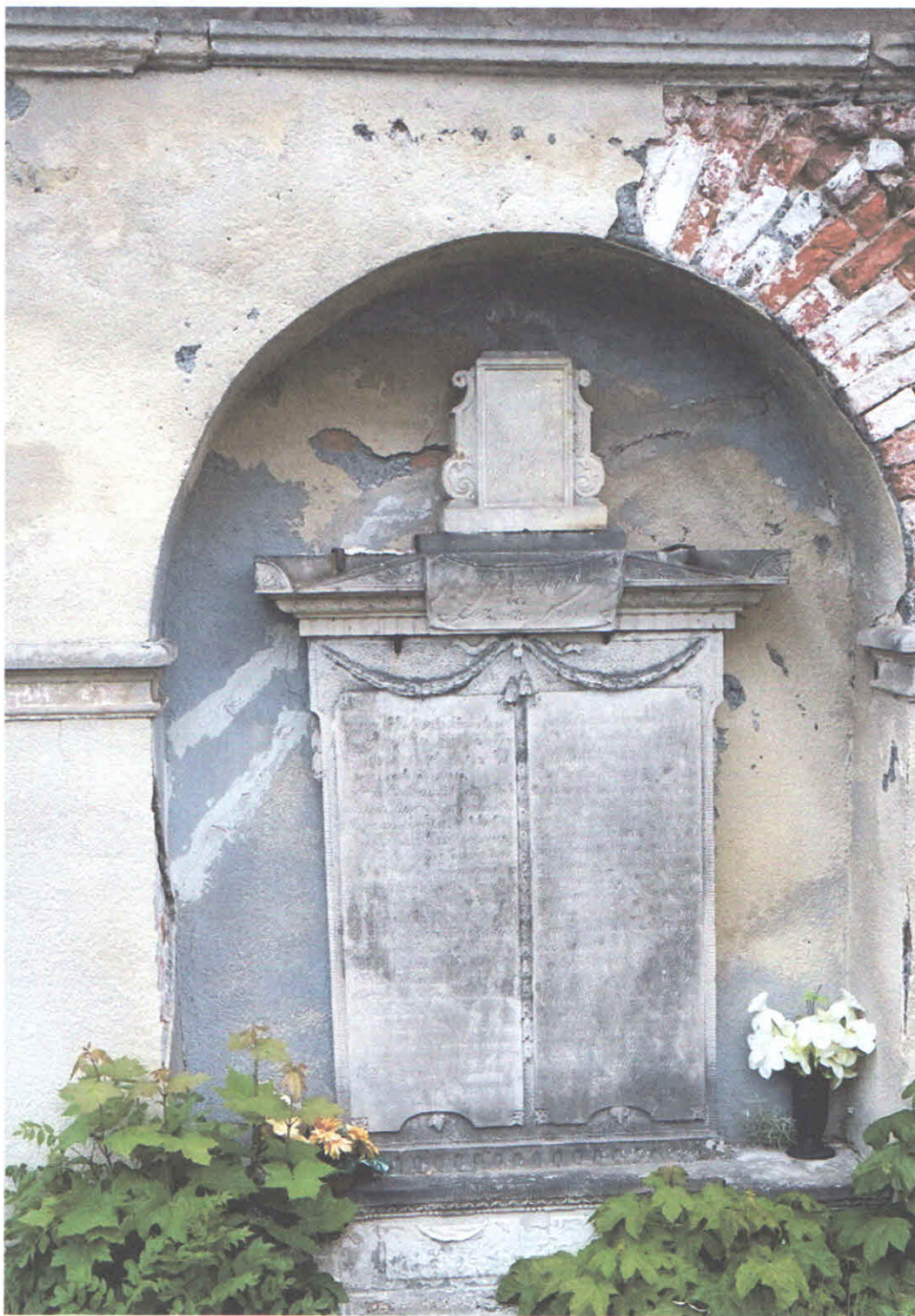
Fot,23, Stan zachowania obiektu przed konserwacją. 2018r.
