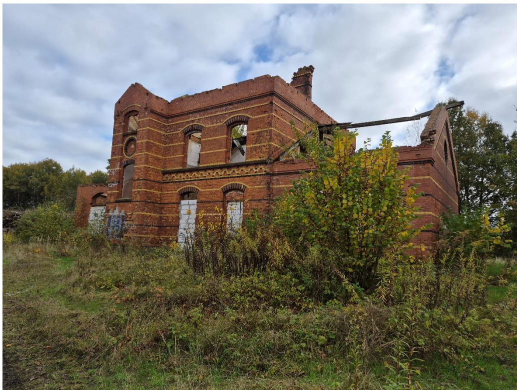
Pozostałość budynku stacji kolejowej
