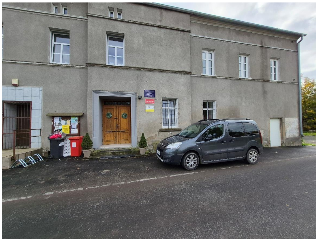
Budynek świetlicy wiejskiej
