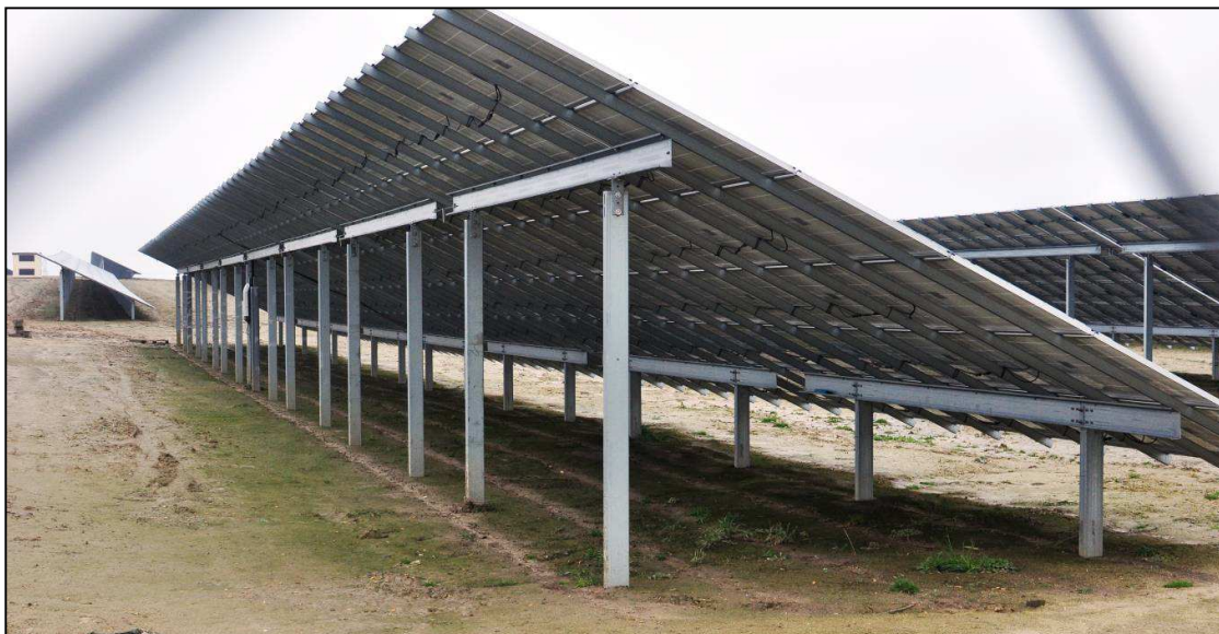
Fot.7: Jeden ze sposobów umocowania modułów fotowoltaicznych na fundamentach słupowych. (Fot. własna, Czerwony Kościół dn. 9 marca 2016 r.)
