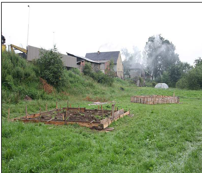
Budowa altany i mini-sceny
