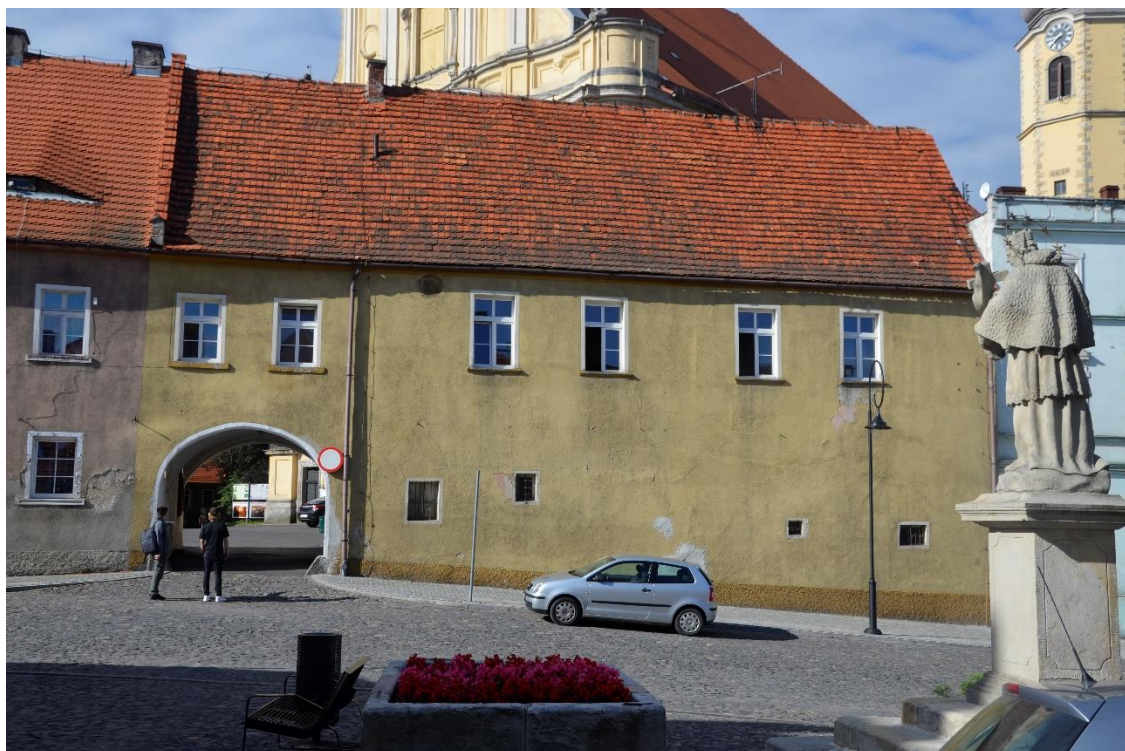
Widok na budynek przeznaczony do remontu-elewacja północna
