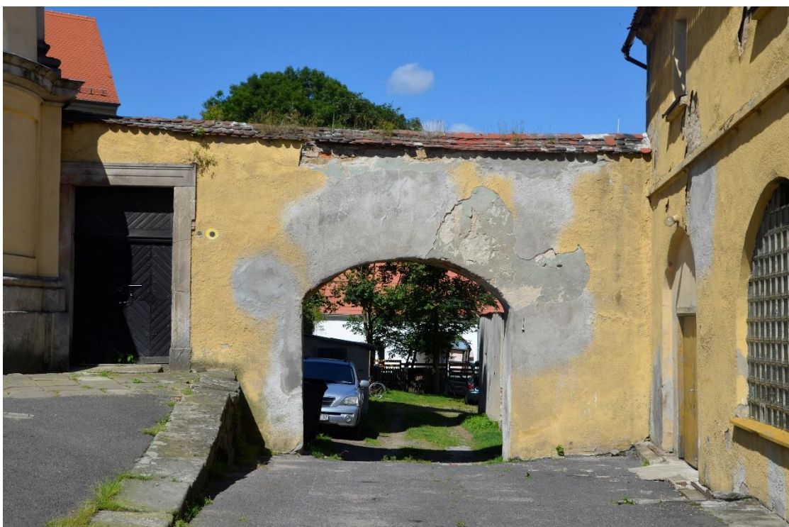
Widok na bramę należącą do budynku będącego przedmiotem opracowania - strona wschodnia
