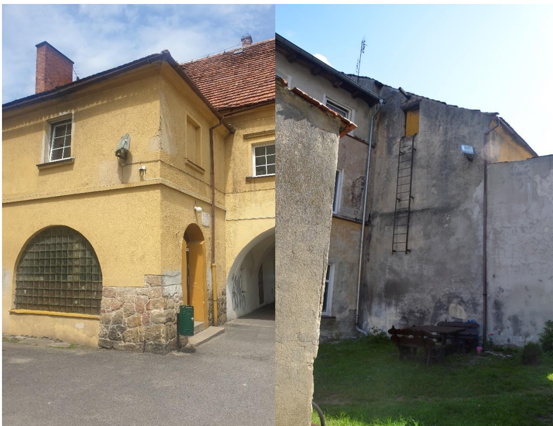
Widok na budynek przeznaczony do remontu-elewacja 1)wschodnia 2)zachodnia
