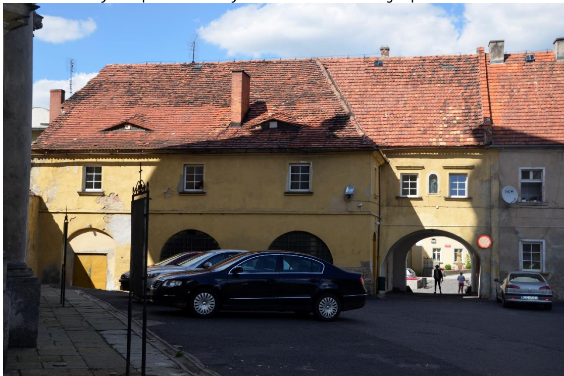
Widok na budynek przeznaczony do remontu-elewacja południowa
