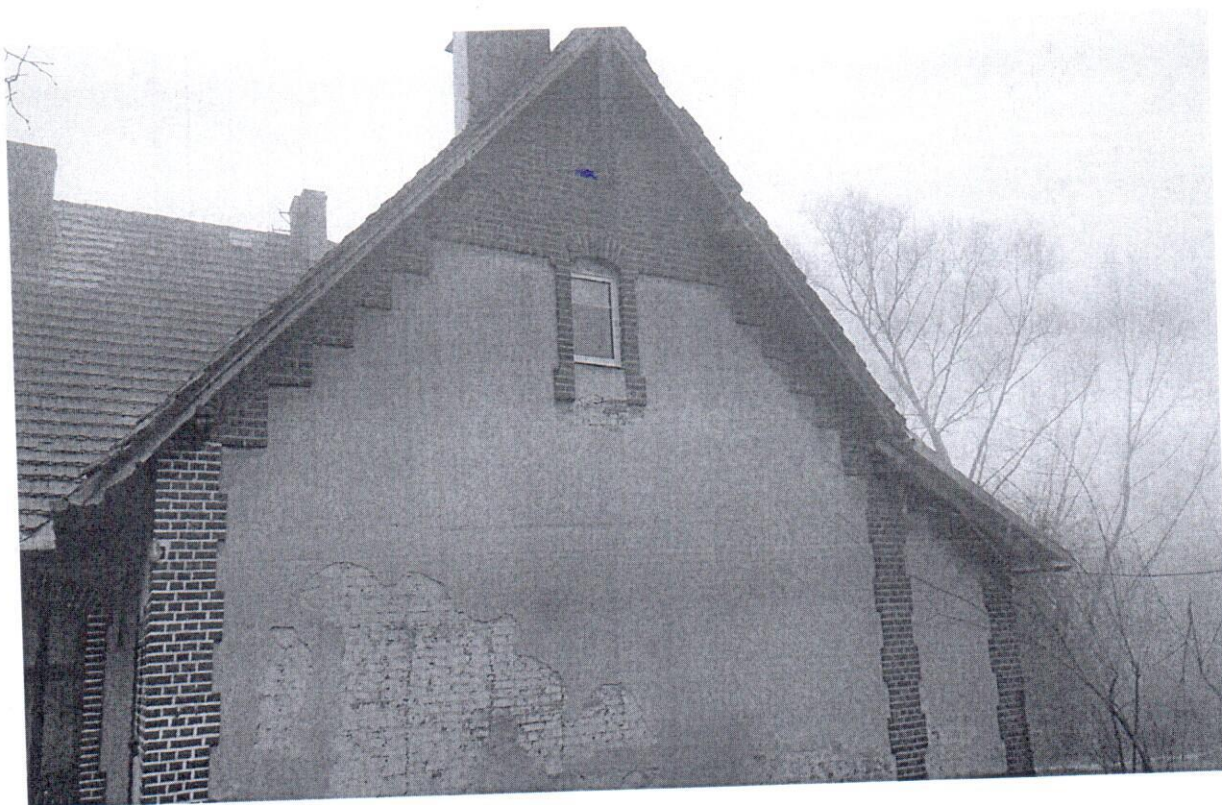
Fot. 5. Elewacja północna - ściana szczytowa
