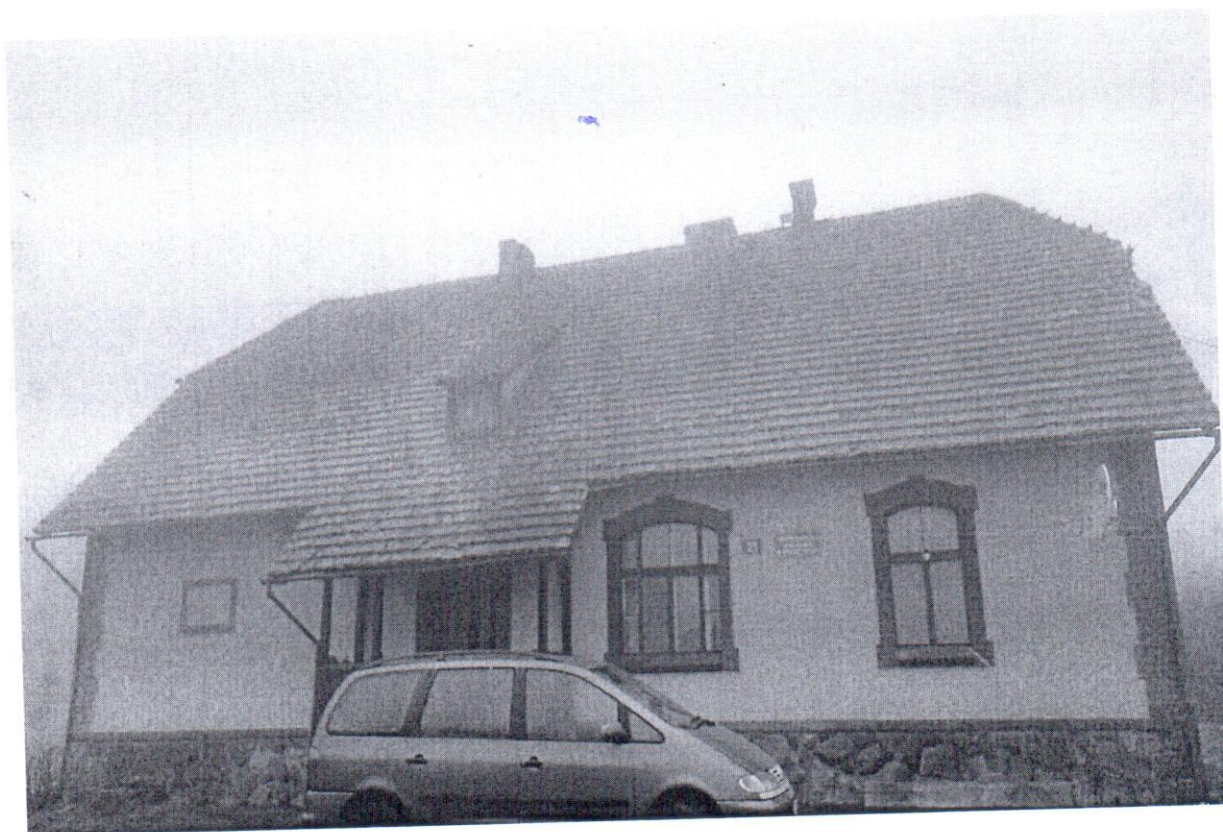
Fot. 1. Elewacja południowa
