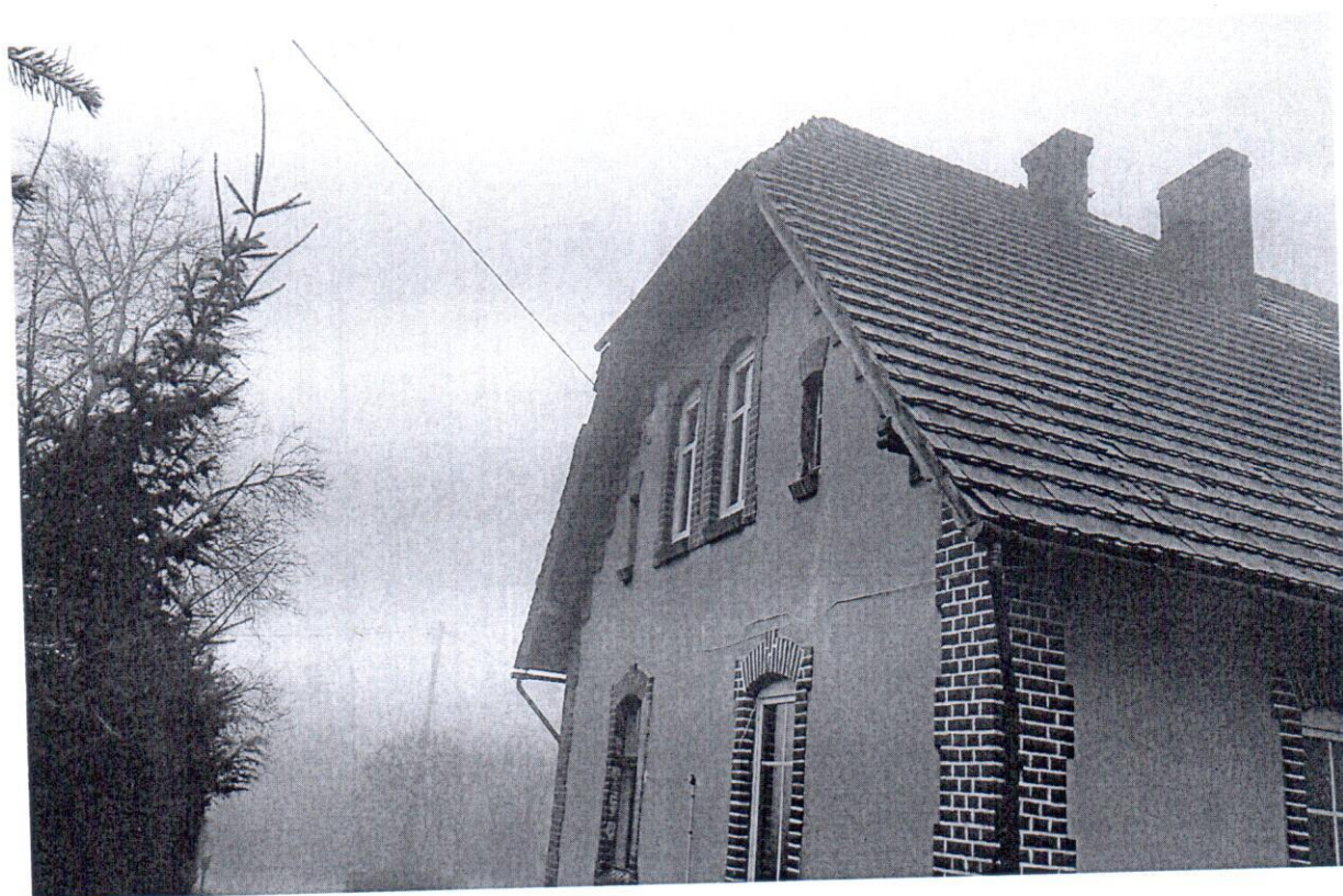
Fot. 2. Elewacja wschodnia
