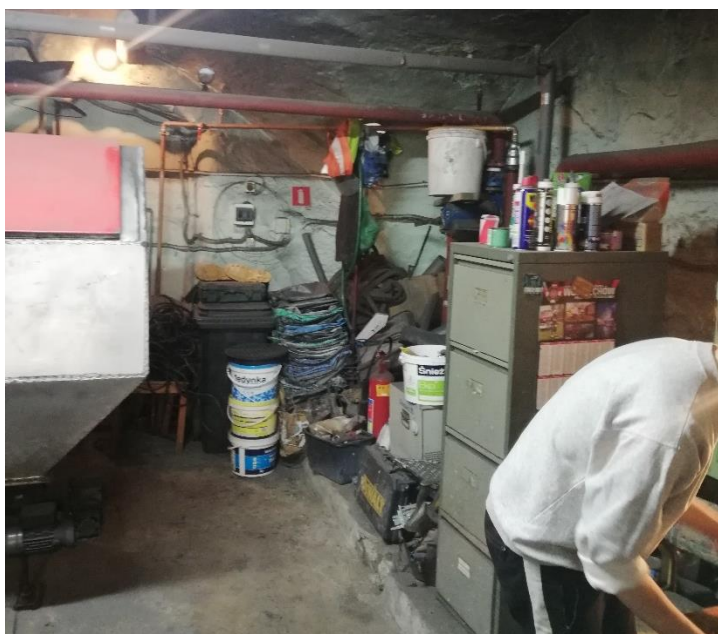
Pomieszczenie 0.42 – widok od strony wejścia
