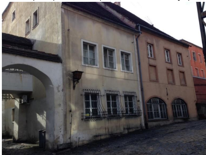
Widok na budynek przeznaczony do remontu-elewacja północna
