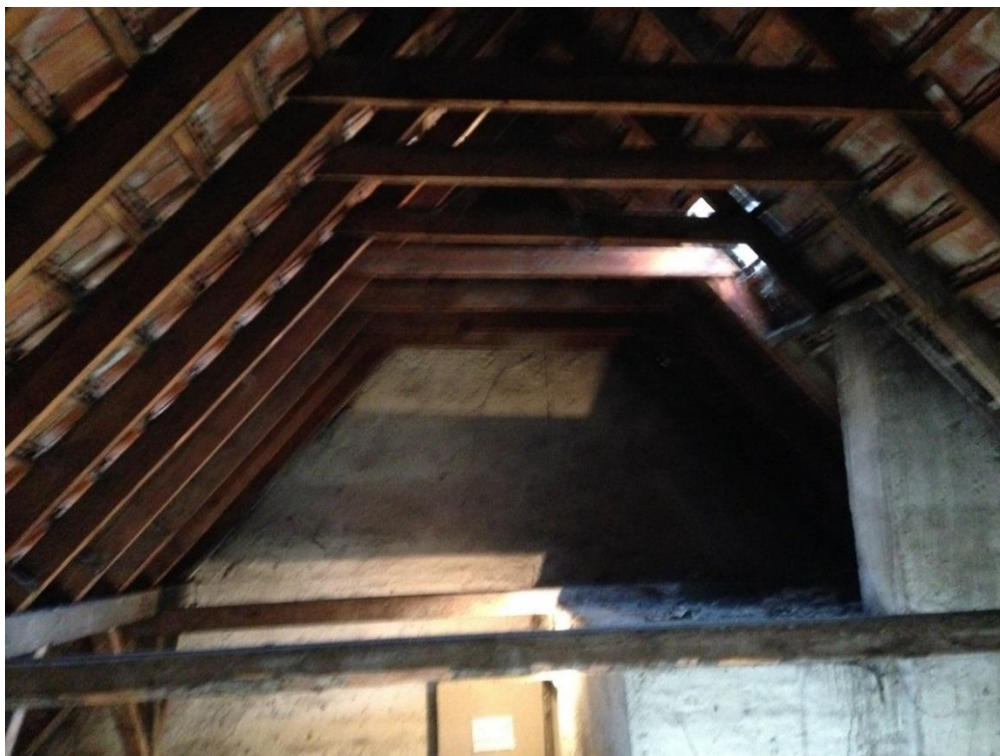
Więźba dachowa części „A”
