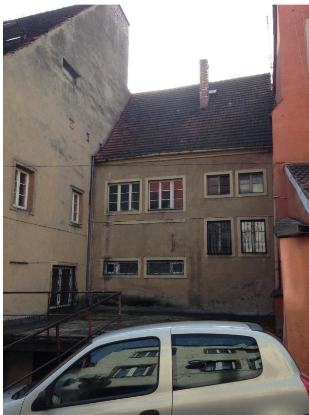
Widok na budynek przeznaczony do remontu-elewacja zachodnia i północna
