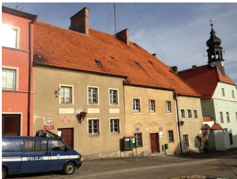
Widok na budynek przeznaczony do remontu-elewacja południowa
