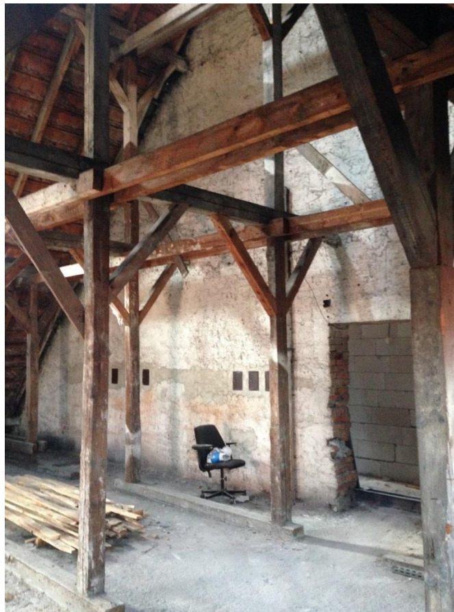
Więźba dachowa części „C”
