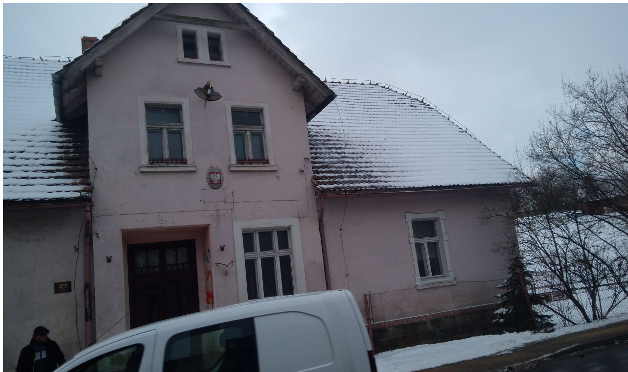
Fot. 1. Elewacja północna
