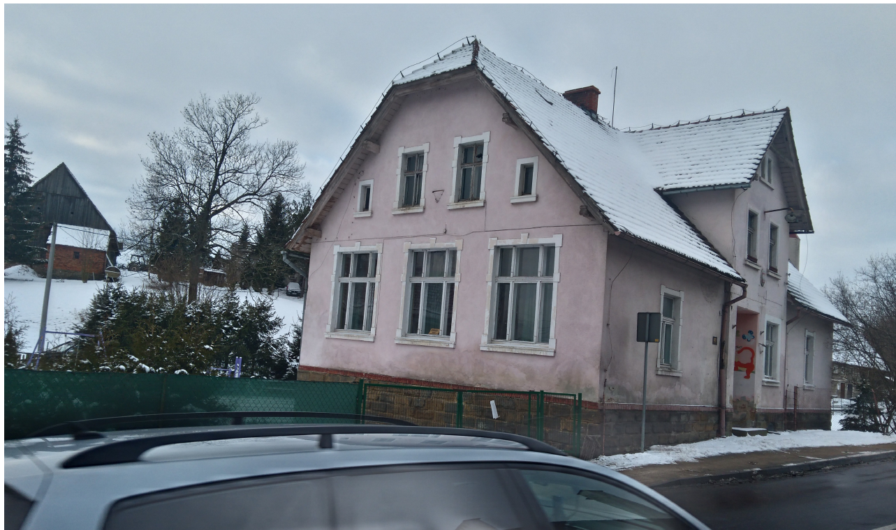
Fot. 4. Elewacja zachodnia
