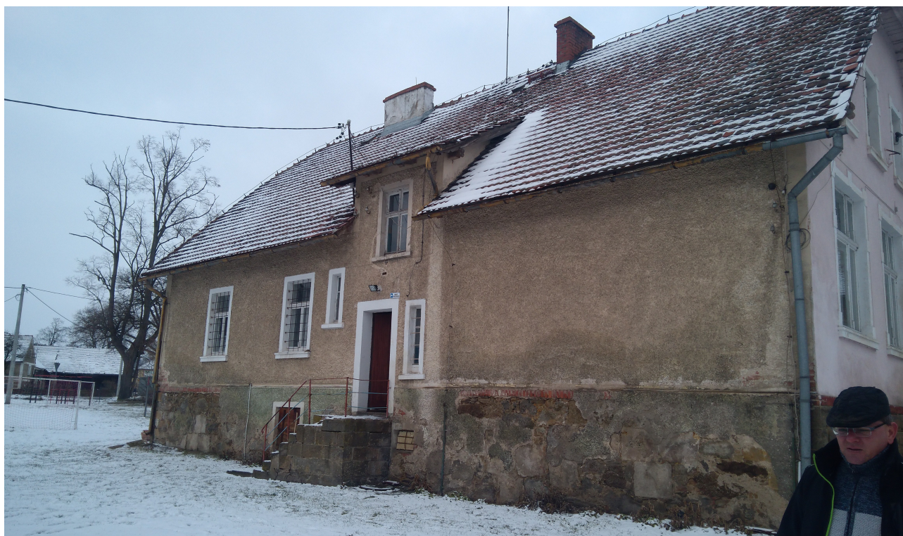
Fot. 2 Elewacja południowa
