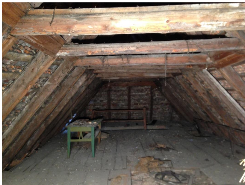
Więźba dachowa budynku „G”
