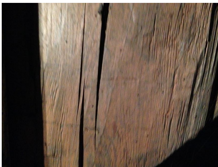
Fot. 17B. Porażona płatew pośrednia ramy stolcowej.
