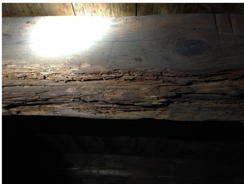
Fot. 11B. Porażona i częściowo spróchniała jętka.
