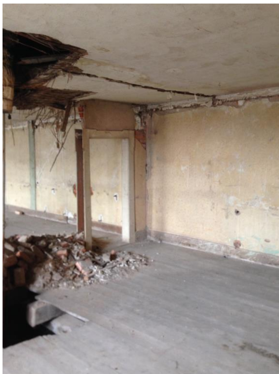
Fot. 1F. Przecięta belka stropowa poddasza, usunięta ceglana ściana działowa poddasza, nieusunięty gruz.
