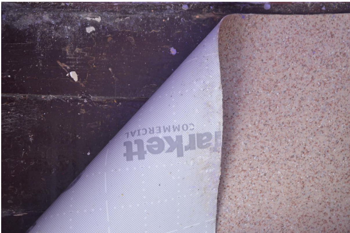
Deski podłogowe wymagające odrestaurowania, przykryte PCV
