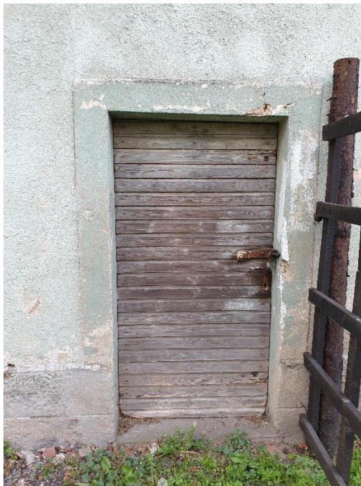
drzwi do pom. kotłowni
