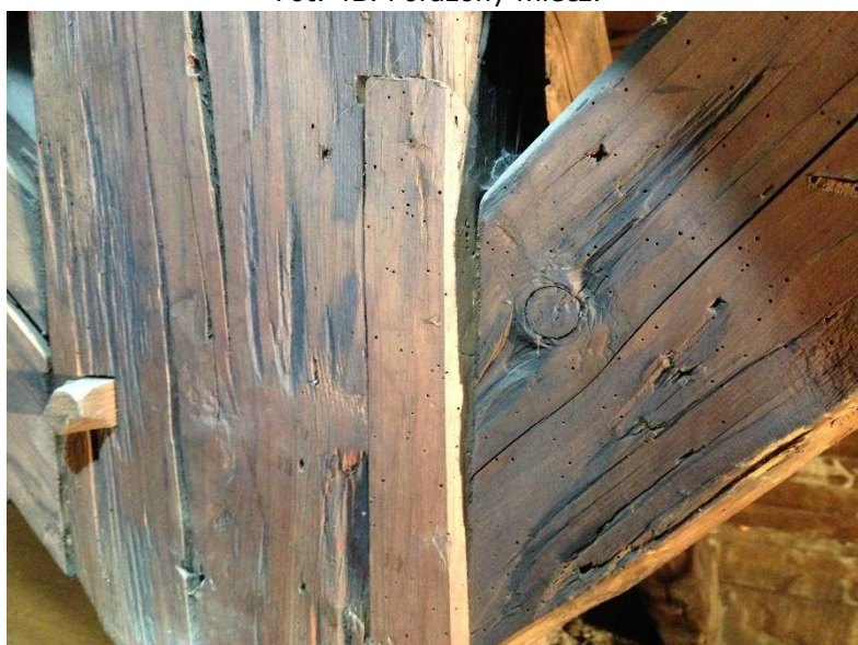
Fot. 5B. Porażony miecz i słup ramy stolcowej.
