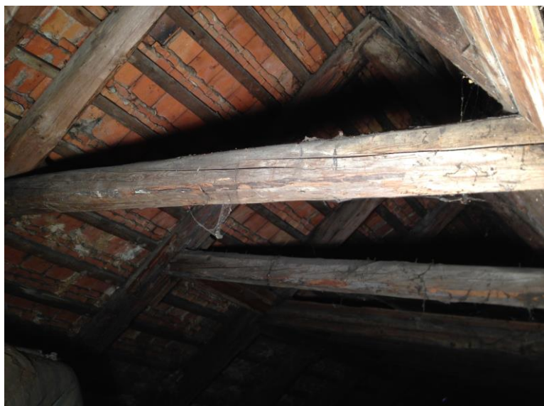
Fot. 13F. Częściowo porażone owadami elementy więźby.
