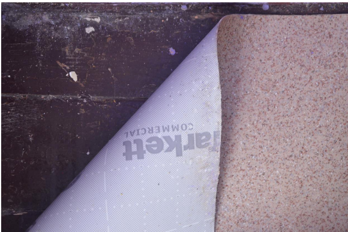
Deski podłogowe wymagające odrestaurowania, przykryte PCV
