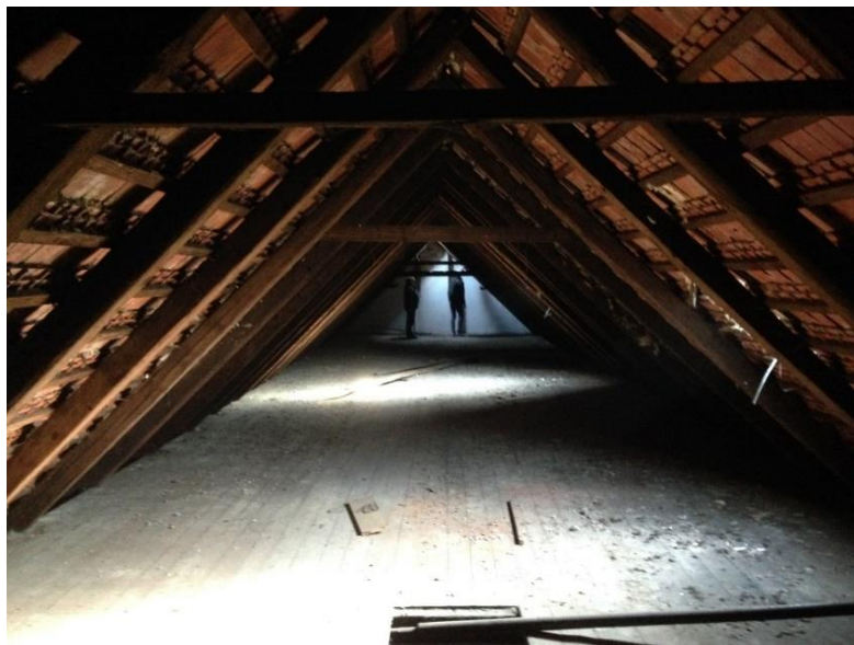
Więźba dachowa budynku „B”
