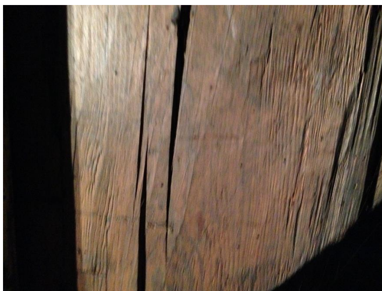
Fot. 17B. Porażona płatew pośrednia ramy stolcowej.
