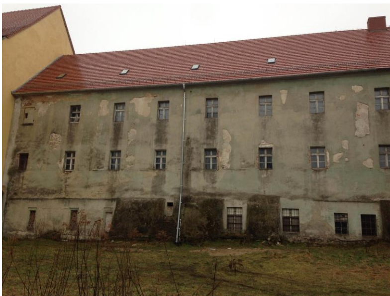
BUDYNEK „F”-do remontu tynki, sztukaterie, stolarka do wymiany, wymiana rur spustowych, remont wnętrz oraz instalacji wewnętrznej
