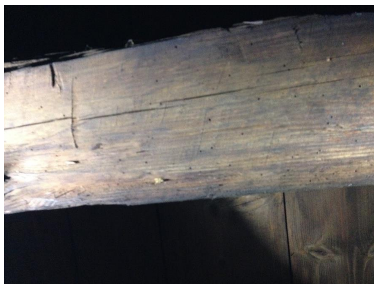
Fot. 15B. Porażona płatew pośrednia ramy stolcowej.
