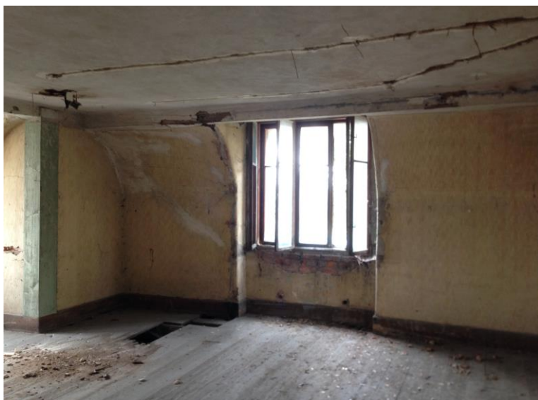
Fot. 3F. Ściana stolcowa poddasza.
