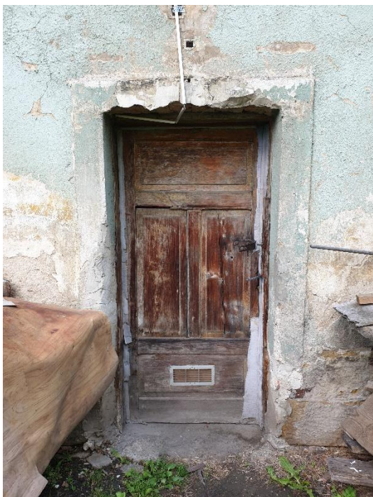
drzwi do pom. z pompami ciepła
