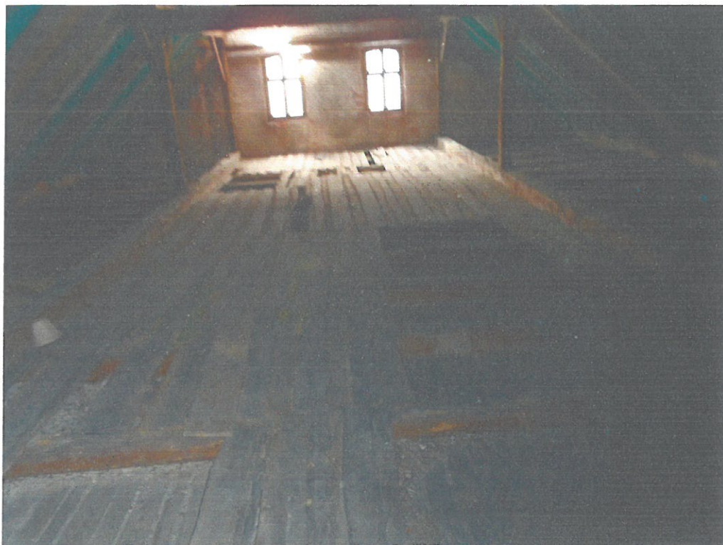
Strop nad świetlicą w Maciejowcu
