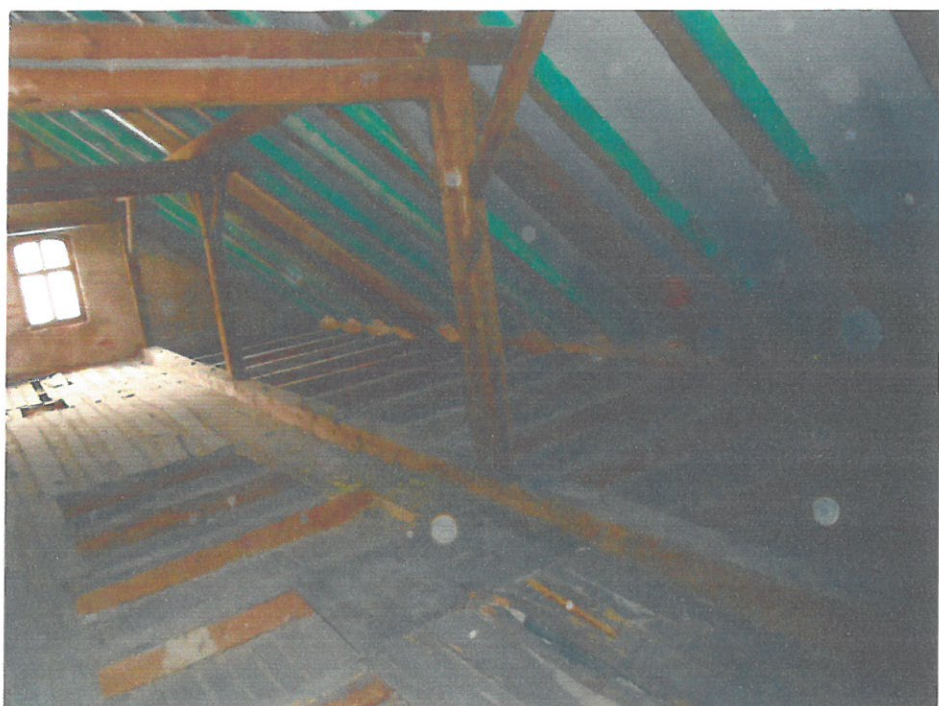
Strop nad świetlicą w Maciejowcu
