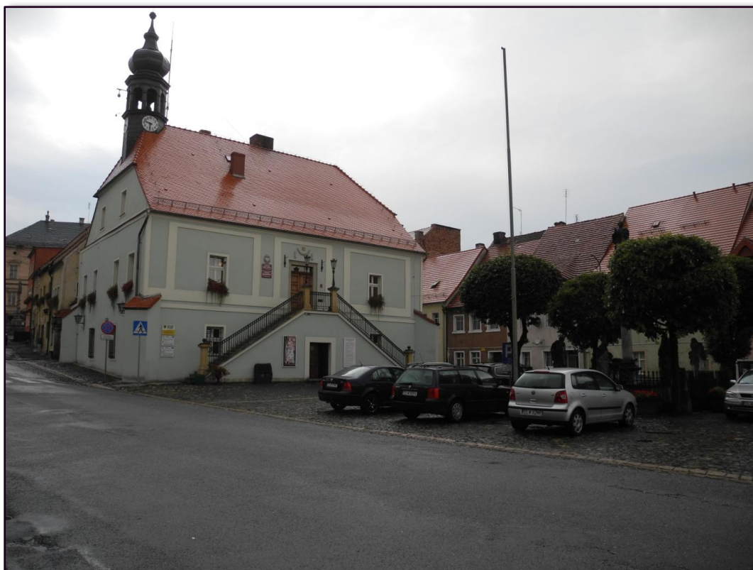
Ryc. 42 Ratusz (widok od strony wejścia)
