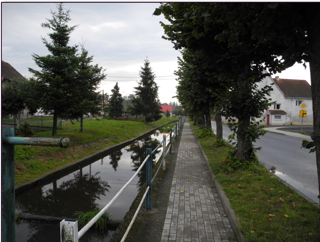
Ryc. 40 Teren ciągu pieszego wzdłuż rzeki
