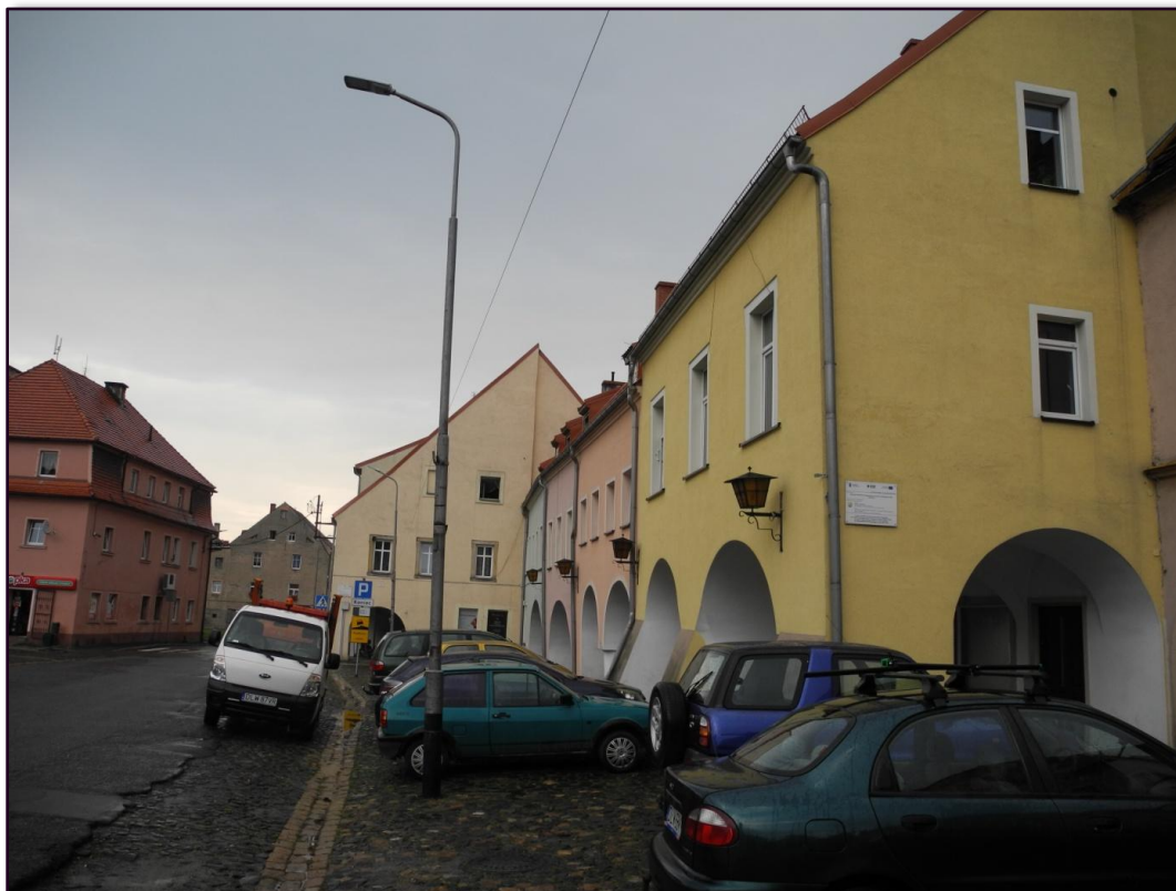
Ryc. 26 Budynki mieszkalne Pl. Wolności (po renowacji)
