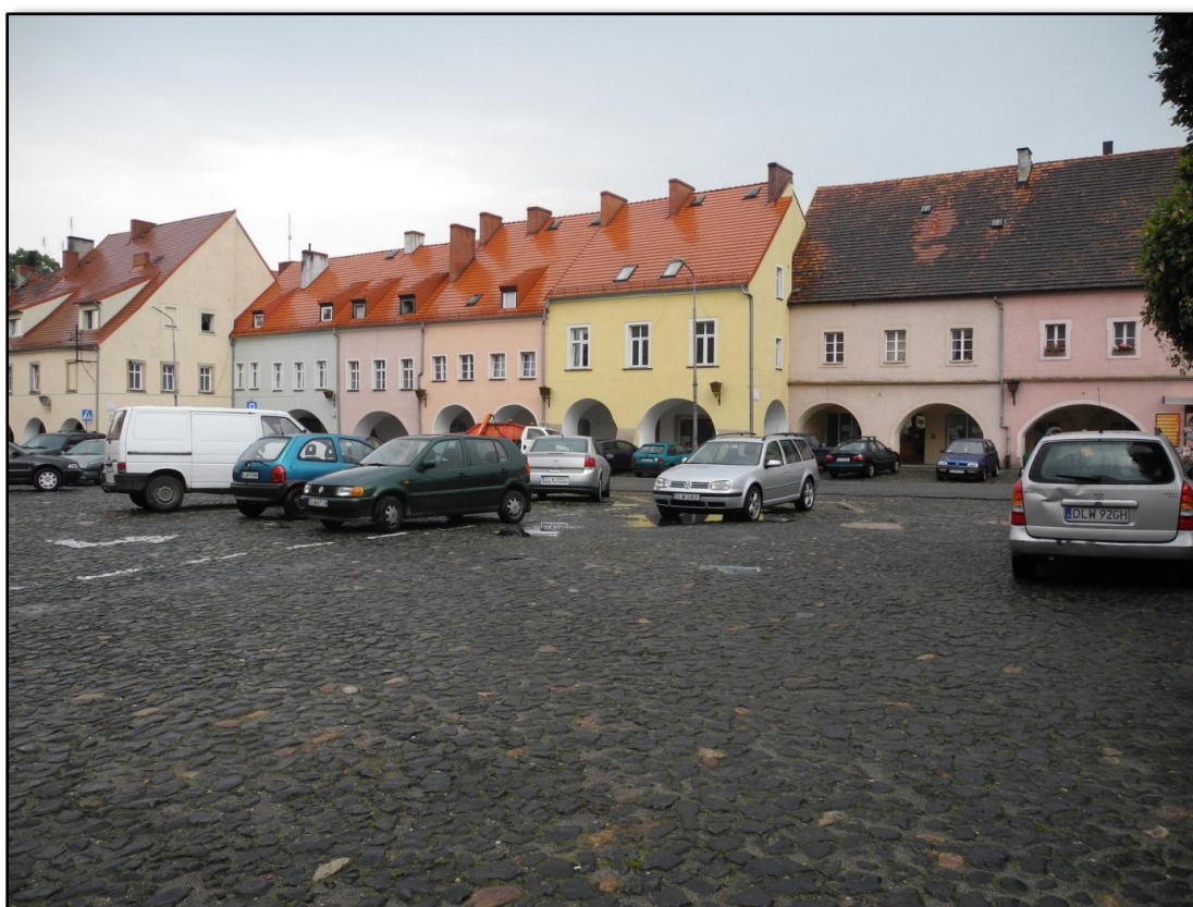
Ryc. 62 Odnówione budynki mieszkalne
