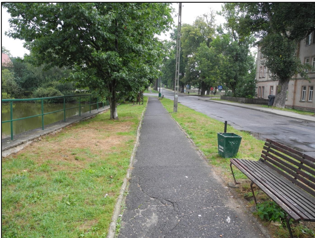
Ryc. 50 Ciąg pieszy wzdłuż basenu przeciwpożarowego
