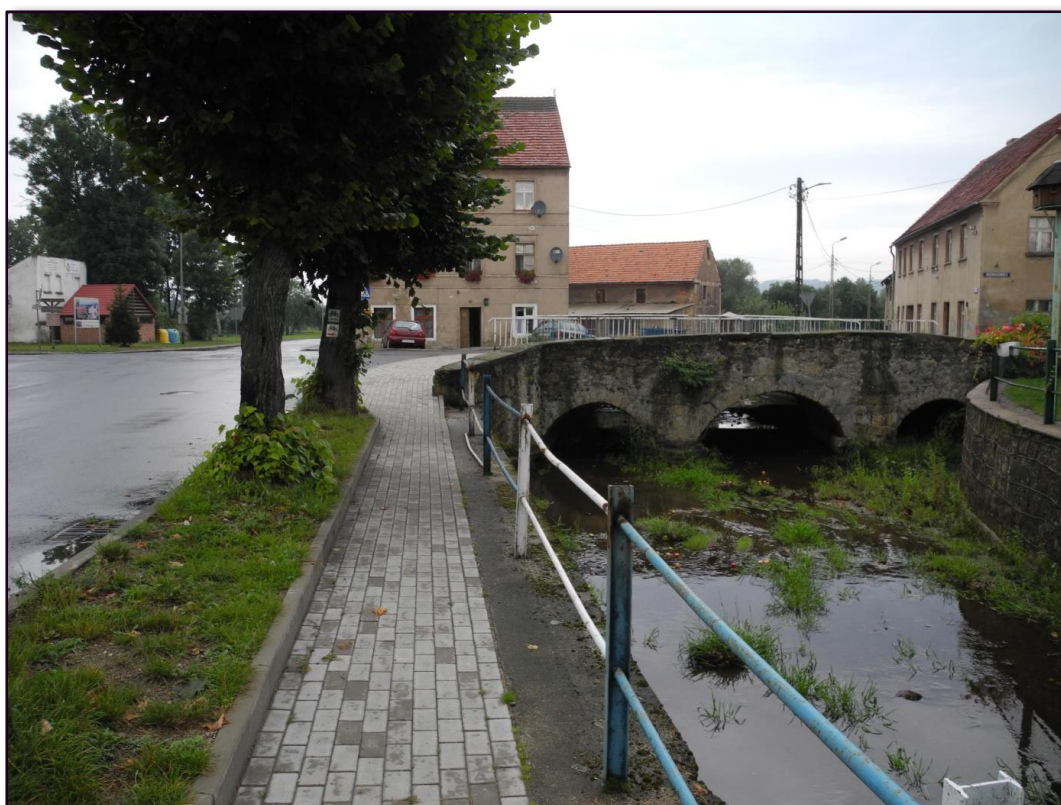
Ryc. 39 Most i przejście nad służą rzeczną
