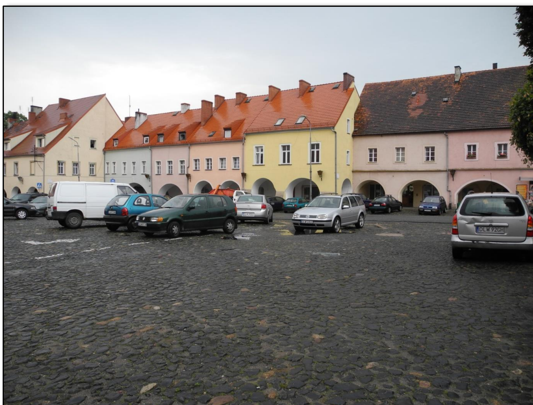
Ryc. 62 Odnówione budynki mieszkalne
