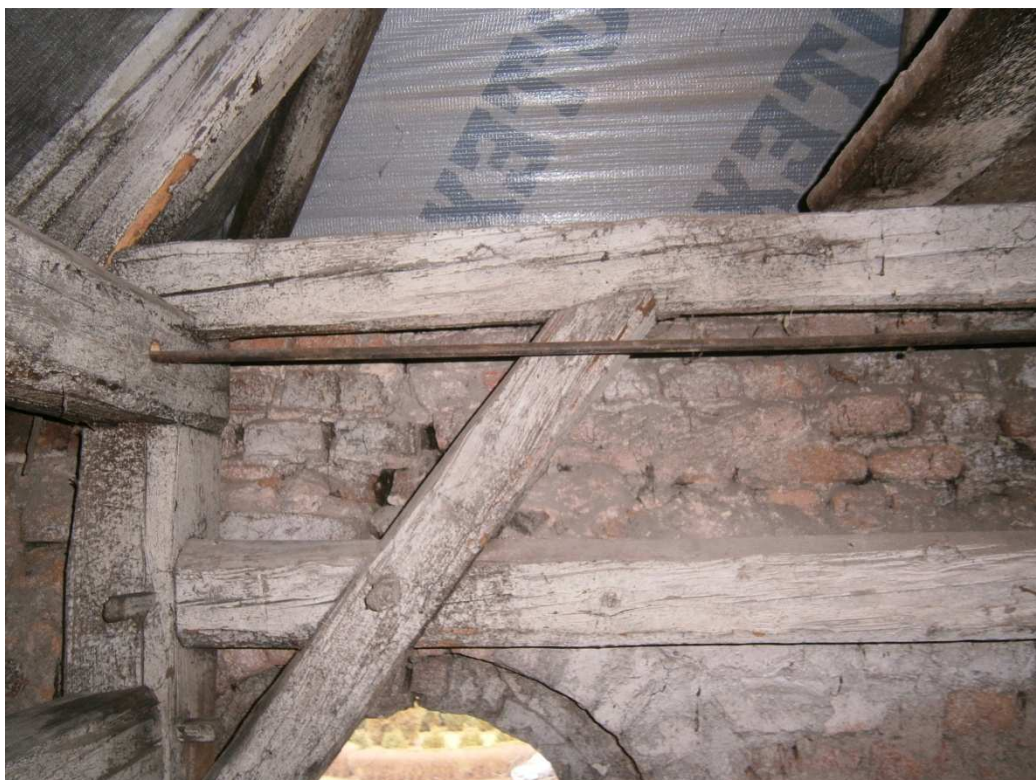
Ściąg stalowy z pręta średnicy 20mm na strychu
