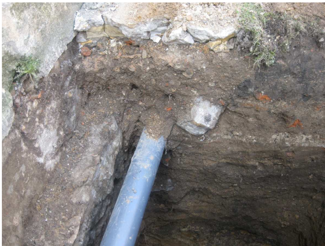
Odkrywka fundamentu na ścianie szczytowej
