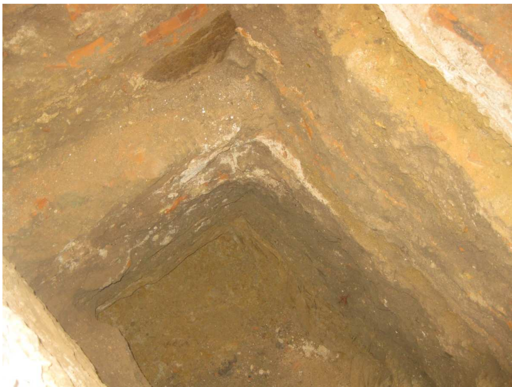
Odkrywka fundamentu od strony wewnętrznej
