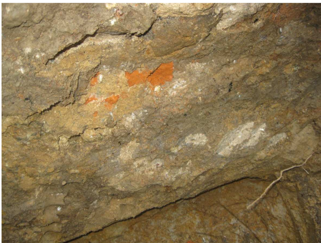
Odkrywka fundamentu na ścianie szczytowej
