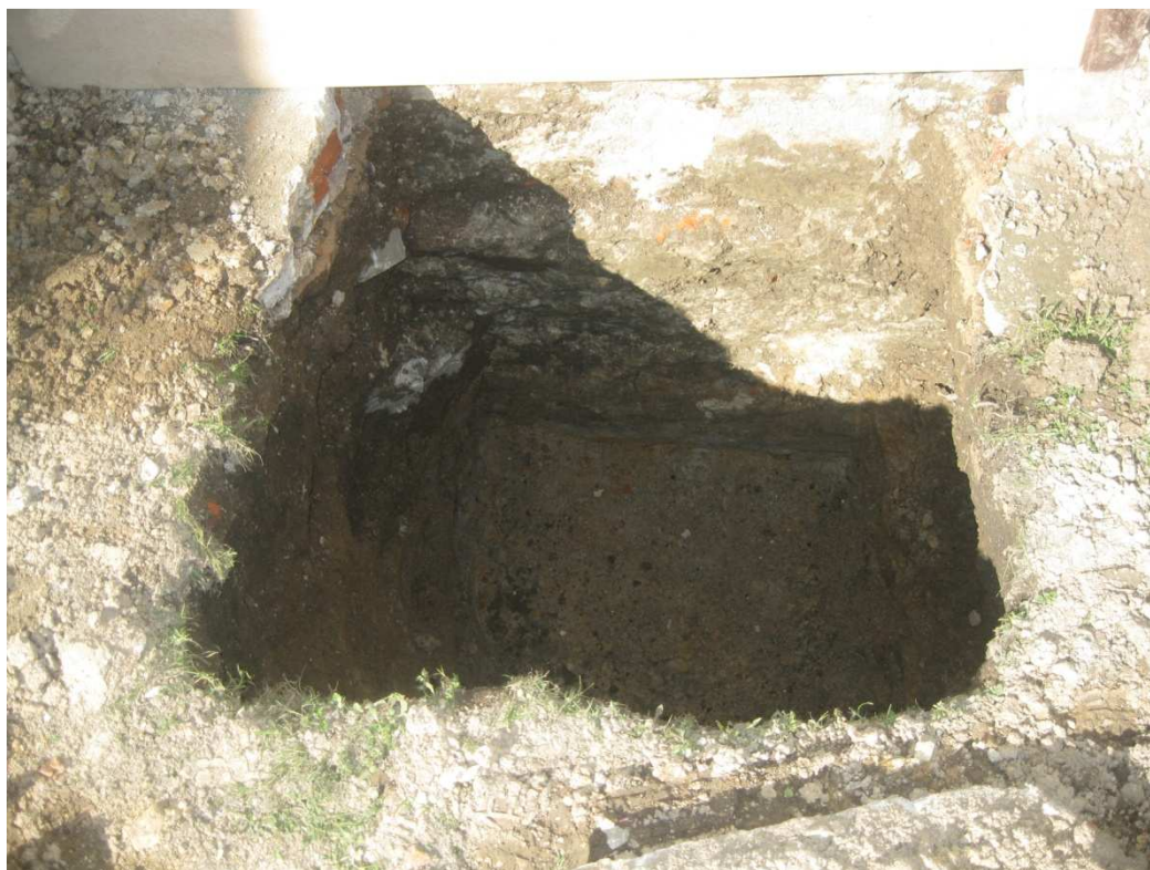
Odkrywka fundamentu na ścianie frontowej
