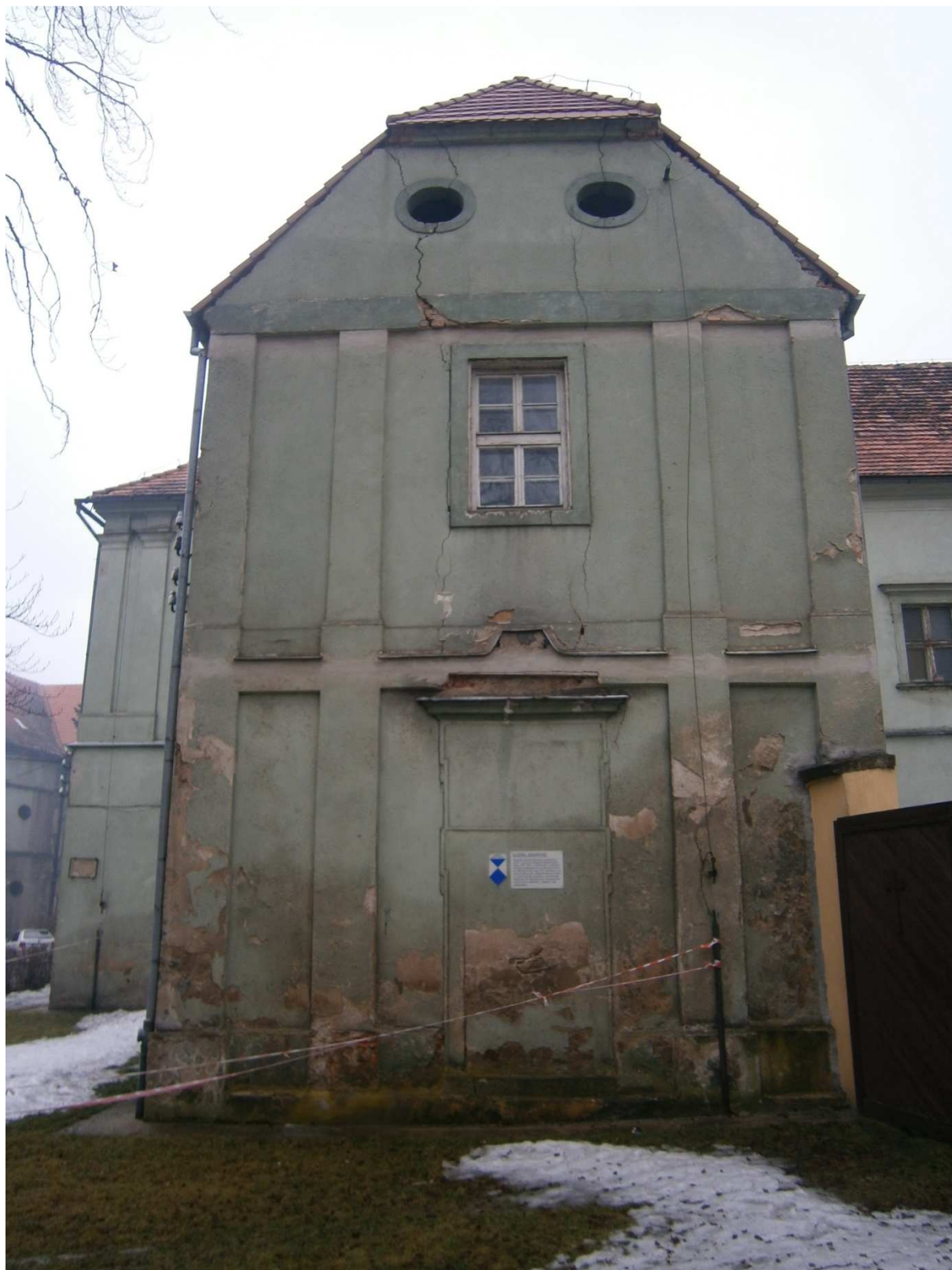
Ściana szczytowa prawego skrzydła Internatu
