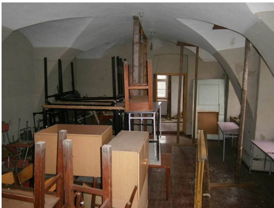
Podstemplowane sklepienie na I piętrze budynku
