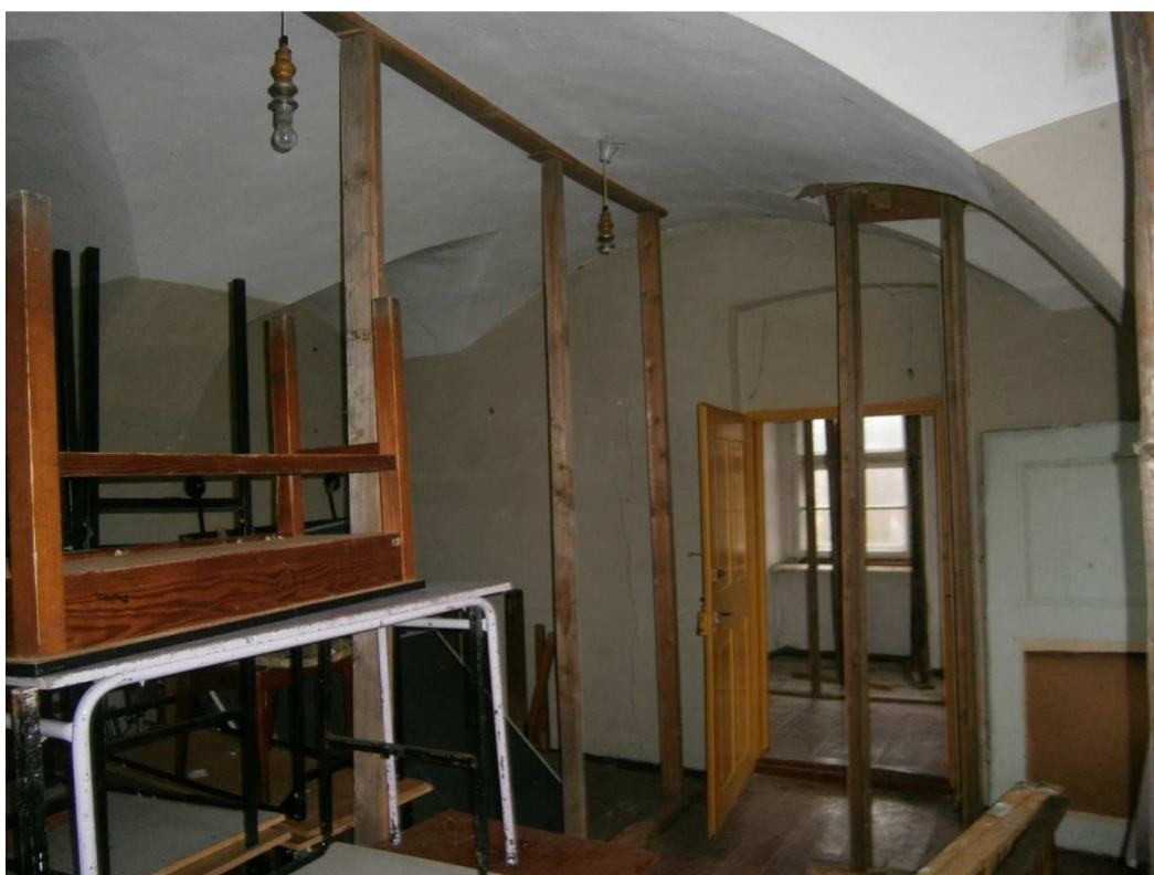
Podstemplowane sklepienie na I piętrze budynku – pomieszczenie 2/1
