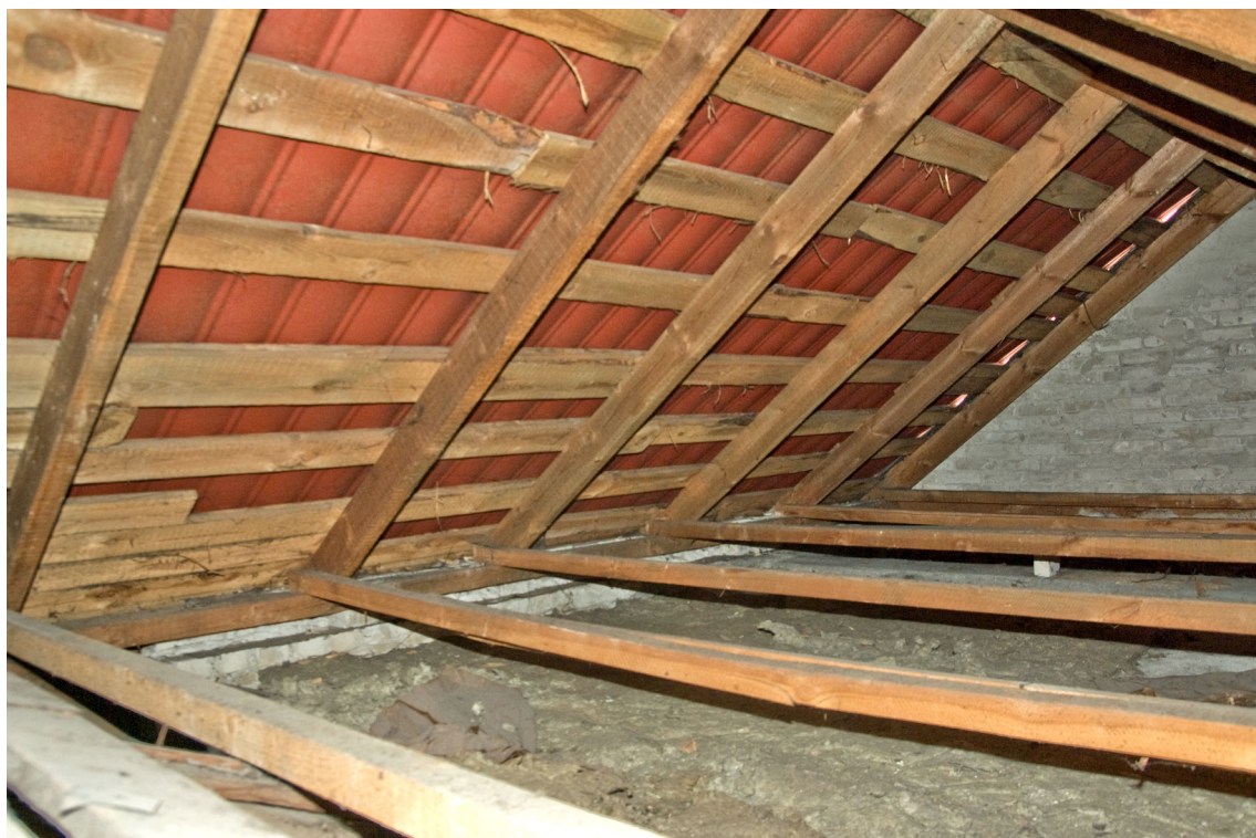
Fot. 11 Widok nowego poddasza, konstrukcja wymaga impregnacji
