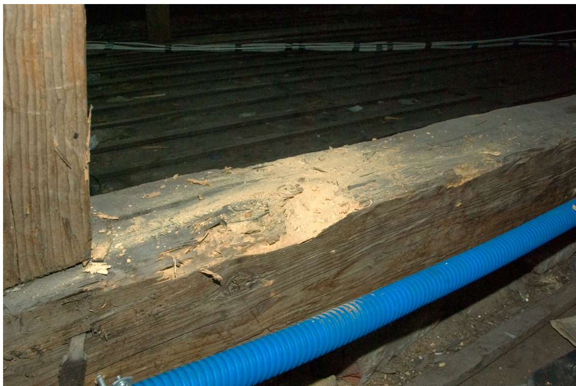
Fot. 4 Fragment belki tramowej w drugim węźle porażonej przez owady
