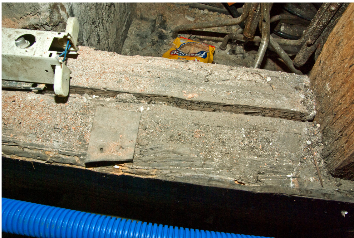
Fot. 9 Niefachowe połączenie starej połaci z nowym dachem od strony tylnej budynku
