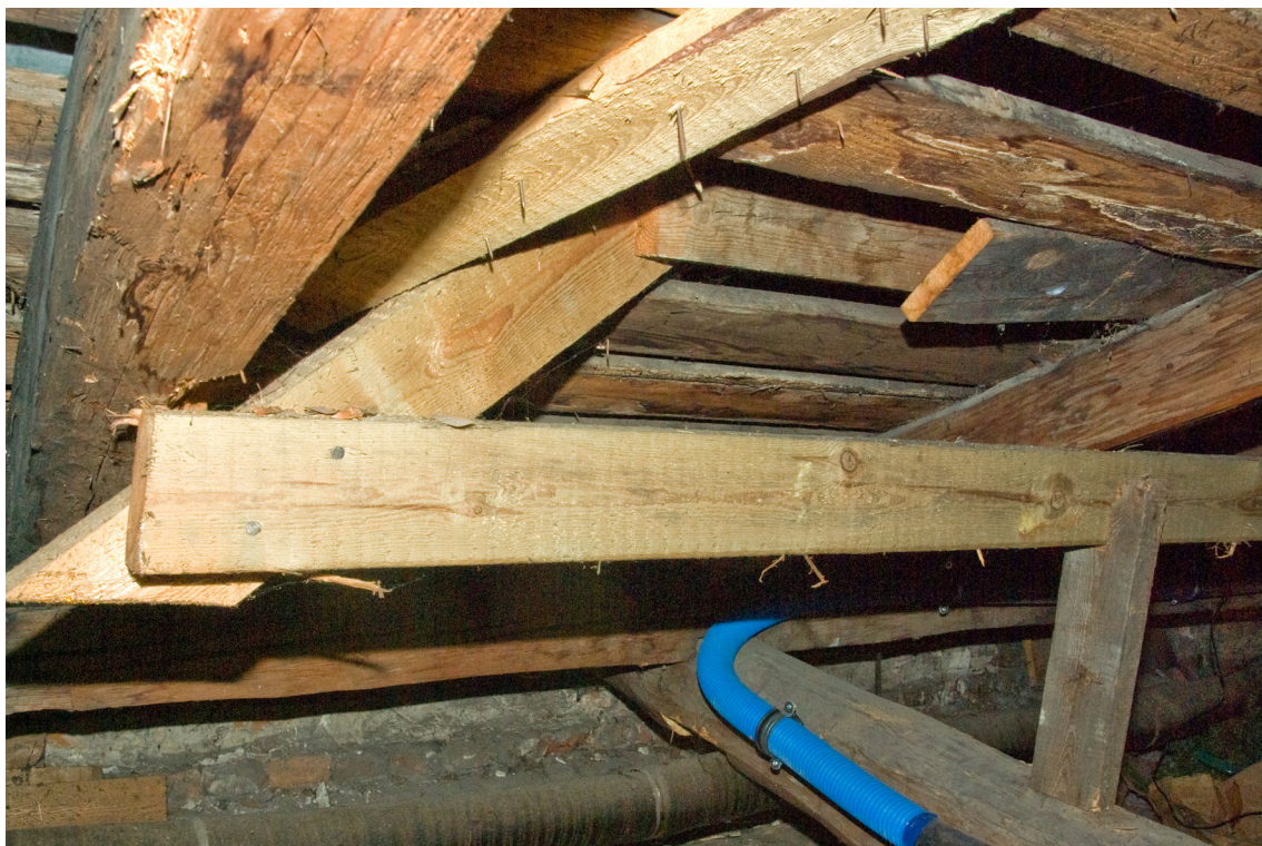
Fot. 9 Niefachowe połączenie starej połaci z nowym dachem od strony tylnej budynku
