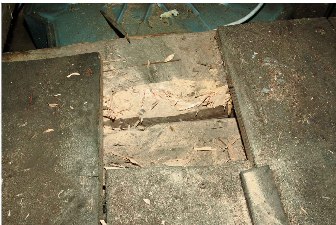
Fot. 16 Porażone belki stropowe w środkowej części stropu – przy węźle 2
