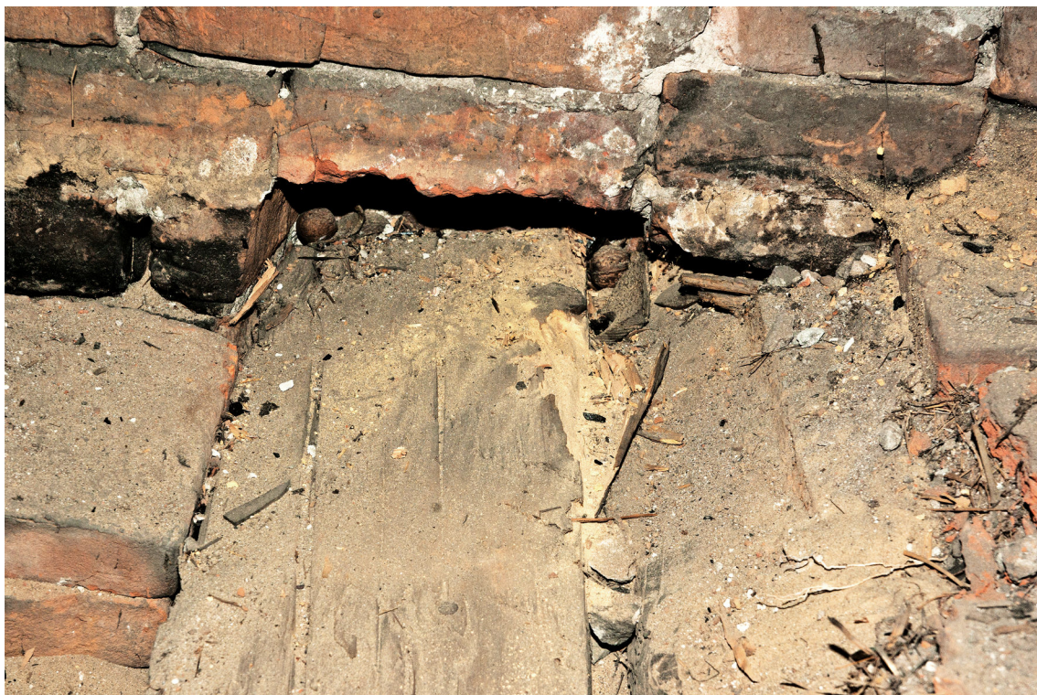
Fot. 17 Zniszczone zakończenia belek stropowych przy ścianie szczytowej wschodniej
