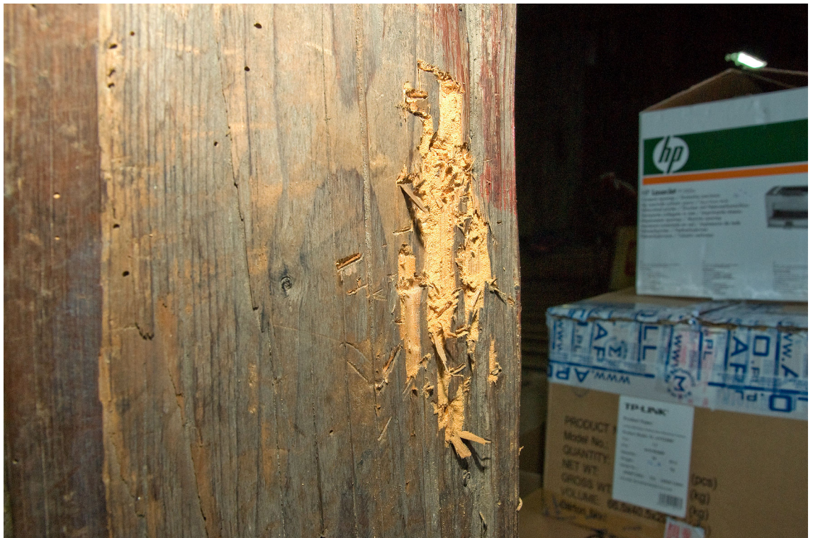
Fot. 2 Fragment słupa porażonego przez owady techniczne szkodniki drewna, widoczne również otwory wlotowe żerujących owadów
