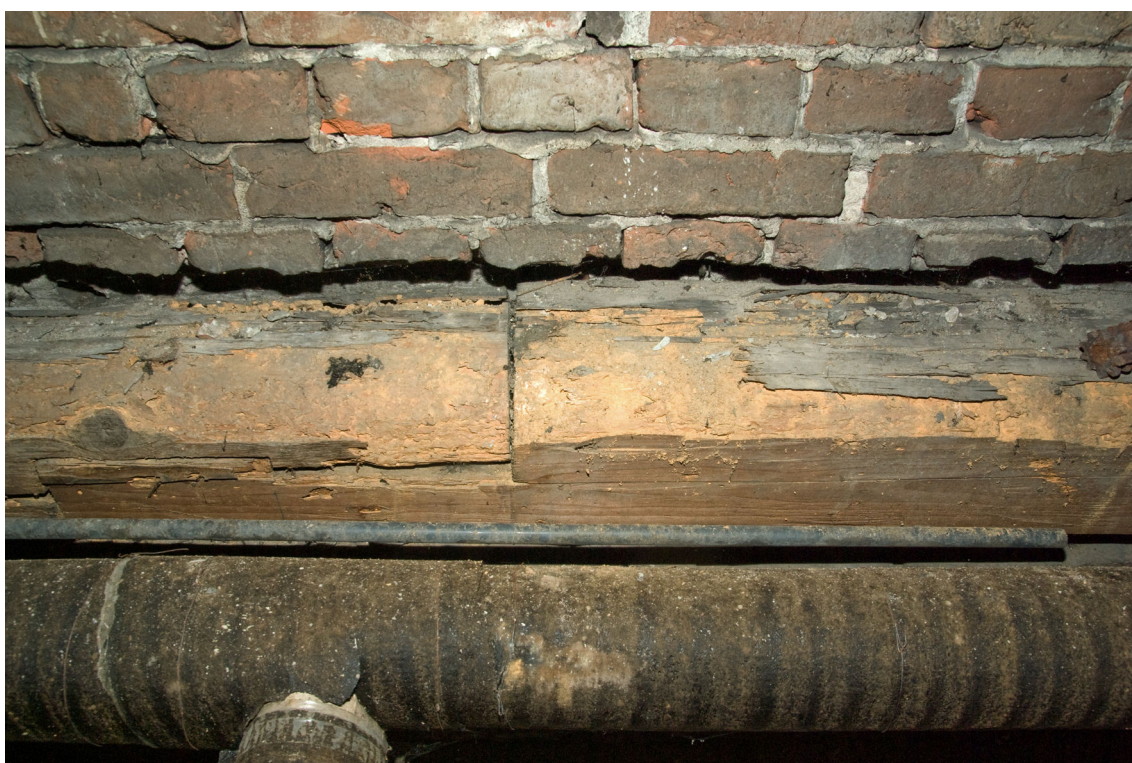
Fot. 8 Na fot.7 i 8 silnie porażona belka tramowa przy ścianie szczytowej od strony wschodniej budynku
