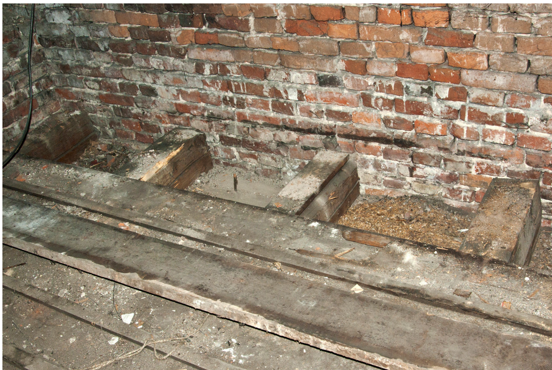
Fot. 14 Powierzchniowe porażenie belek stropowych w części niższej poddasza
