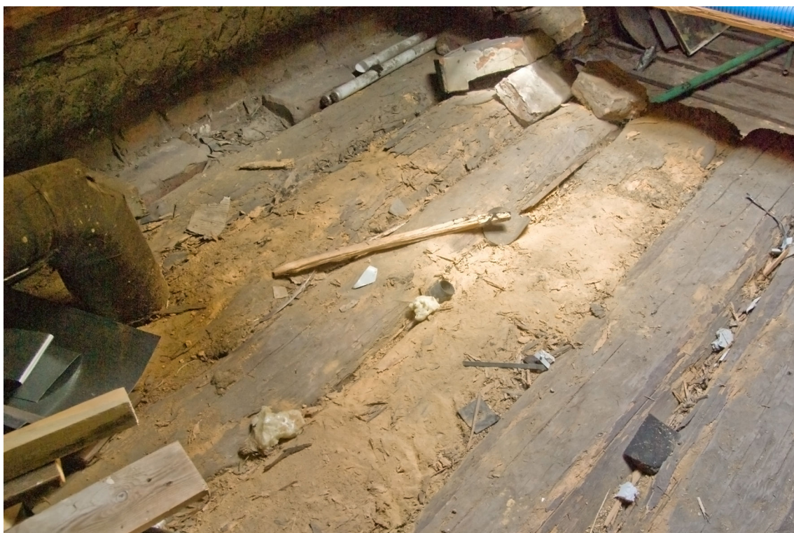
Fot. 15 Widok na zniszczone belki stropowe przy wejściu na poddasze
