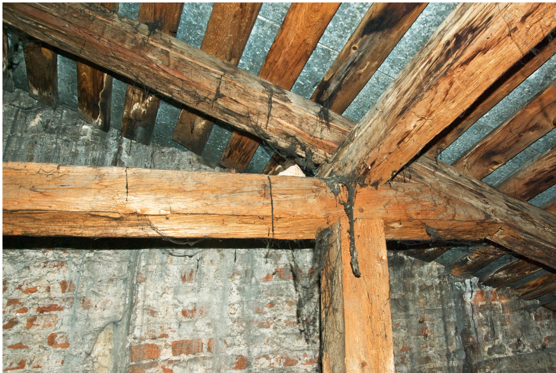
Fot. 12 Widok na ścianę szczytową od strony wieży. Pokazano korozję murów, silne zacieki oraz zabrudzenie elementów konstrukcyjnych więźby
