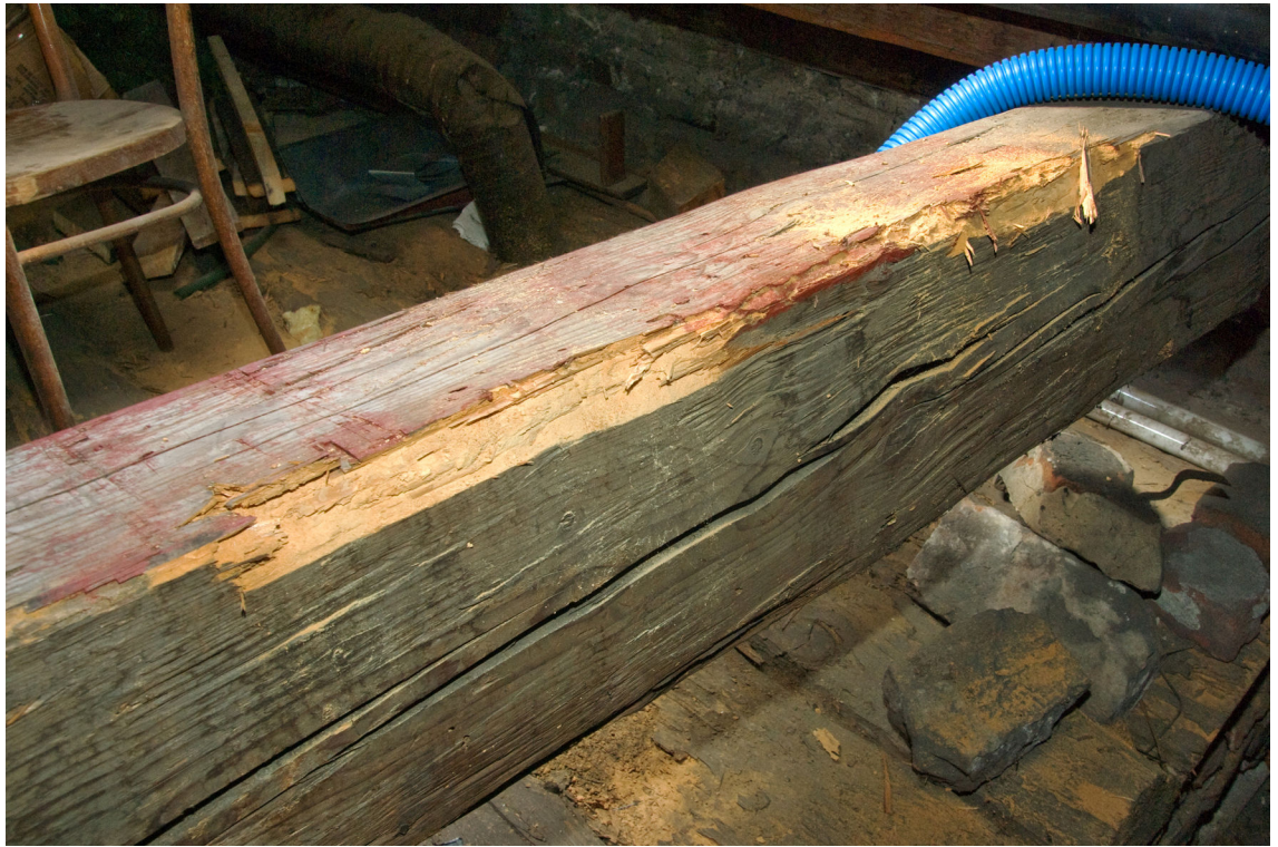
Fot. 1 Porażona belka tramowa od strony tylnej budynku
