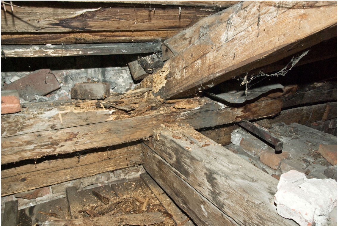
Fot. 5 Murlata, płatew dolna, krokiew oraz tram zniszczone przez szkodniki biologiczne
