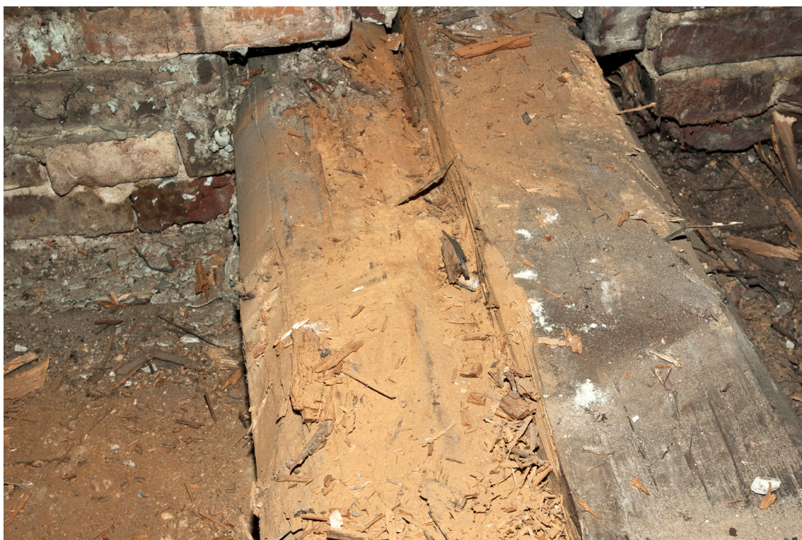
Fot. 13 Silnie porażone belki stropowe. Odkrywka przy ścianie szczytowej zachodniej
