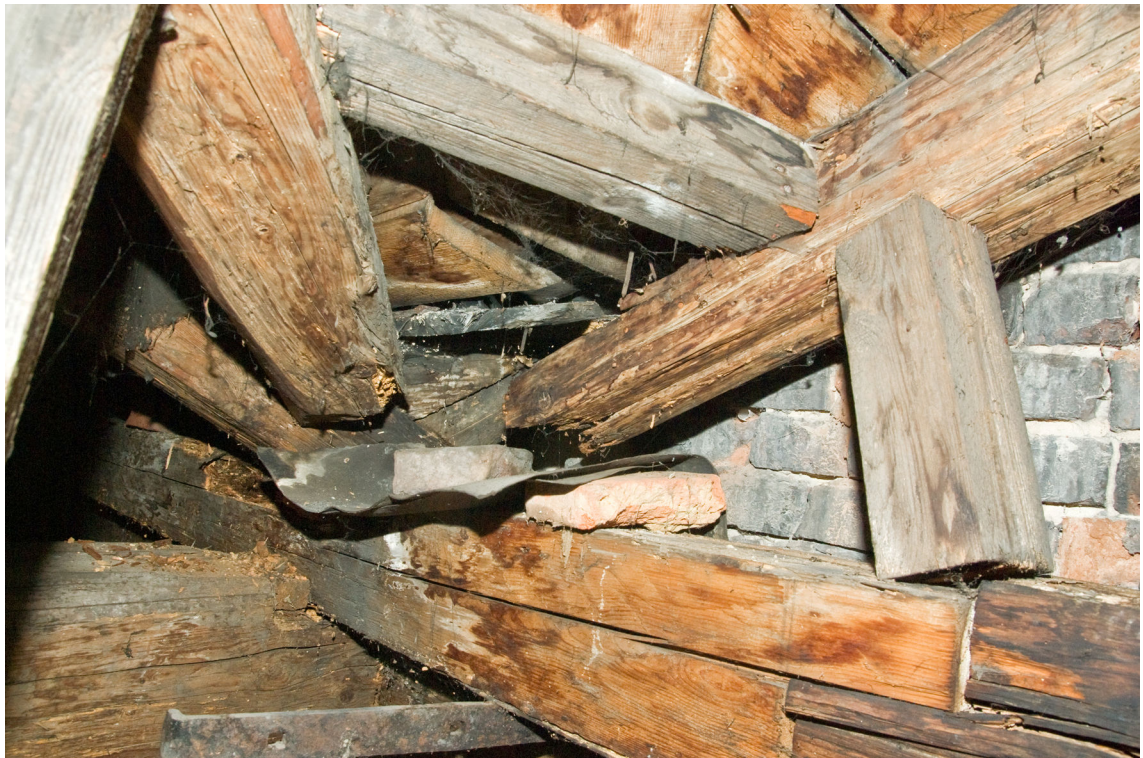
Fot. 6 Węzeł 3 od frontu, widoczne zniszczenia oraz niefachowe wzmocnienia
