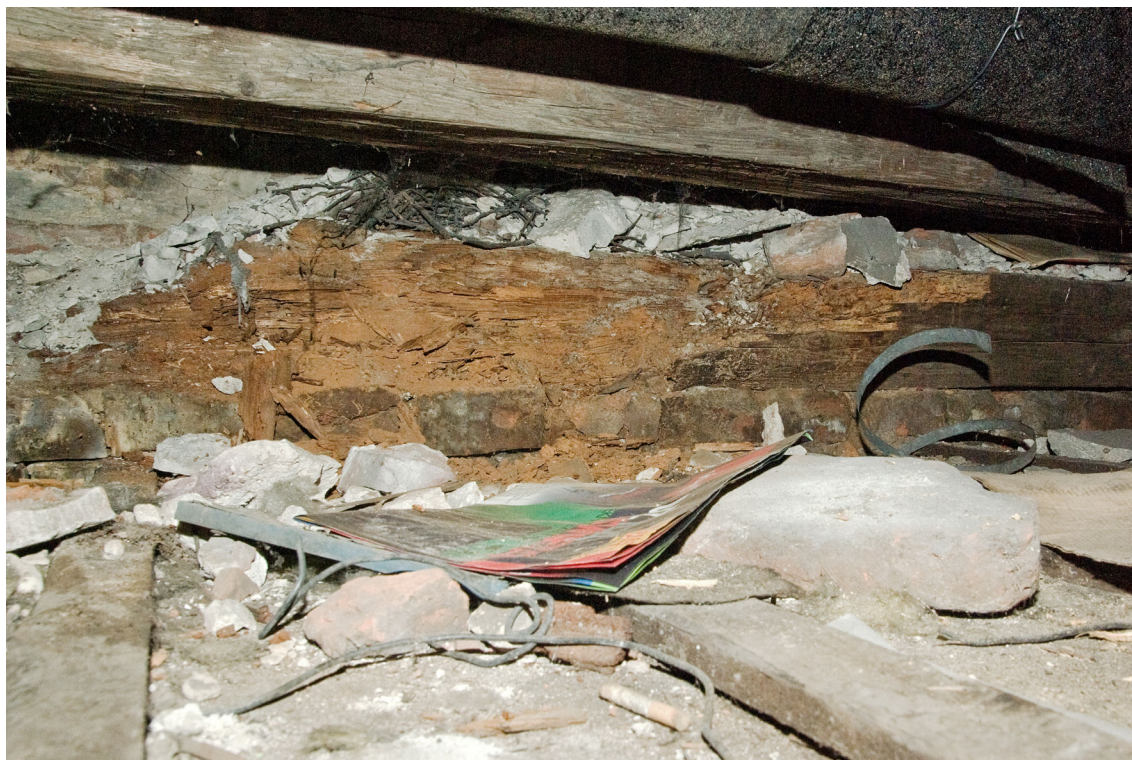
Fot. 3 Murłata od strony frontowej całkowicie zniszczona przez owady i grzyb
