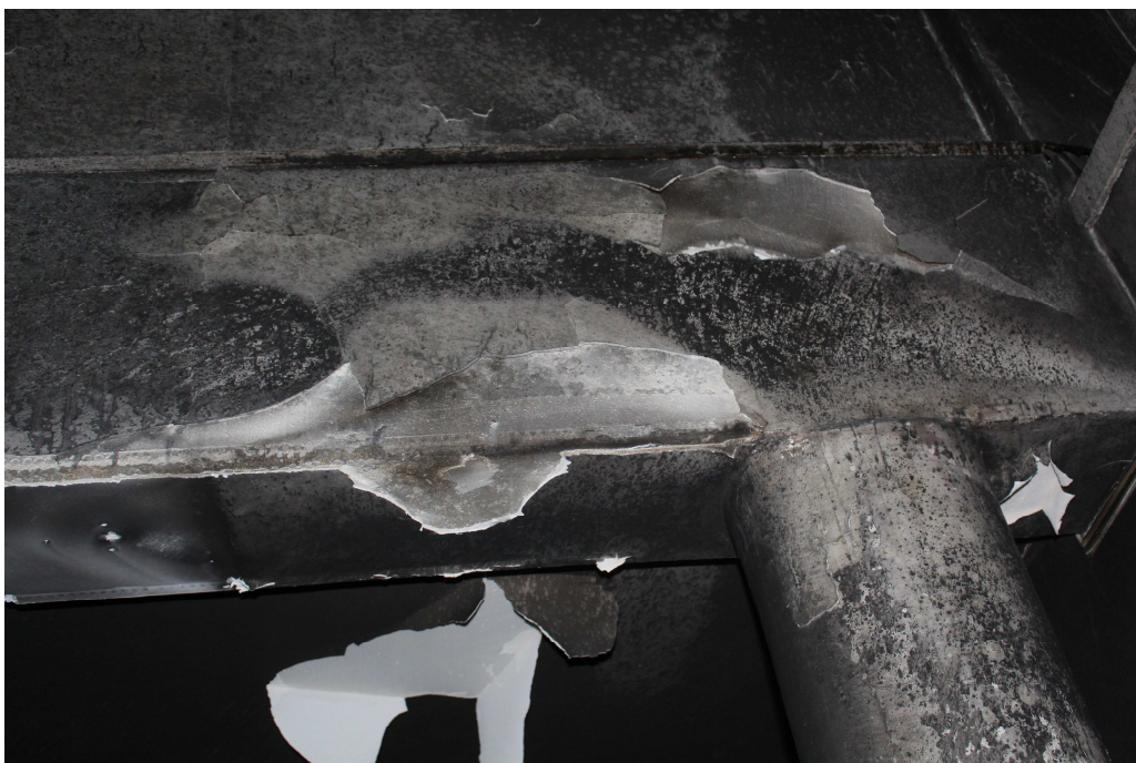
Fot.4 Podciąg oraz słup żelbetowy ze zniszczoną warstwą tynku
