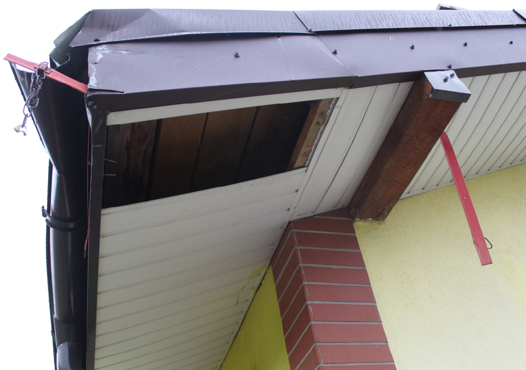
Fot.5 Uszkodzony fragment rynny i obróbki blacharskiej
