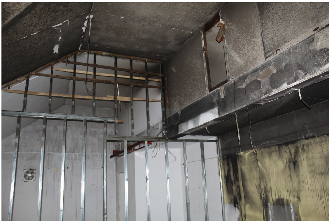
Fot.3 Widok pozostałego rusztu po ścianie działowej z płyt g.-k.
