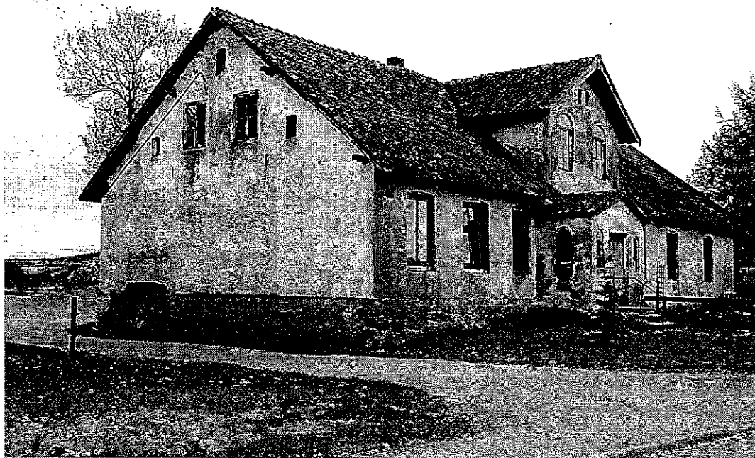
Fot. Dawna zabudowa miejscowości
