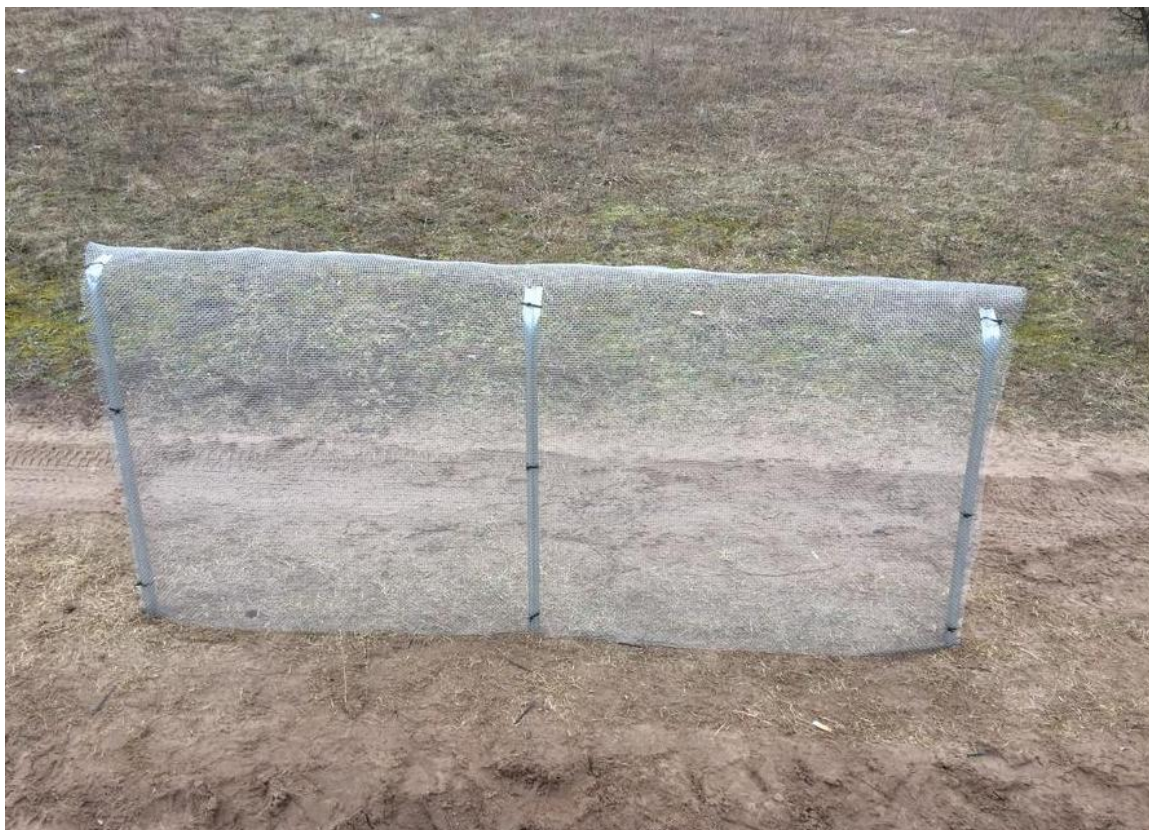
Rys. 5 Płotek ochronno-naprowadzający z siatki.
