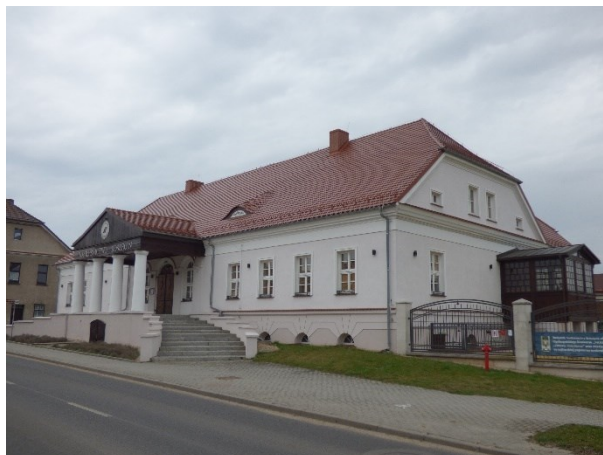
Fot. 17. Budynek zarządu dóbr pałacowych, ob. budynek nadleśnictwa w zespole pałacowym w Koszęcinie
