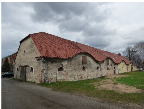
Fot. 13. Stajnie, ob. budynek nieużytkowany w zespole folwarcznym w Koszęcinie
