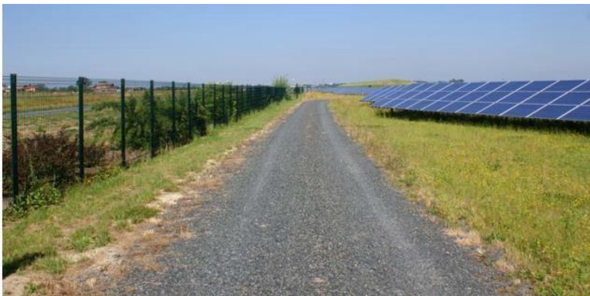
Fot. 1. Widok na przykładowe zastosowanie drogi technologicznej
