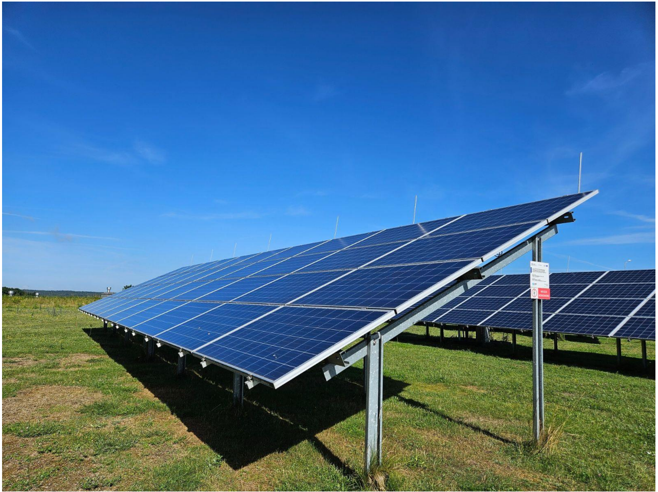
Rysunek 5. Przykładowa naziemna instalacja fotowoltaiczna wraz z zagospodarowaniem powierzchni między rzędami paneli, miejscowość Olszanka (woj. opolskie), źródło https://zielonyrozwoj.pl/nowa-energia-dla-barcina-rusza-budowa-nowoczesnej-farmy-fotowoltaicznej/
