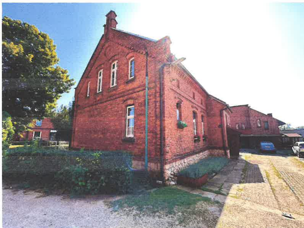
Fot. 9. Budynek plebanii, widok ogólny.
