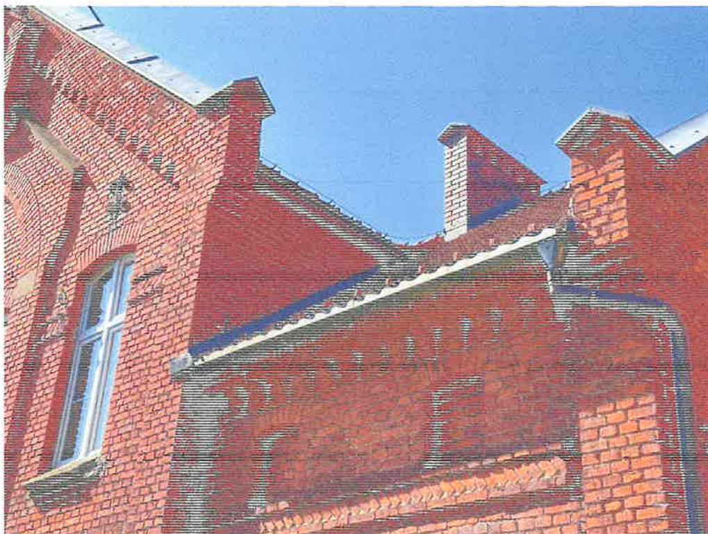
Fot. 40. Budynek plebanii, elewacja ceglana i obróbki blacharskie.
