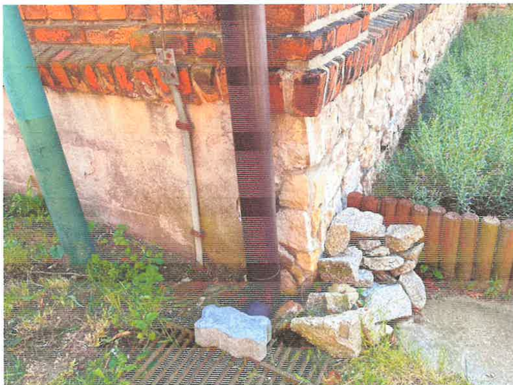
Fot. 18. Budynek plebanii, widok ogólny, cokół.
