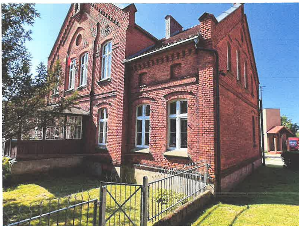
Fot. 8. Budynek plebanii, widok ogólny.
