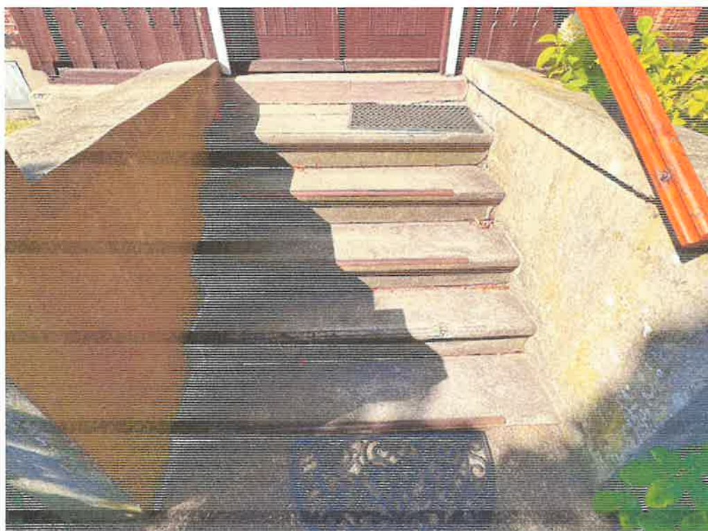
Fot. 25. Budynek plebanii, schody zewnętrzne.
