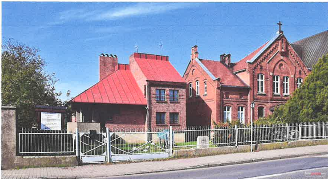
Fot. 5. Budynek plebanii, stan z 2020 roku.
