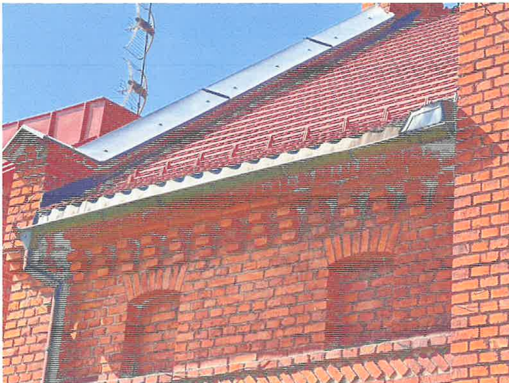
Fot. 36. Budynek plebanii, elewacja ceglana i obróbki blacharskie.
