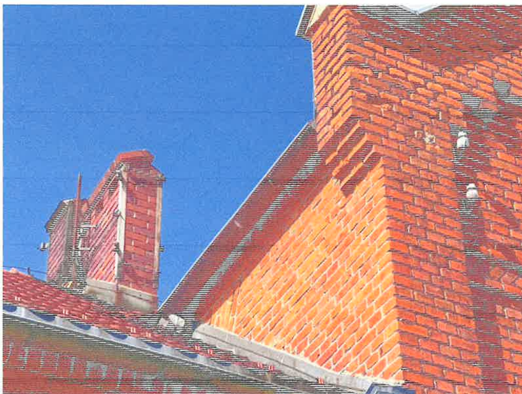
Fot. 39. Budynek plebanii, elewacja ceglana i obróbki blacharskie.
