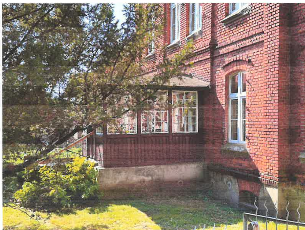
Fot. 10. Budynek plebanii, widok ogólny, wiatrołap.
