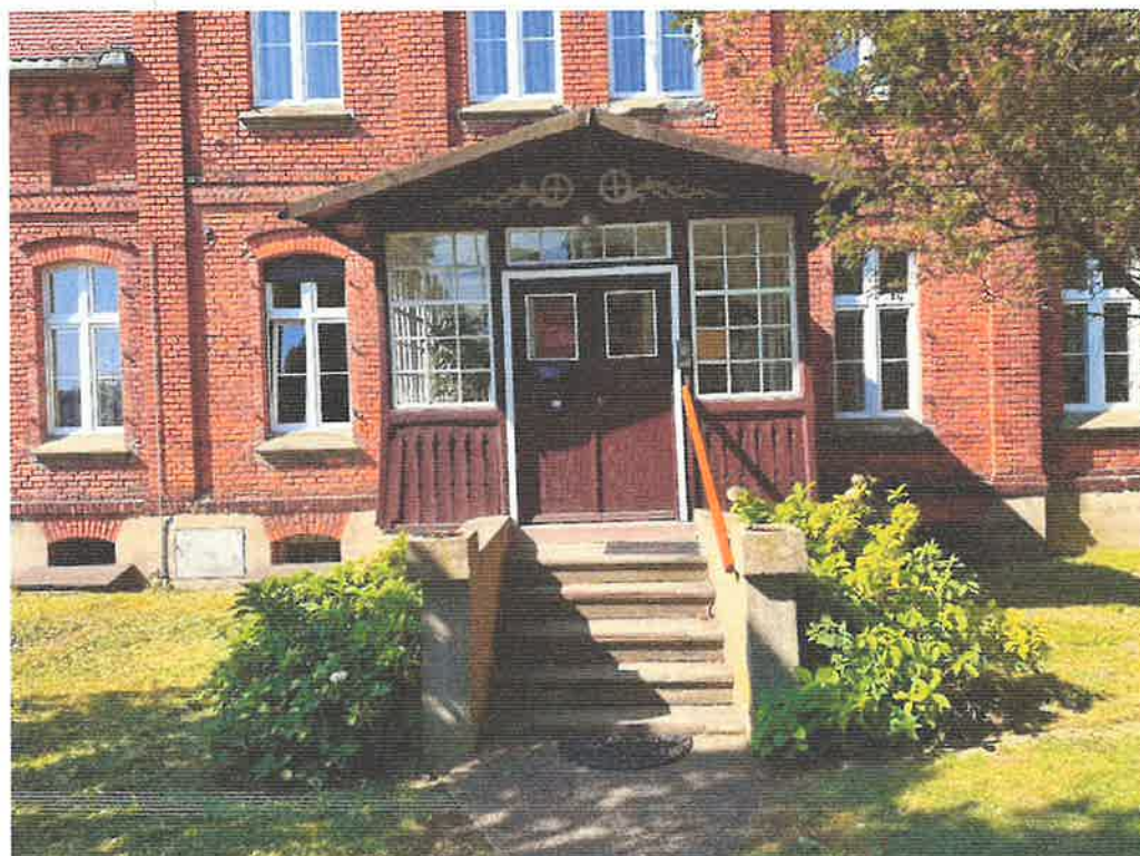
Fot. 13. Budynek plebanii, widok ogólny, wiatrołap.
