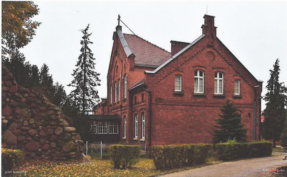
Fot. 4. Budynek plebanii, stan z 2018 roku.
