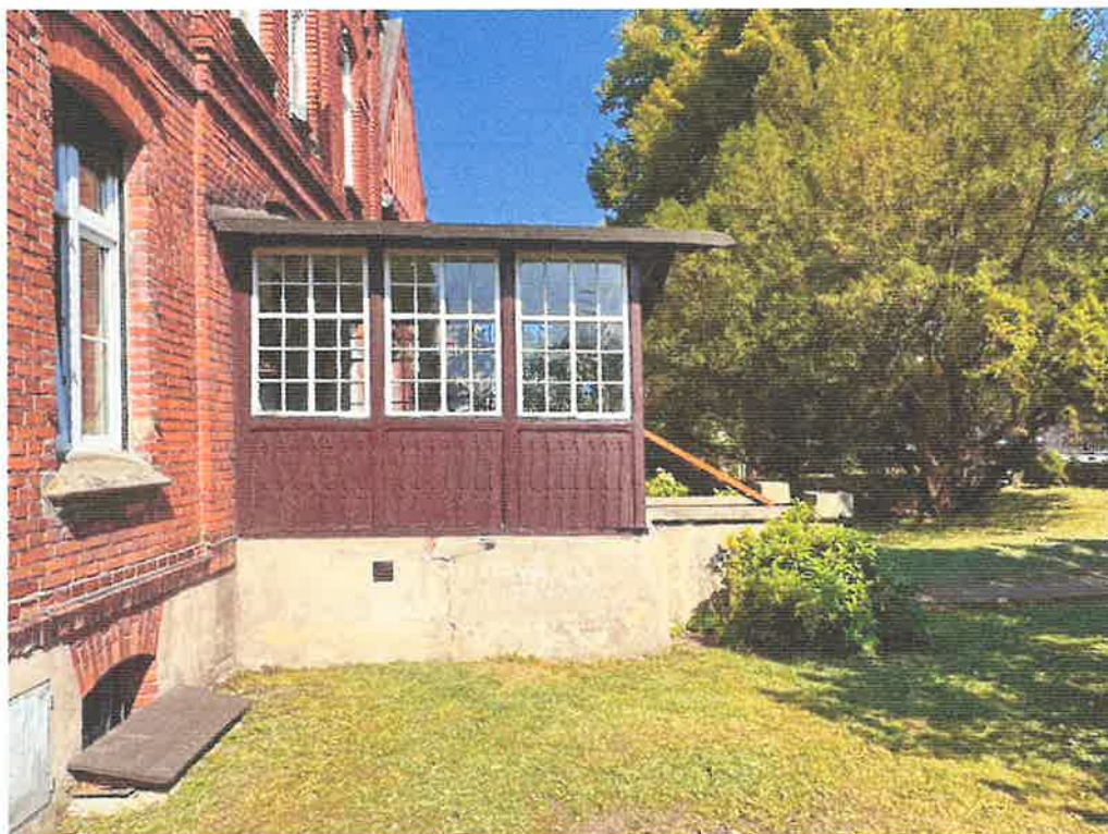
Fot. 13. Budynek plebanii, widok ogólny, wiatrołap.
