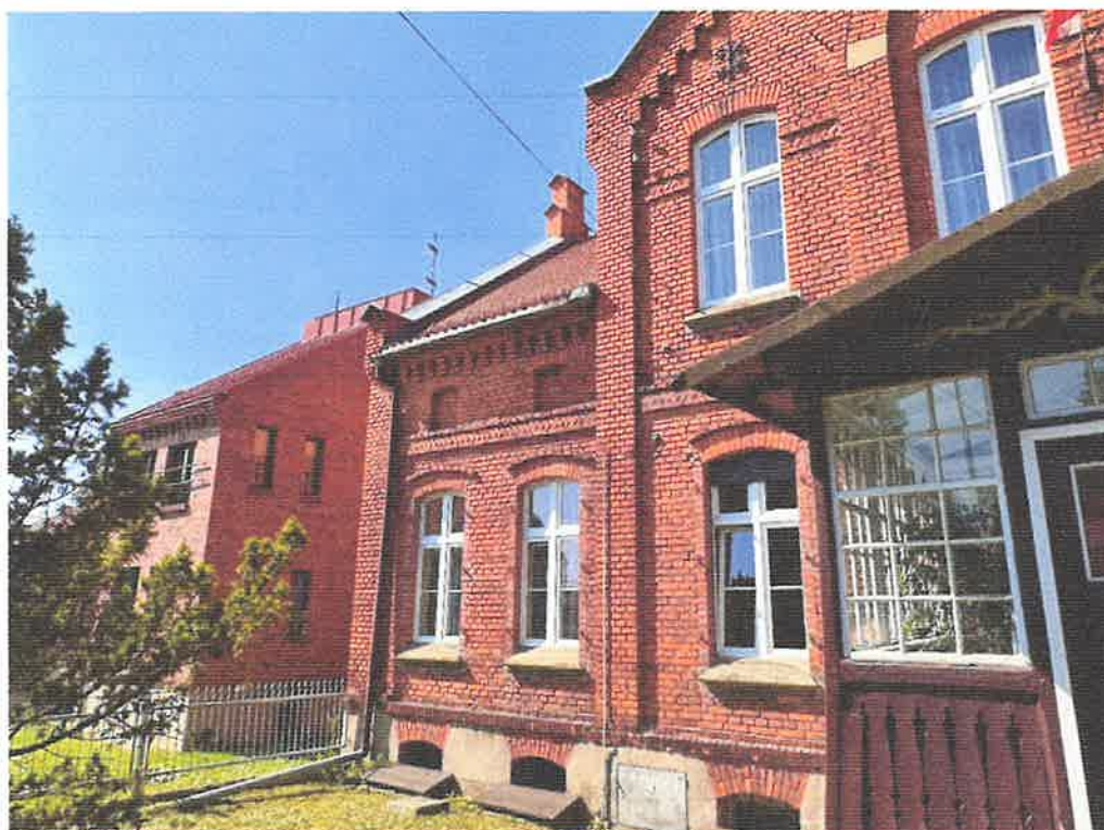
Fot. 12. Budynek plebanii, widok ogólny.
