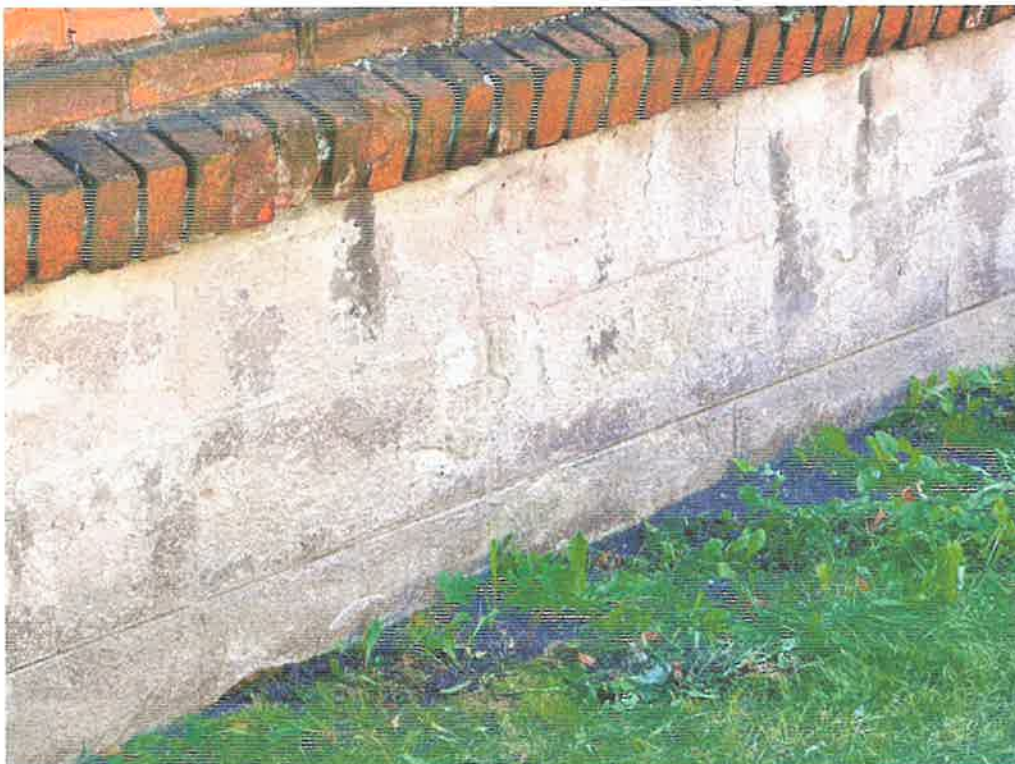
Fot. 16. Budynek plebanii, widok ogólny, cokół.
