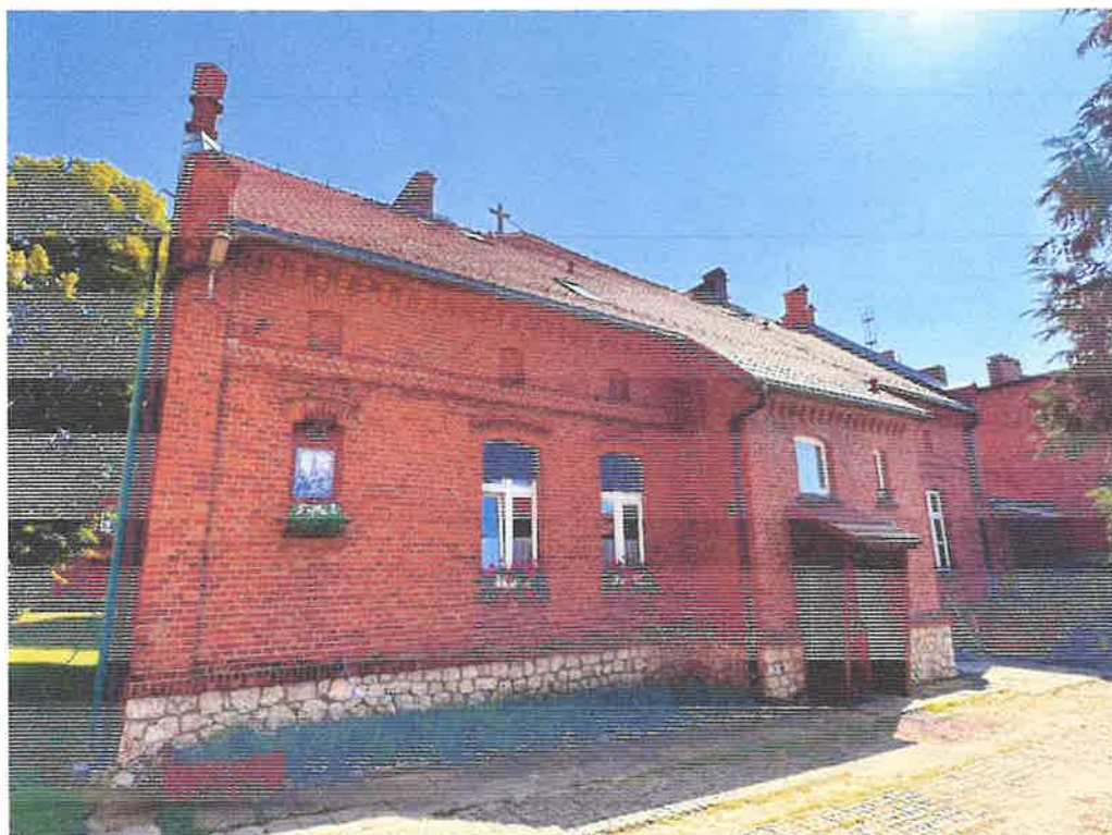
Fot. 17. Budynek plebanii, widok ogólny, cokół.
