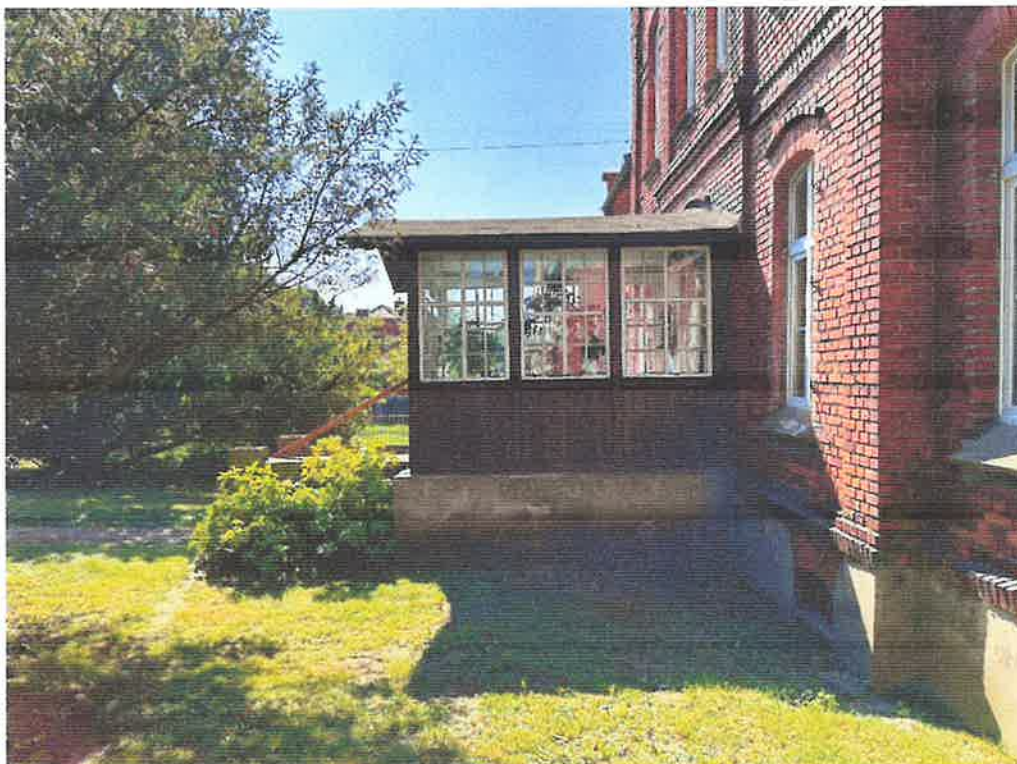
Fot. 11. Budynek plebanii, widok ogólny, wiatrolap.
