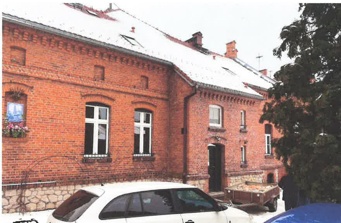
Fot. 6. Budynek plebanii, stan z 2021 roku.
