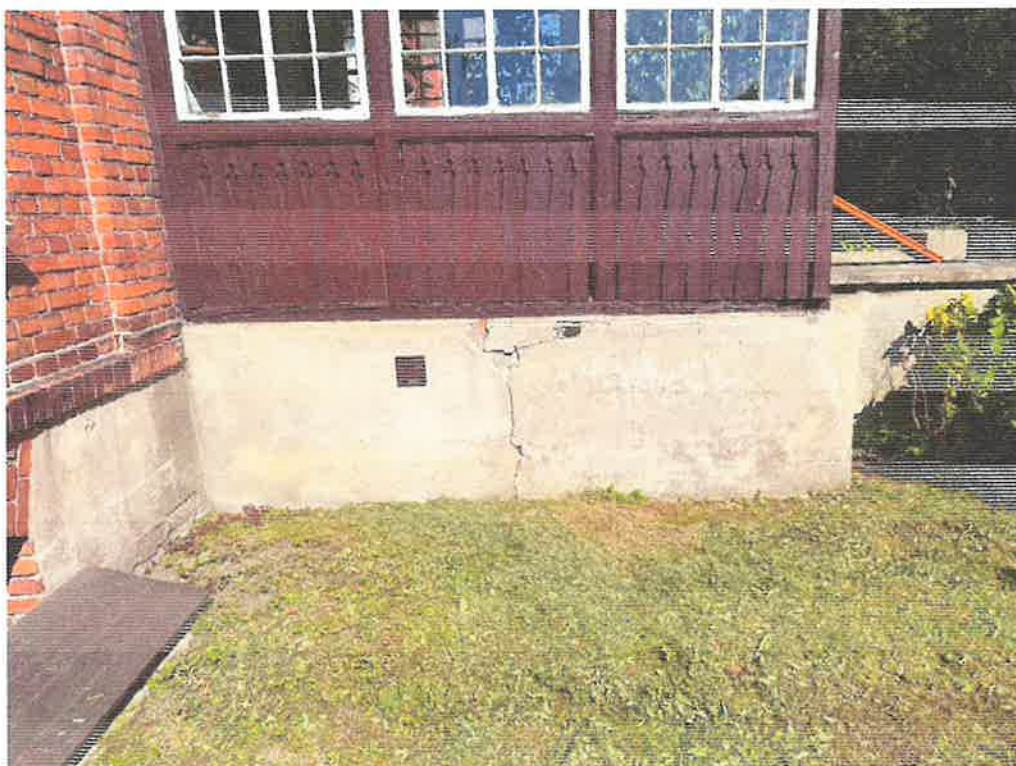
Fot. 14. Budynek plebanii, widok ogólny, wiatrolap.
