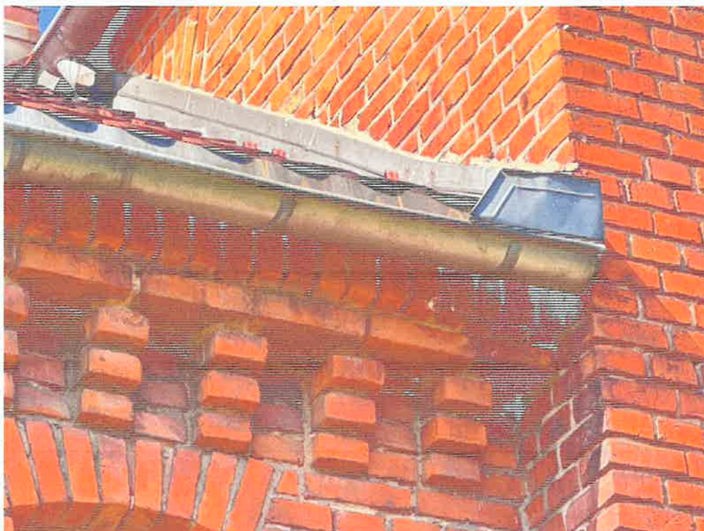
Fot. 38. Budynek plebanii, elewacja ceglana i obróbki blacharskie.
