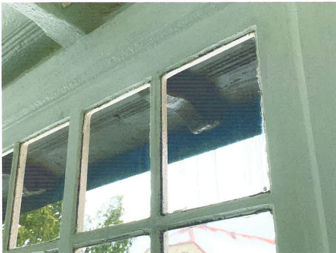
Fot. 35. Wiatrolap, widok szklenia okna.
