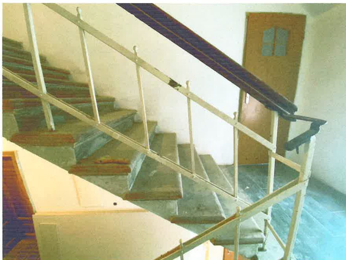
Fot. 22. Metalowa balustrada z drewnianym pochwytym.
