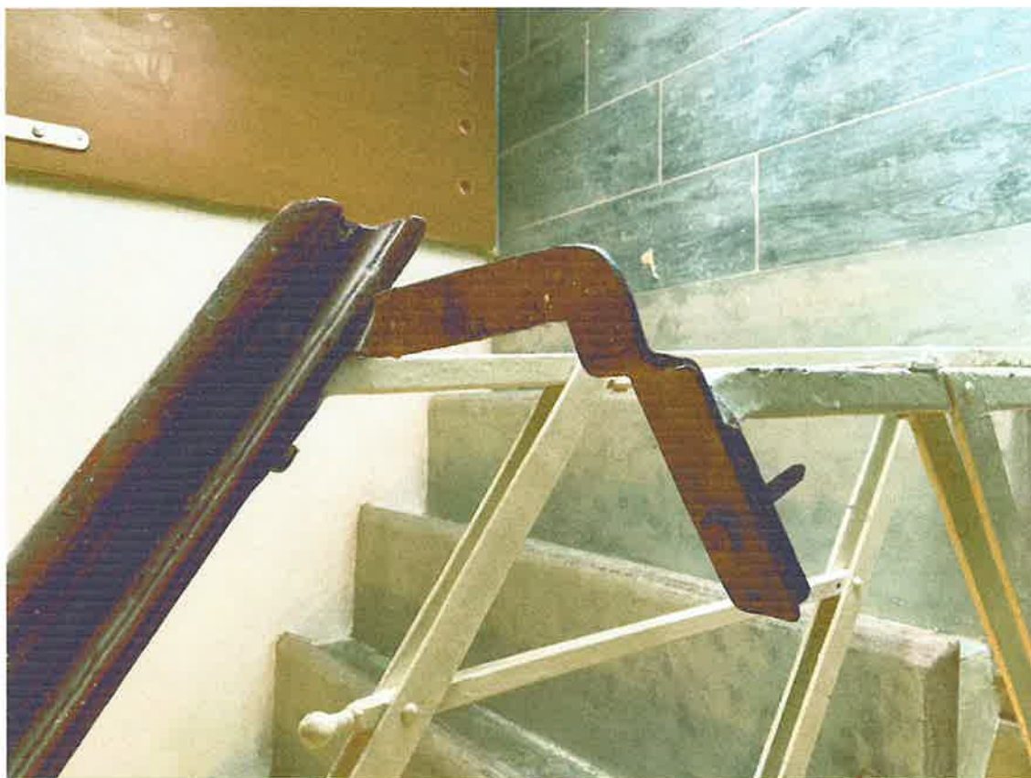
Fot. 21. Metalowa balustrada z drewnianym pochwytym.
