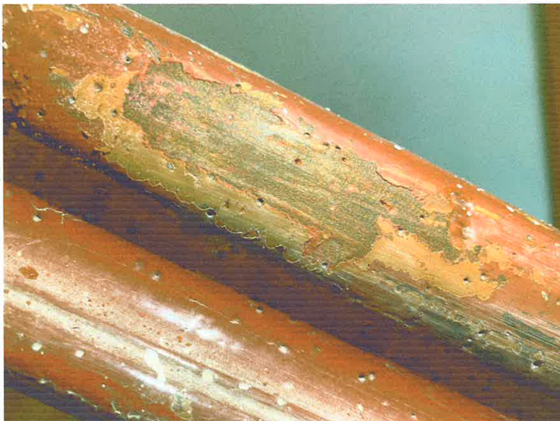
Fot. 25. Naturalna odkrywka pokazująca pierwotną kolorystykę drewnianego pochwytu (wybarwienie bejcą -brąz).
