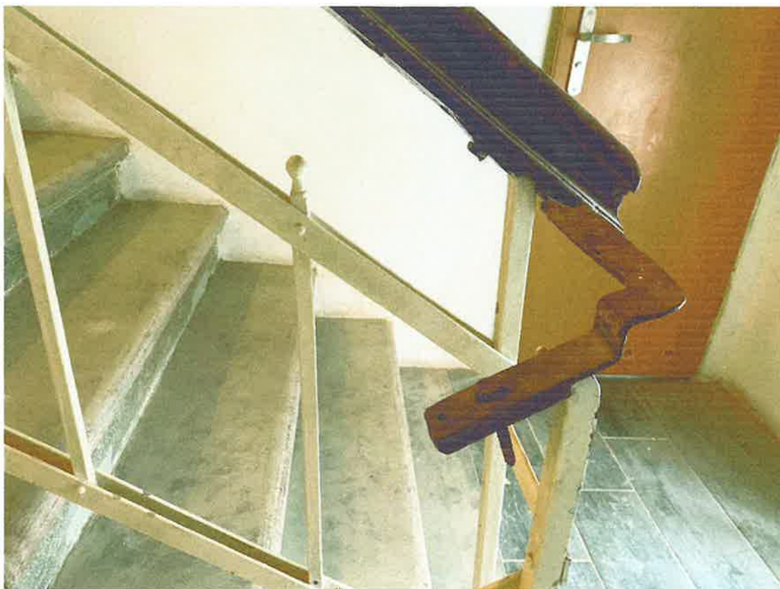
Fot. 23. Metalowa balustrada z drewnianym pochwytem.
