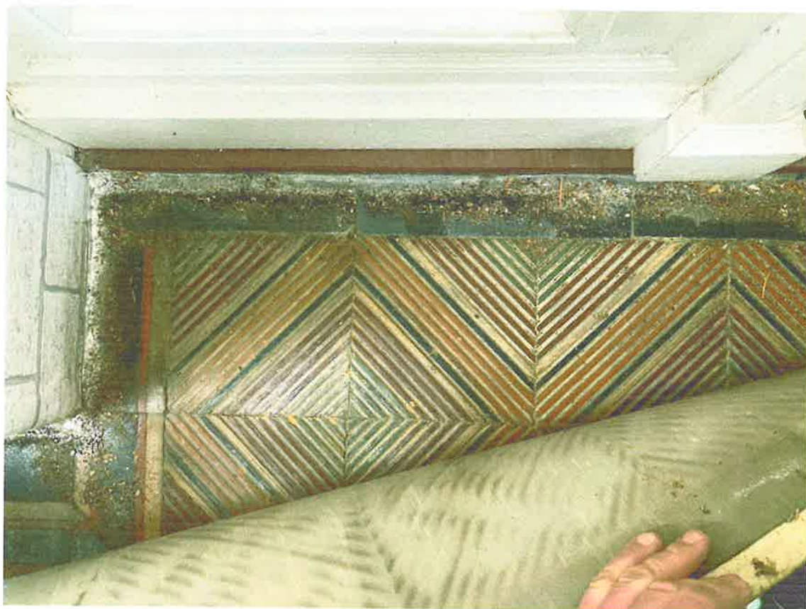
Fot. 17. Płytki w wiatrołapie na parterze plebanii. Widoczne ryflowania antypoślizgowe.
