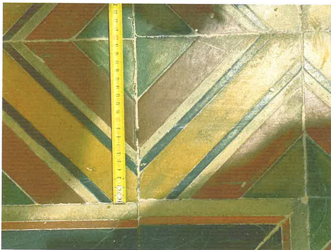
Fot. 16. Płytki w holu na parterze plebanii.
