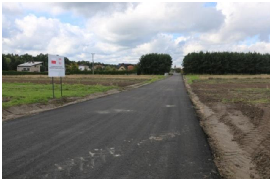
Zdjęcie 5 Budowa drogi bocznej od ulicy Dębowej do ulicy Wąskiej w miejscowości Strzebiń
