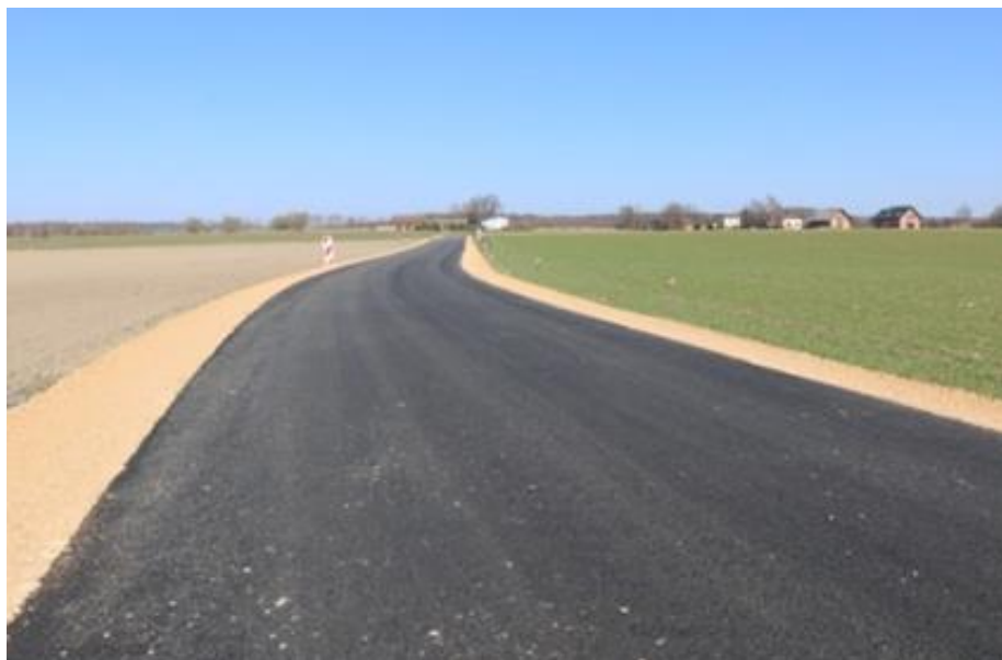
Zdjęcie 3 Przebudowa drogi gminnej w miejscowości Irki
