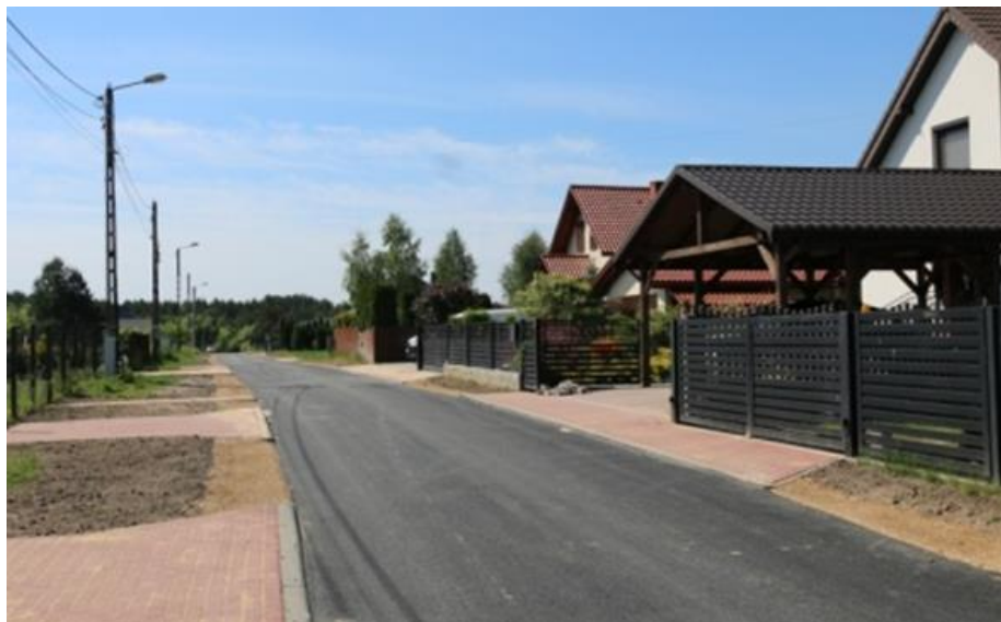
Zdjęcie 2 Przebudowa drogi gminnej ulicy Szpakowej w miejscowości Rusinowice
