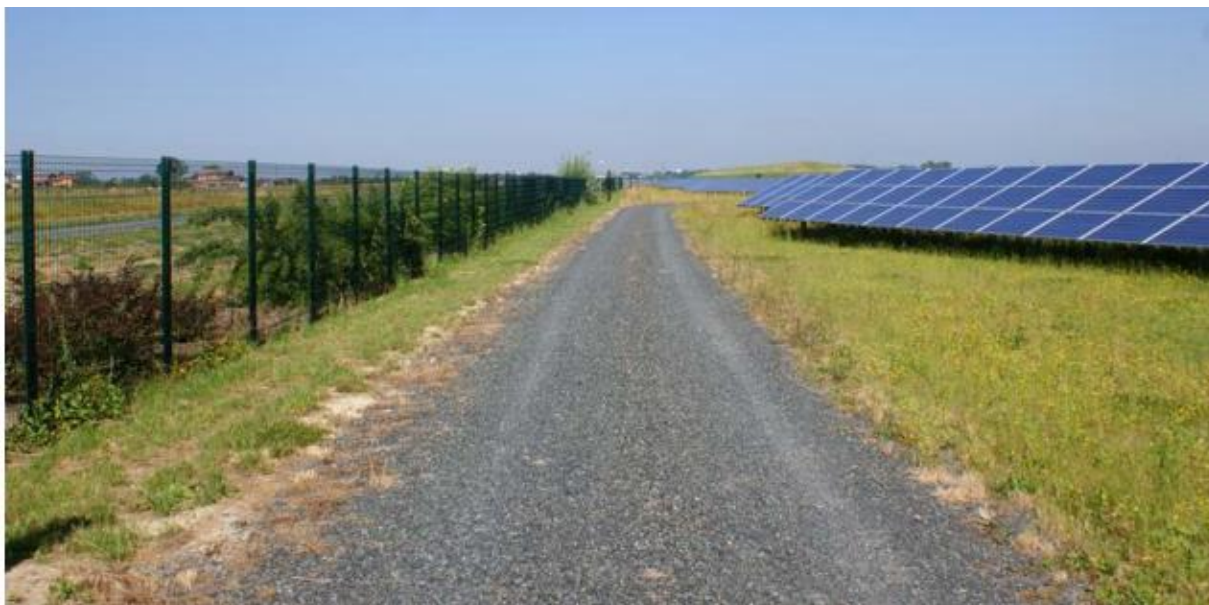
Fot. 1. Widok na przykładowe zastosowanie drogi technologicznej
