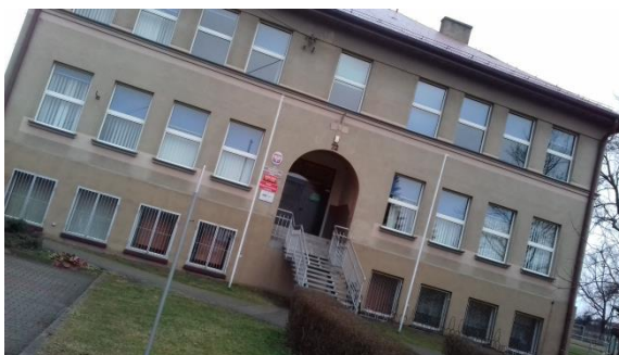
Fotografia 21 Budynek Szkoły w Sadowie
