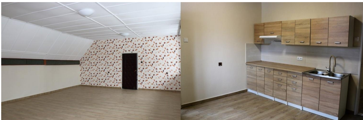
Fotografia 12 Remont dwóch pomieszczeń w budynku „Spichlerza” w miejscowości Cieszowa
