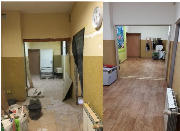
Fotografia 34 Korytarz w czasie remontu (po lewej) i po remoncie (po prawej)
