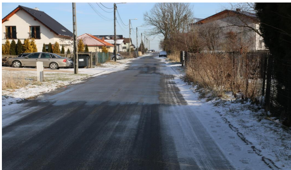
Fotografia 8 Budowa sieci sanitarnej i wodociągowej sięgaczu ulicy Miodowej w Koszęcinie
