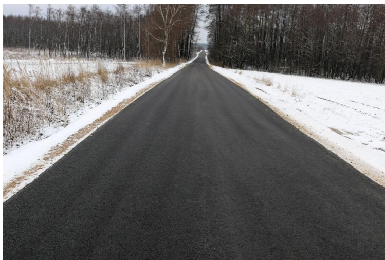
Fotografia 10 Remont nawierzchni bitumicznej drogi gminnej relacji DW906 –Nowy Dwór
