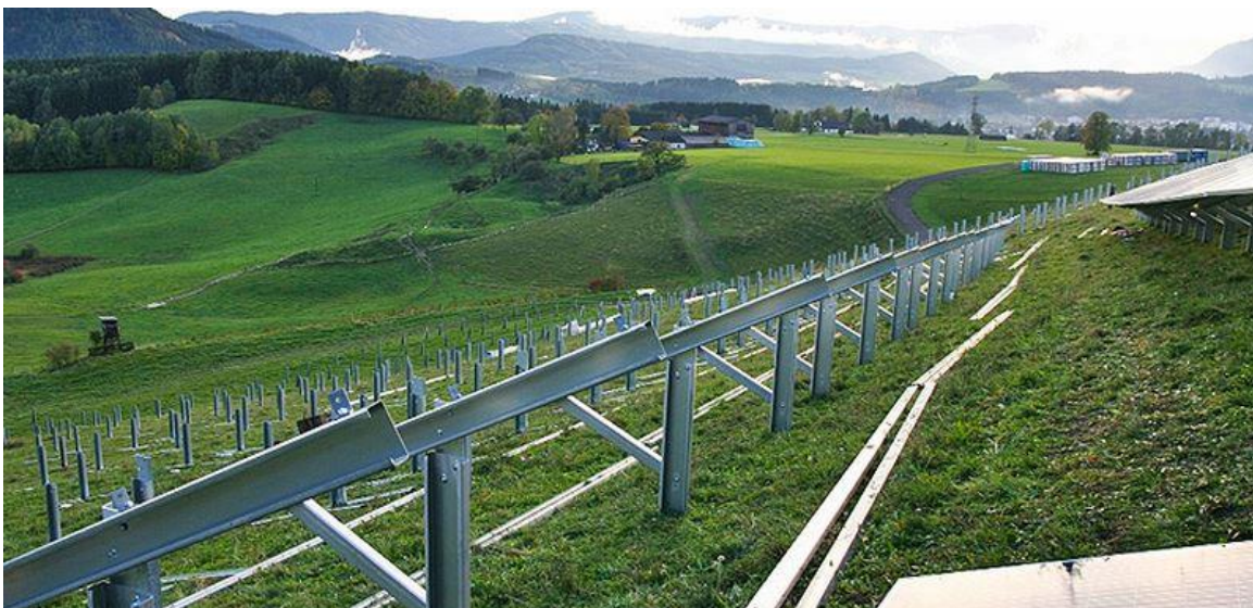
Zdjęcie 5 Konstrukcja przeznaczona do posadowienia paneli fotowoltaicznych.
