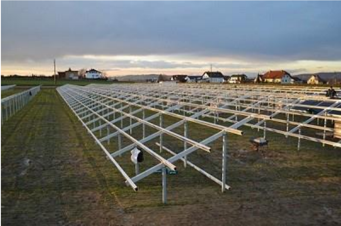
Rysunek 4 Konstrukcja wsporcza przed montażem paneli, farma solarna NIENBURG 4 MW (Niemcy) (Remor Solar).
