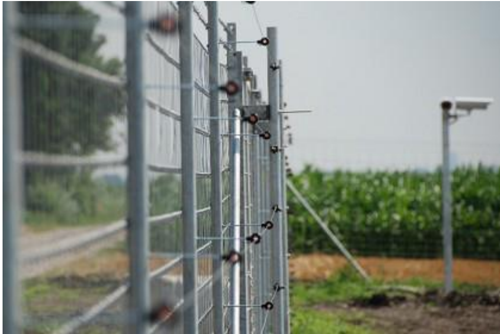
Zdjęcie 1 Przykładowe ogrodzenie farmy fotowoltaicznej
