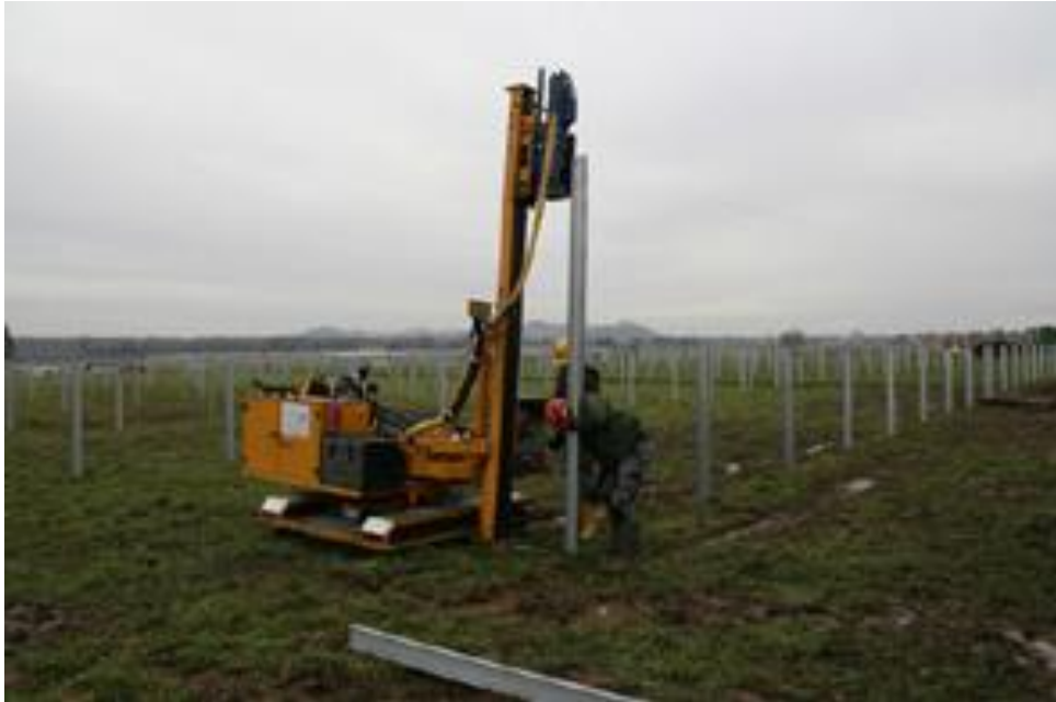
Zdjęcie 4 Montaż profili na potrzeby realizacji farmy fotowoltaicznej.
