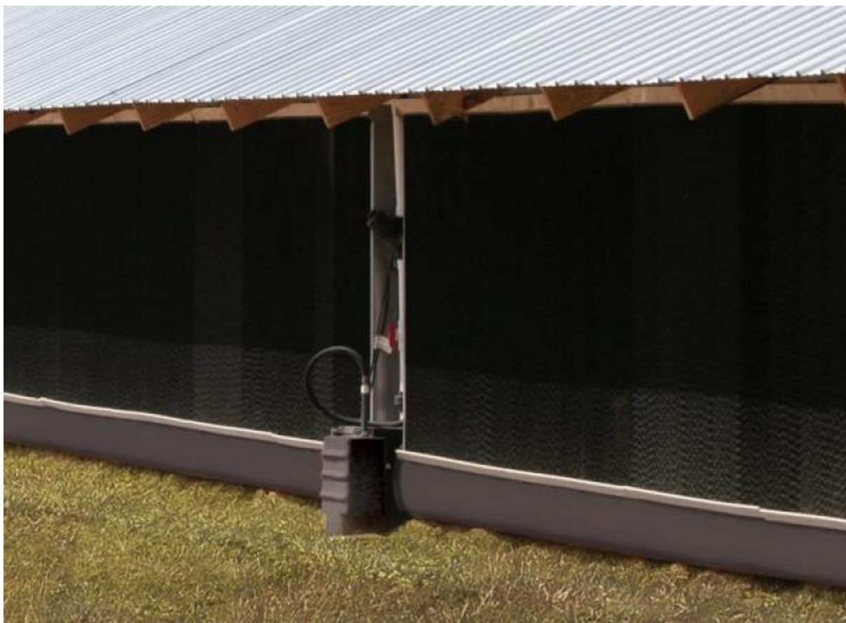
Rys. 9. System chłodzenia Pad Cooling
