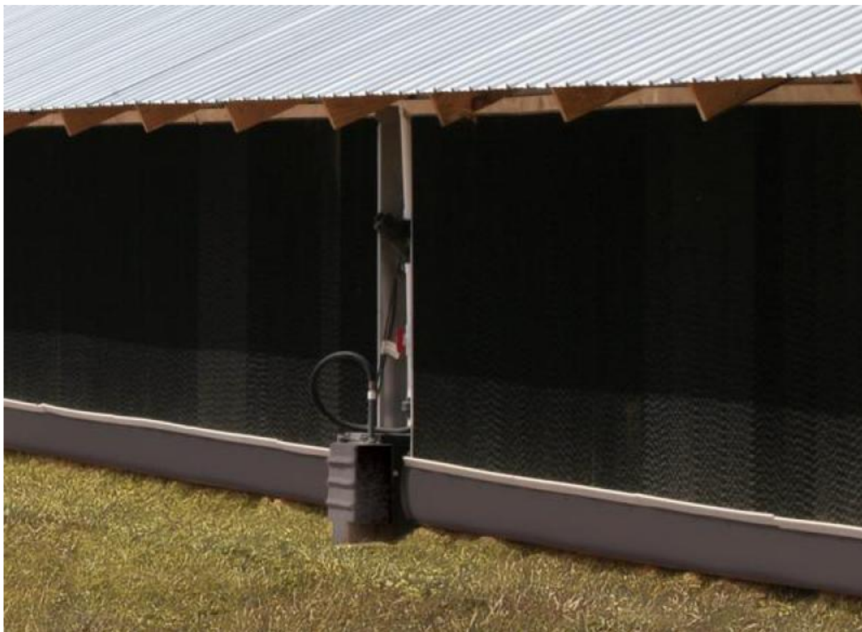
Rys. 9. System chłodzenia Pad Cooling
