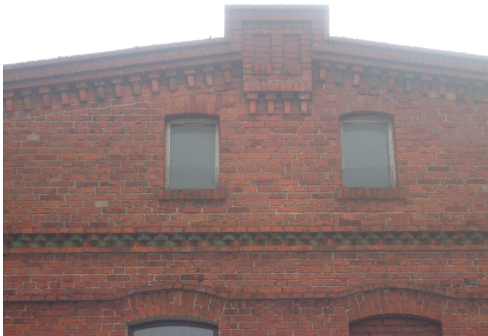
ZDJĘCIE NR 10 – elewacja północna , fragmenty szczytu, widoczne okienka strychu do renowacji
