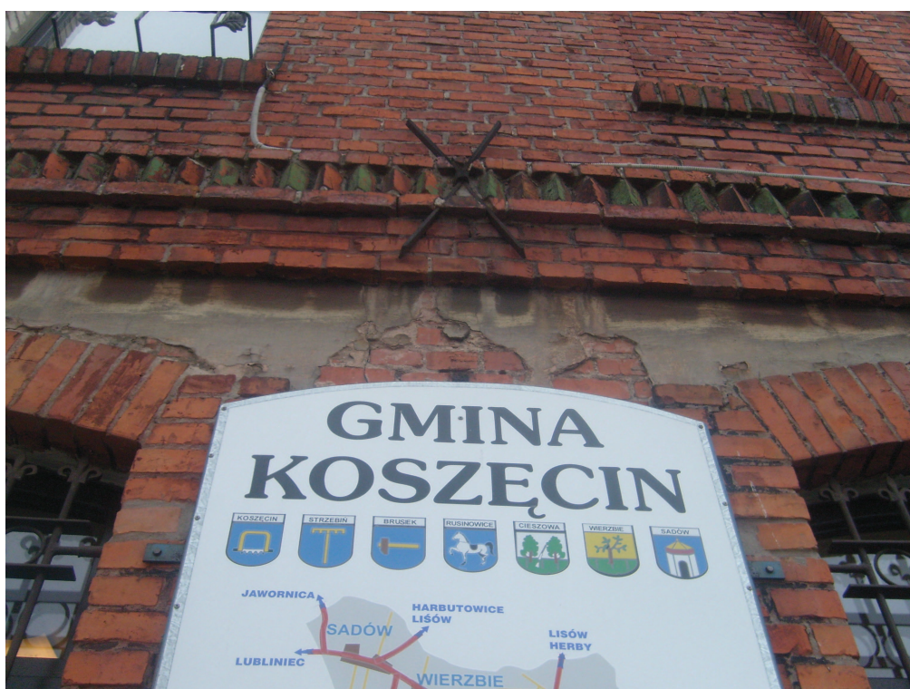
ZDJĘCIE NR 12 – elewacja północna , fragment – płycina do zlicowania ze ścianą główną
