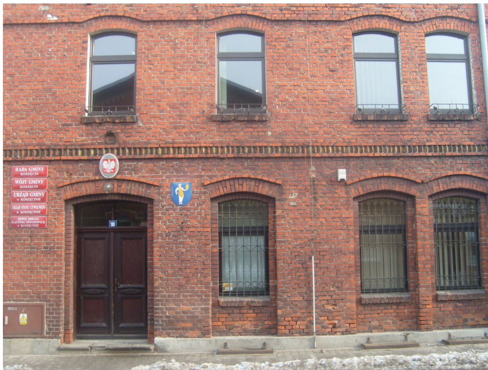
ZDJĘCIE NR 3 – widok od strony zachodniej , kolejny fragment elewacji frontowej widoczne drzwi wejściowe do budynku, drzwi przeznaczone do odrestaurowania
