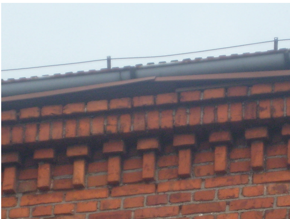
ZDJĘCIE NR 5 – widok od strony zachodniej , detale górnej części elewacji – pas podrynnowy
