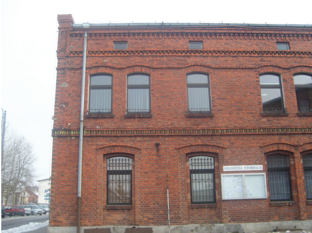
ZDJĘCIE NR 1 – widok od strony zachodniej , fragment elewacji frontowej
