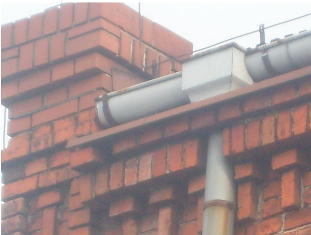
ZDJĘCIE NR 7 – północno- zachodni narożnik elewacji frontowej, detale górnej części elewacji – pas podrynnowy, widoczne przejście rury spustowej przez gzyms
