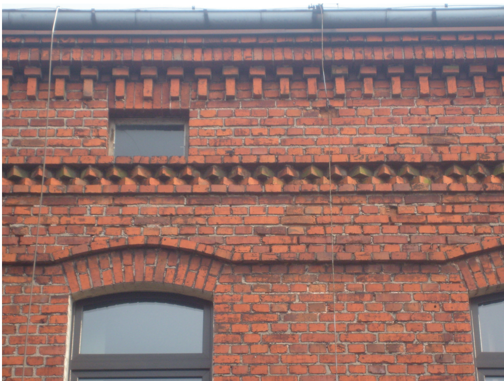
ZDJĘCIE NR 5 – widok od strony zachodniej , detale górnej części elewacji – pas podrynnowy
