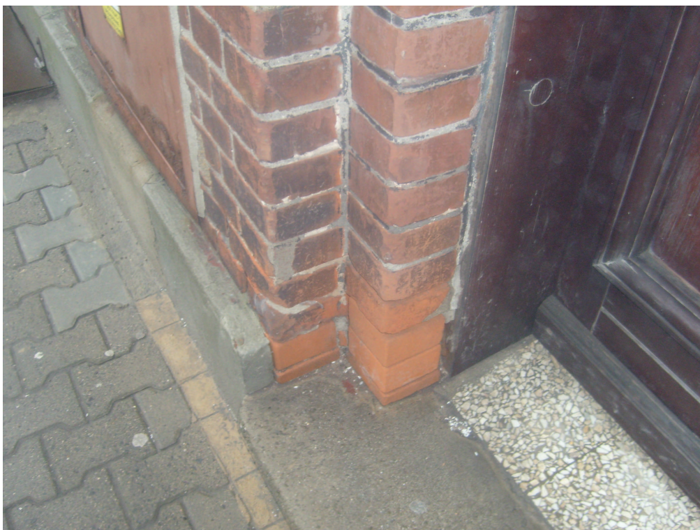
ZDJĘCIE NR 11 – detal, fragment stopnicy i osadzenia drzwi strona lewa
