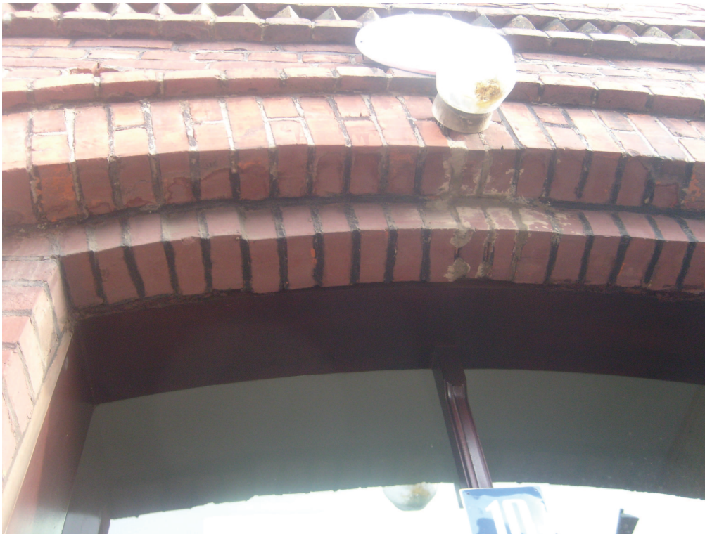
ZDJĘCIE NR 9 – detal, nierówne nadproże nad drzwiami wejściowymi do budynku
