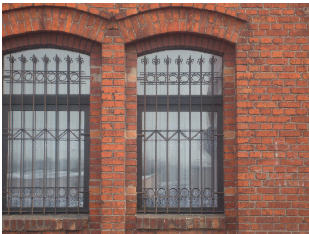
ZDJĘCIE NR 14 – okna elewacji zachodniej, kraty do wyczyszczenia i po wymianie okien na nowe w poziomie parteru do ponownego montażu
