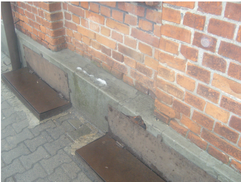
ZDJĘCIE NR 13 – północno- zachodni fragment elewacji frontowej widoczne zabezpieczone metalowymi blachami zsypy do piwnicy, blachy do demontażu , wymiany i ponownego montażu po wykonaniu okładziny cokołu
