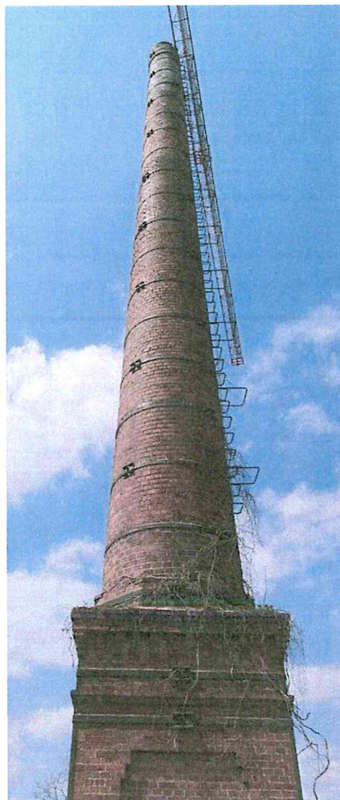
Widok komina od strony wschodniej.
