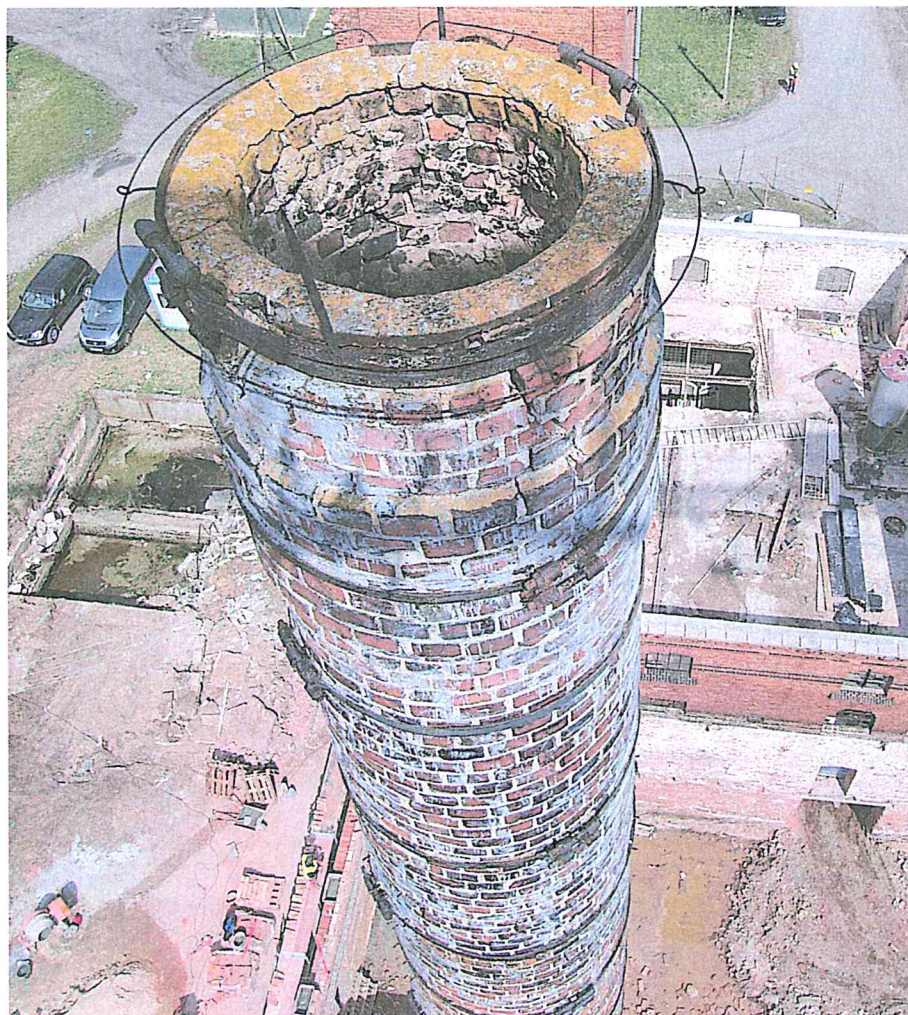
Widok komina od strony południowej.
