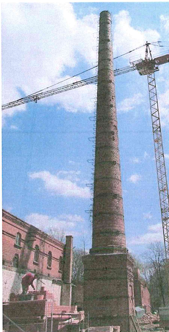
Widok komina od strony zachodniej.
