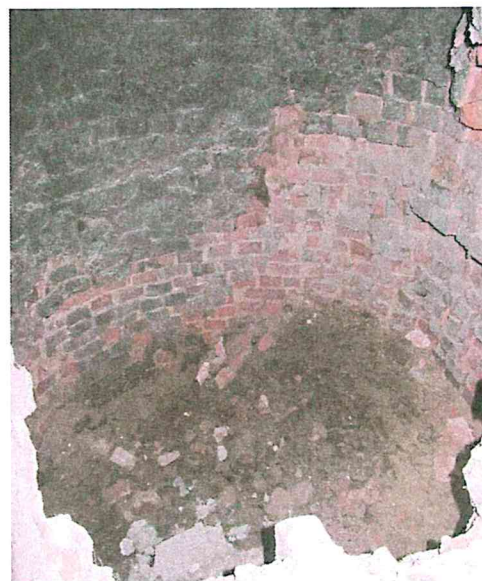
Widok środka komina w dolnej części
