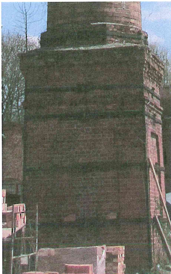
Widok dolnej części komina od strony zachodniej.
