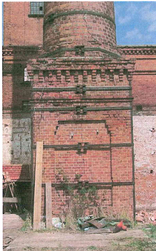
Widok dolnej części komina od strony południowej.
