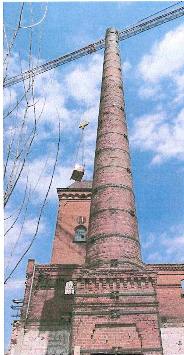
Widok komina od strony południowej.
