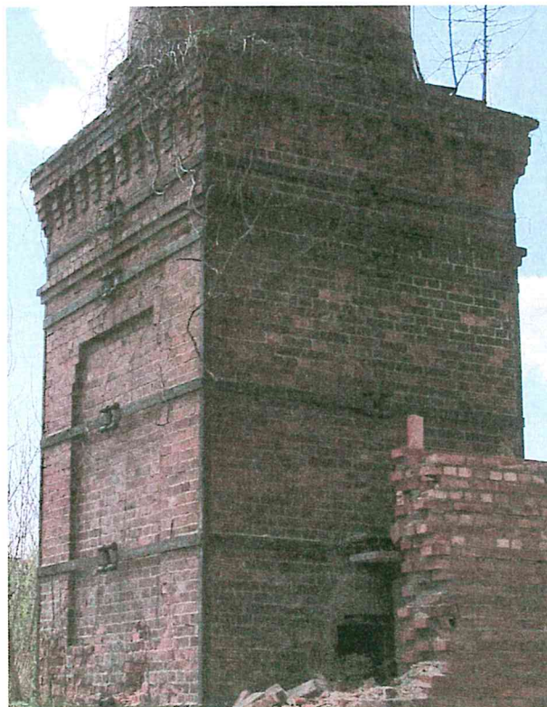
Widok dolnej części komina od strony północno-wschodniej.
