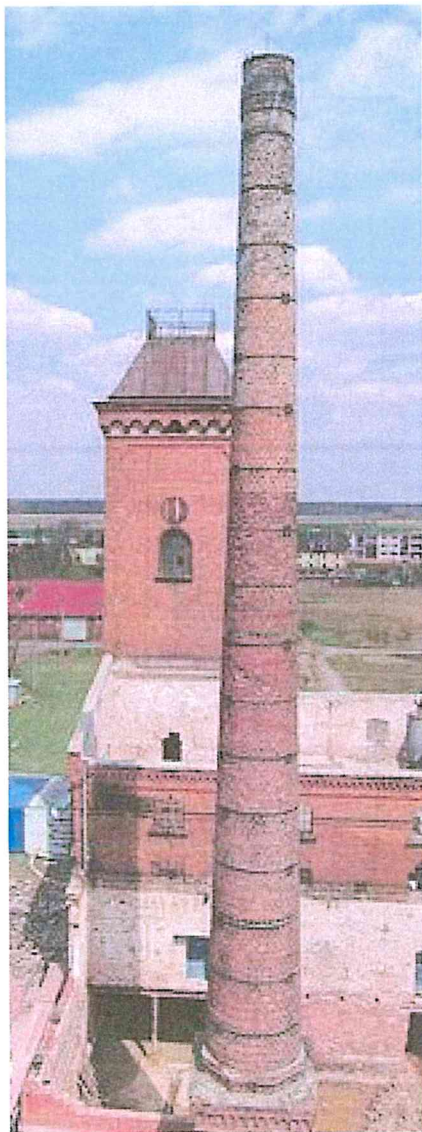
Widok komina od strony południowej.
