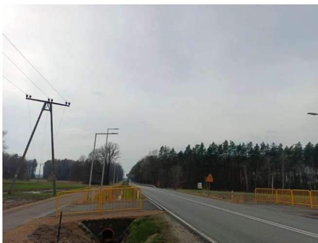
Fot. Ścieżka pieszo – rowerowa w Kochanicach – autor. M. Bagińska
