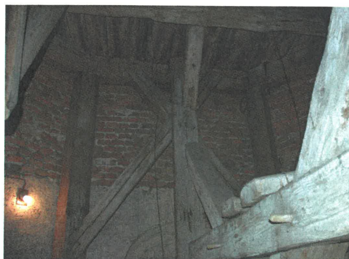
Konstrukcja wieży (poziom 3)
