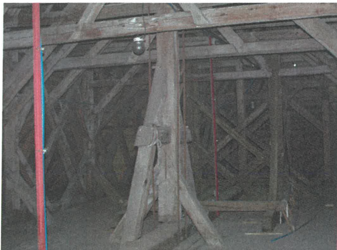
Widok więźby, słup centralny (król)
