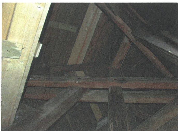
Konstrukcja kopuły
