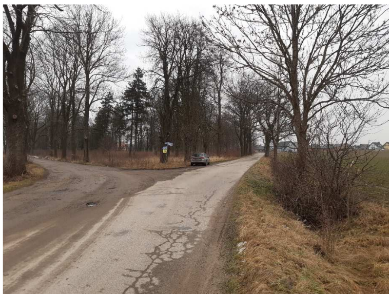
Fot 4. Istniejąca ul. Ogrodowa odc.2 – skrzyżowanie z ul. Zamkową – koniec odcinka.
