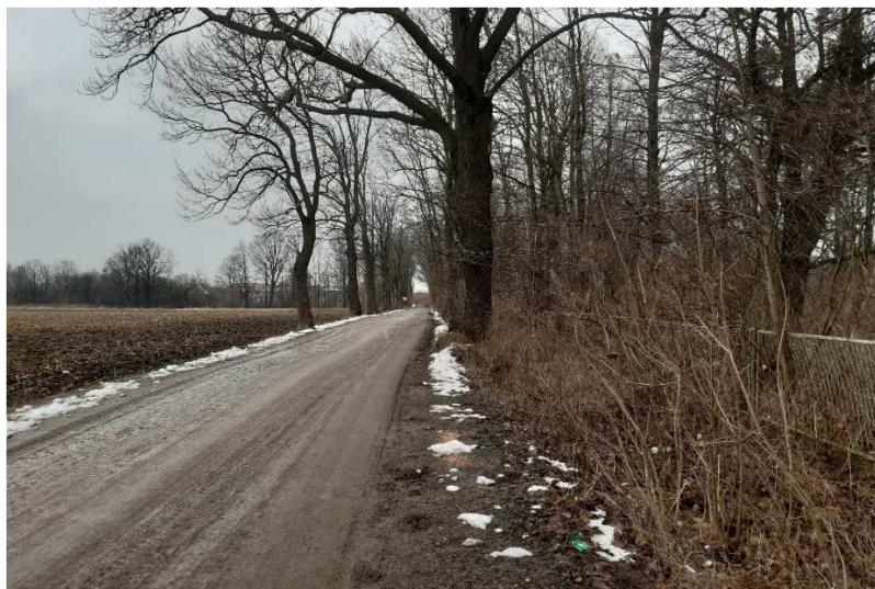
Fot 3. Istniejąca ul. Ogrodowa odc.2 – widok w kierunku placu starej gorzelni.
