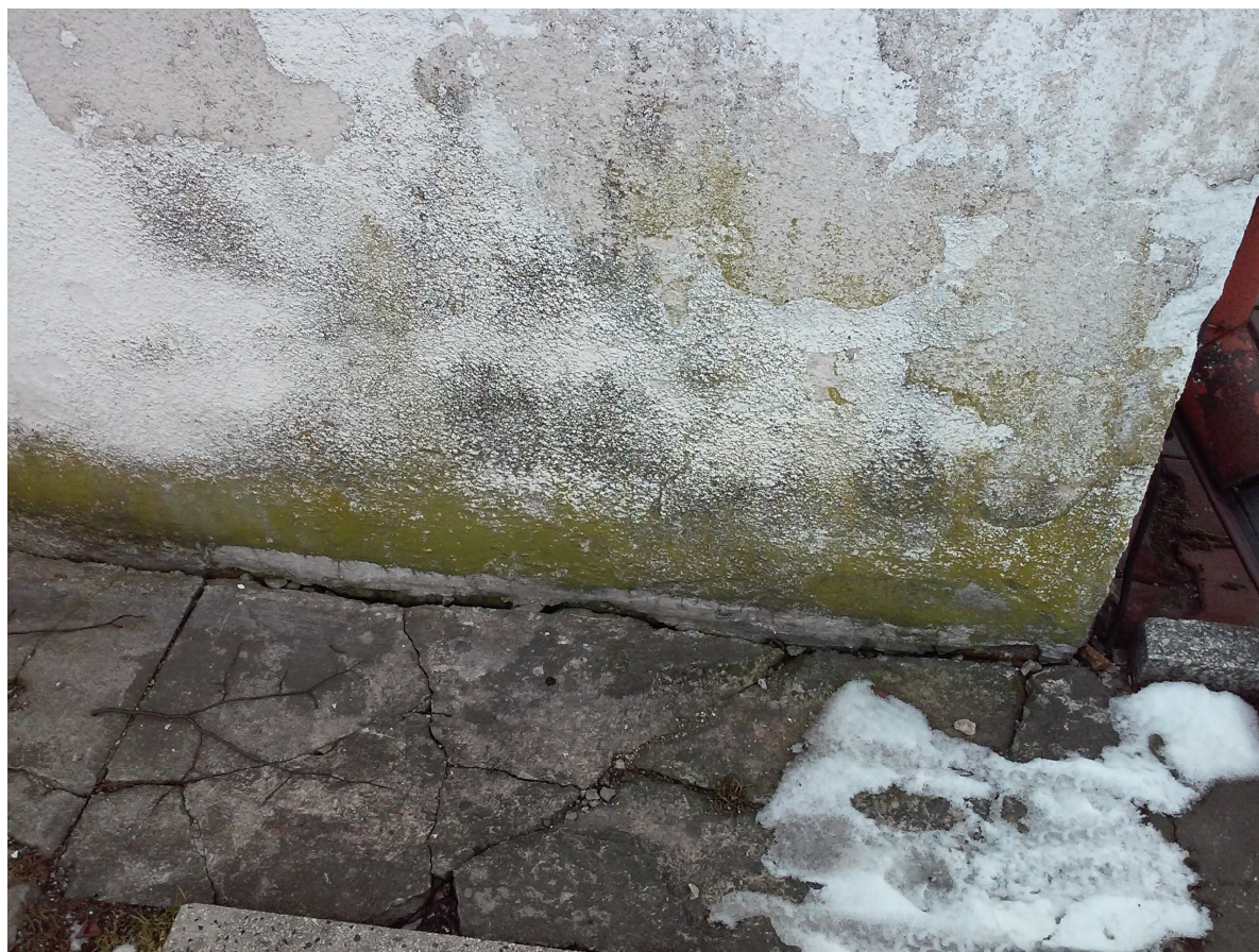
Fot.1 Widoczne zagrzybienia ściany zewnętrznej oraz łuszczenie się tynku.
