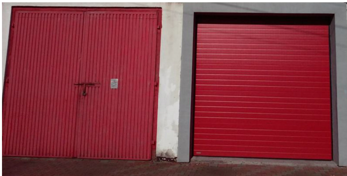
Fot.2 Stara (po lewej) oraz wymieniona (po prawej) brama garażowa.
