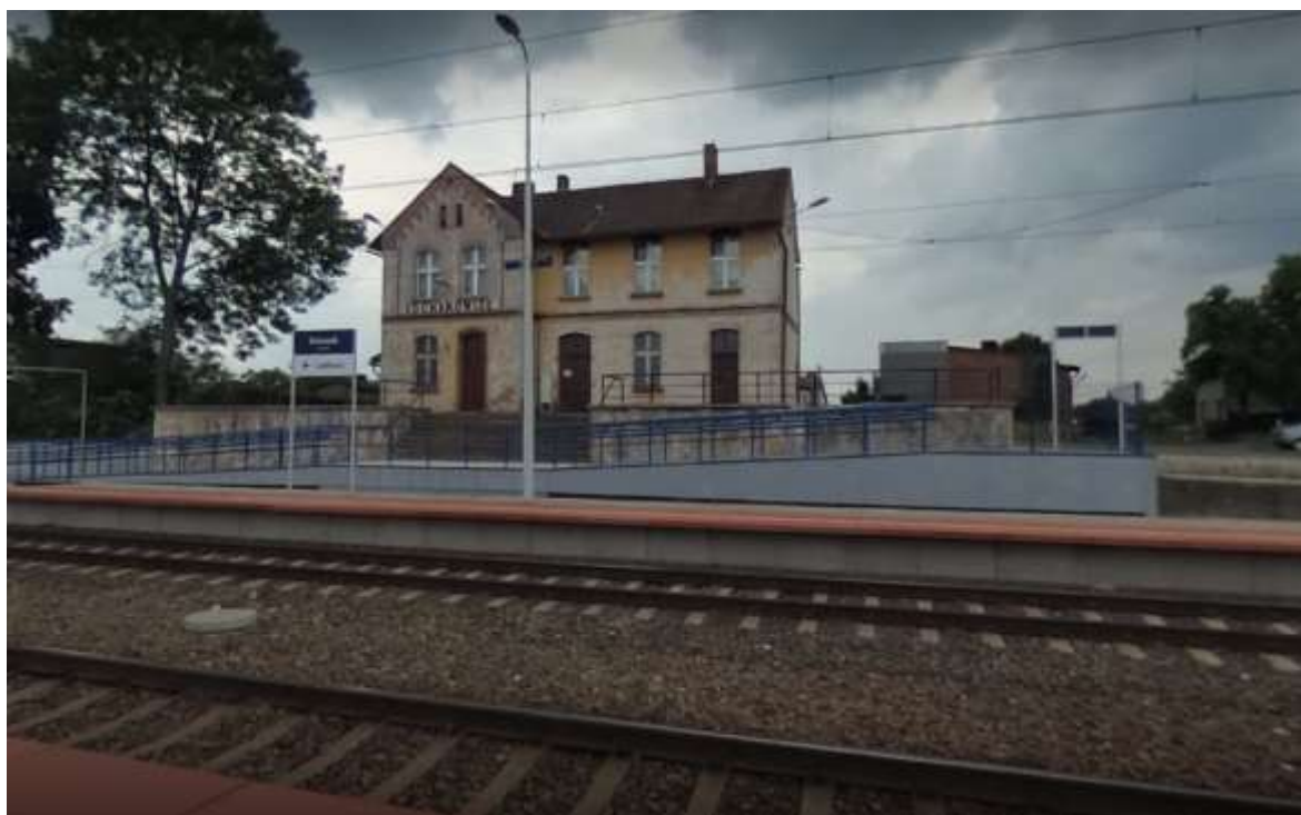
Rysunek 5 Stacja kolejowa w Kochanowicach
