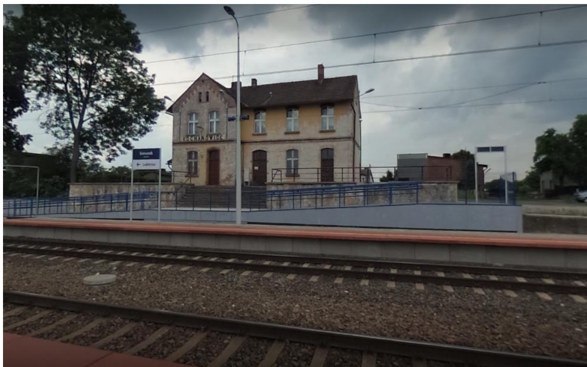
Rysunek 5 Stacja kolejowa w Kochanowicach
