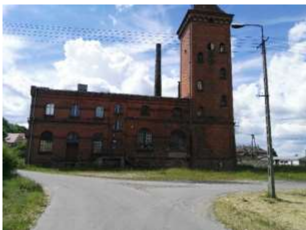
Budynek byłej gorzelni
