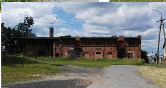
Źródło: Zdjęcia własne z przeprowadzonej wizji lokalnej.
