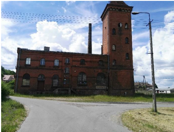
Budynek byłej gorzelni
