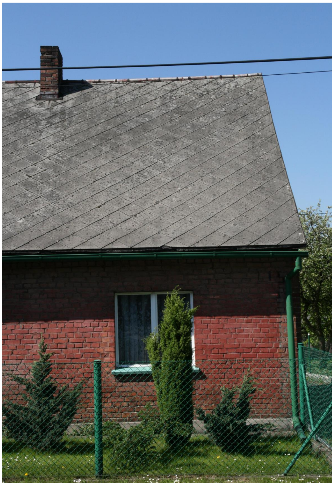
Rysunek 3 Dach budynku mieszkalnego pokryty płytami azbestowymi płaskimi
