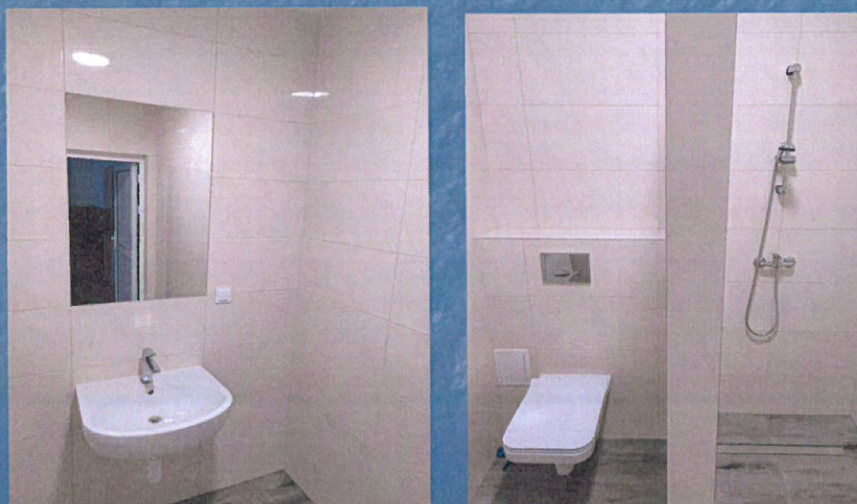
Pomieszczenia sanitarne po remoncie.
