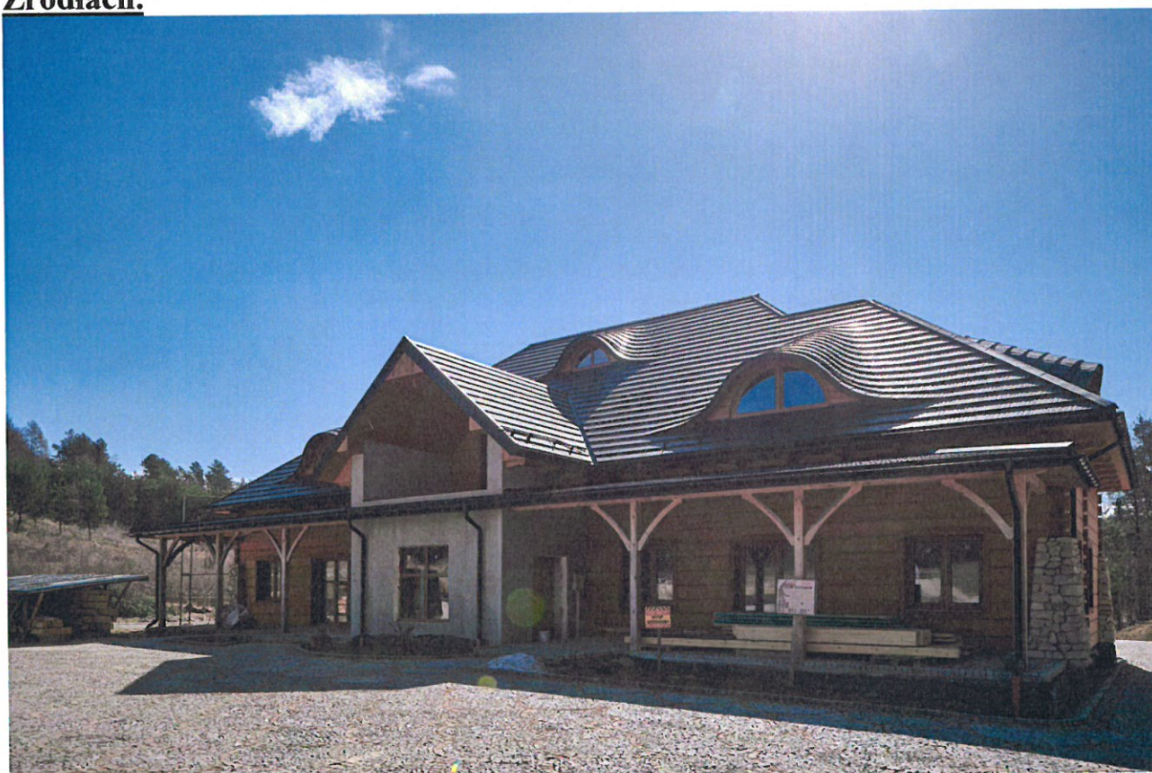
Chata Pielgrzymia w budowie.
