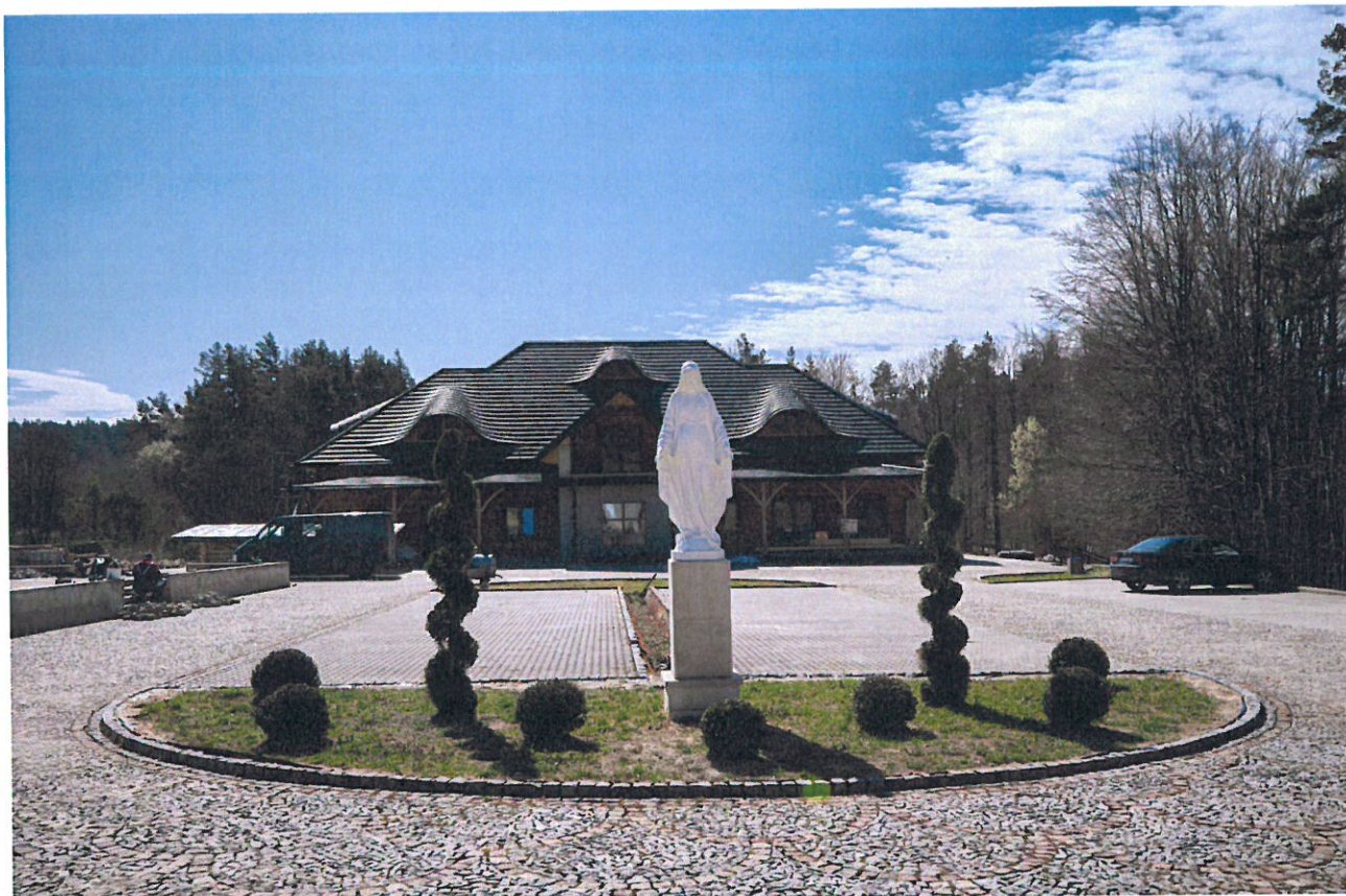
Chata Pielgrzymia w budowie oraz parking przy zejściu do Kapliczki na Źródłach.
