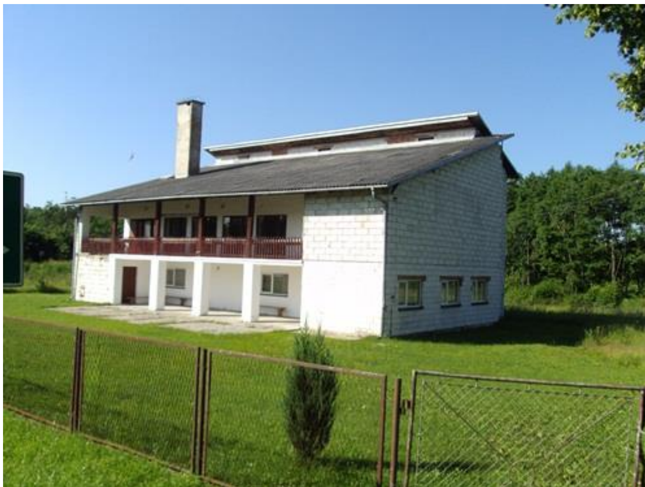
Fot. 18 Budynek Wiejskiego Domu Kultury w Werchracie
