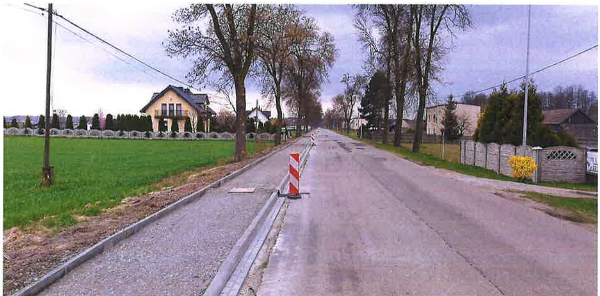
Budowa drogi rowerowej Chwostek – Hadra
