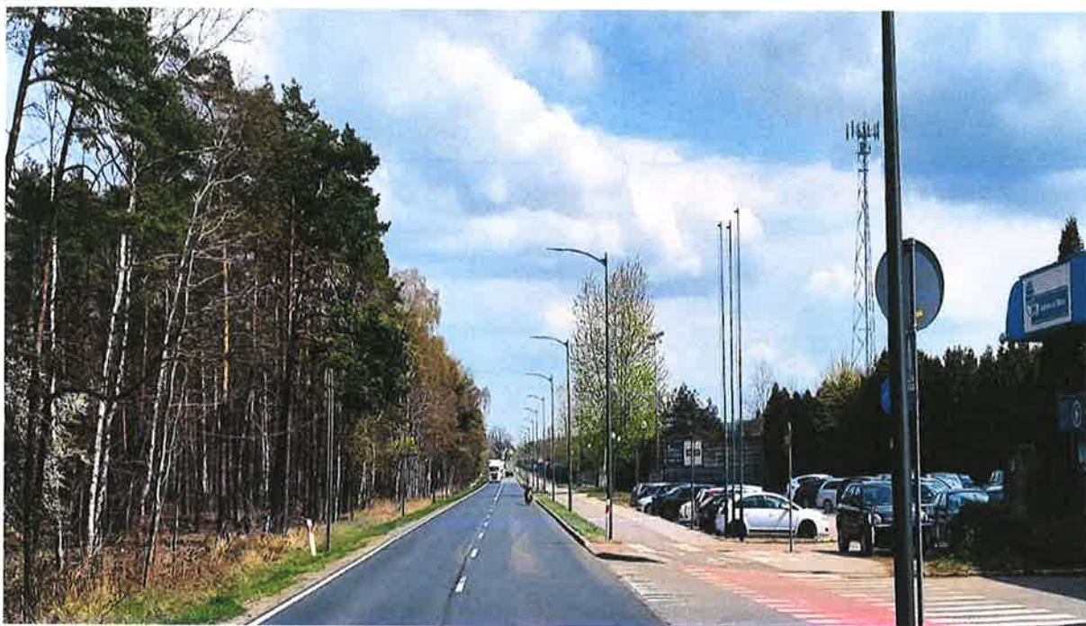
Oświetlenie uliczne przy ul. Lublinieckiej w Herbach
