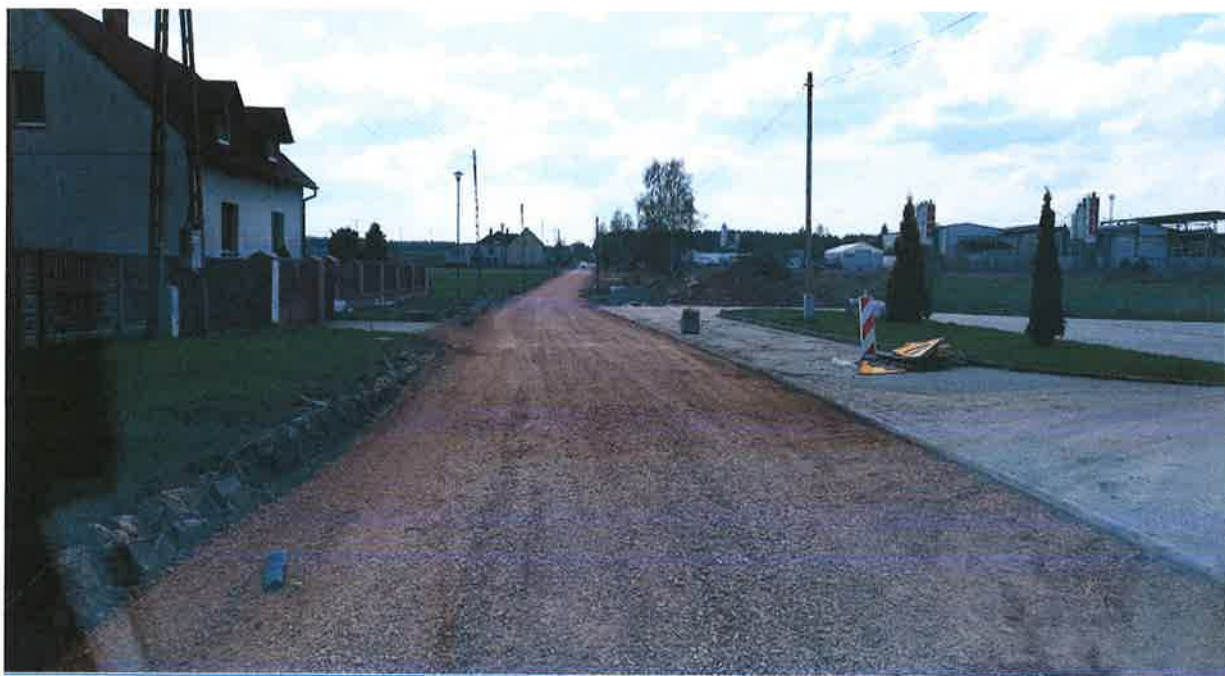
Prace przy modernizacji ul. Przemysłowej w Lisowie
