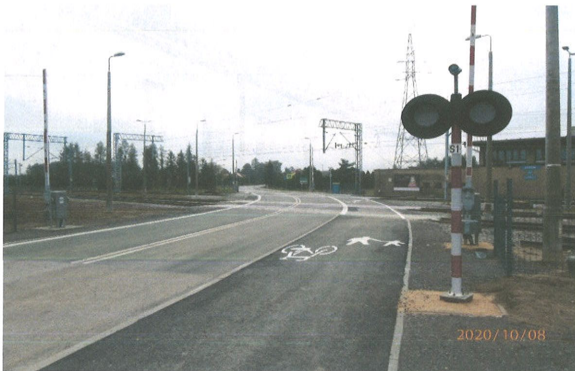
Droga rowerowa Lisów – Chwostek na przejeździe kolejowym w Lisowie
