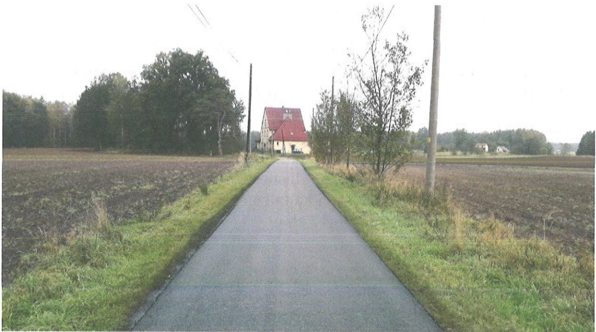
Droga do Braszczoka po modernizacji.
