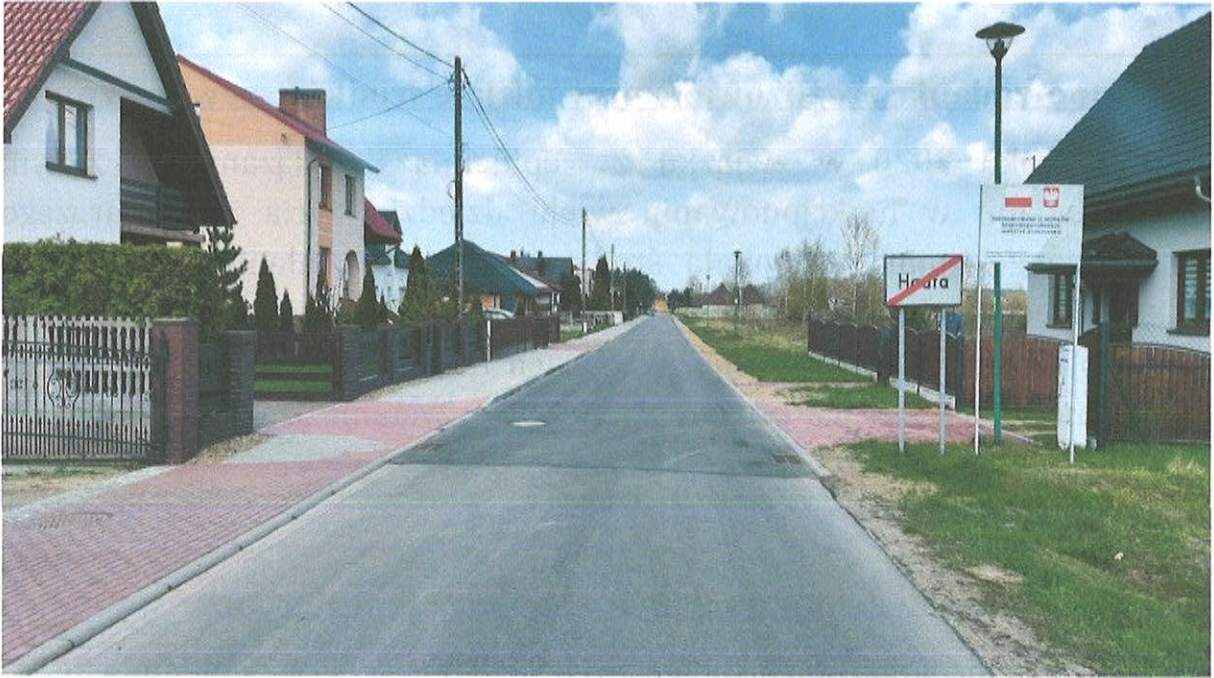
Ulica Fabryczna w Mochali po przebudowie.
