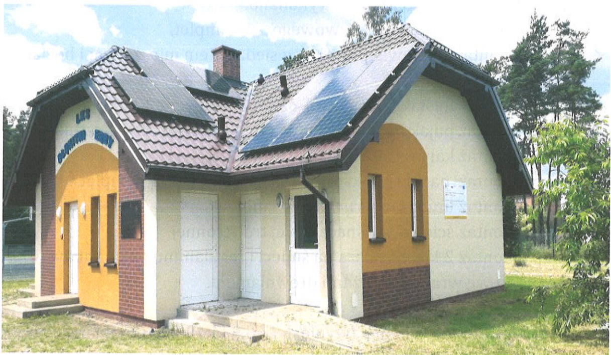
Panele fotowoltaiczne na budynku sportowców w Herbach
