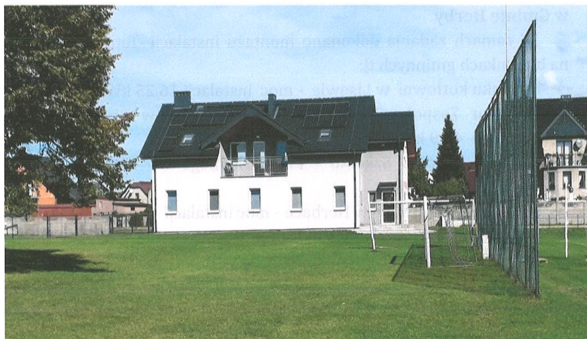
Panele fotowoltaiczne na budynku sportowców w Lisowie
