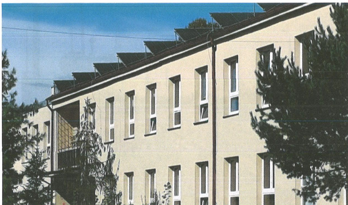
Panele fotowoltaiczne na budynku Zespołu Szkolno – Przedszkolnego w Lisowie
